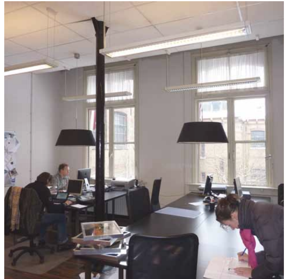
Afbeelding 109. Overzicht van ruimte F1.27 gezien richting het westen. Doordat het gebruik van de bovenverdieping veranderde, besloot men de ruimte te splitsen (1949) en de hoog geplaatste kleine vensters te verlengen (zie Afbeelding 143).
