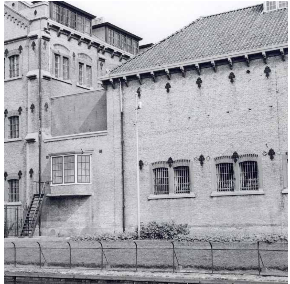
Afbeelding 21. Foto van de zuidgevel van de grachtvleugel van bouwdeel D en aan de linkerkzijde de zuidgevel van de uitbouw met de voormalige strafcellen in de periode 1970-75. De erker in de zuidgevel van de uitbouw is mogelijk een wachterspost en kan tijdens de grote verbouwing in 1948 tot stand zijn gekomen.
