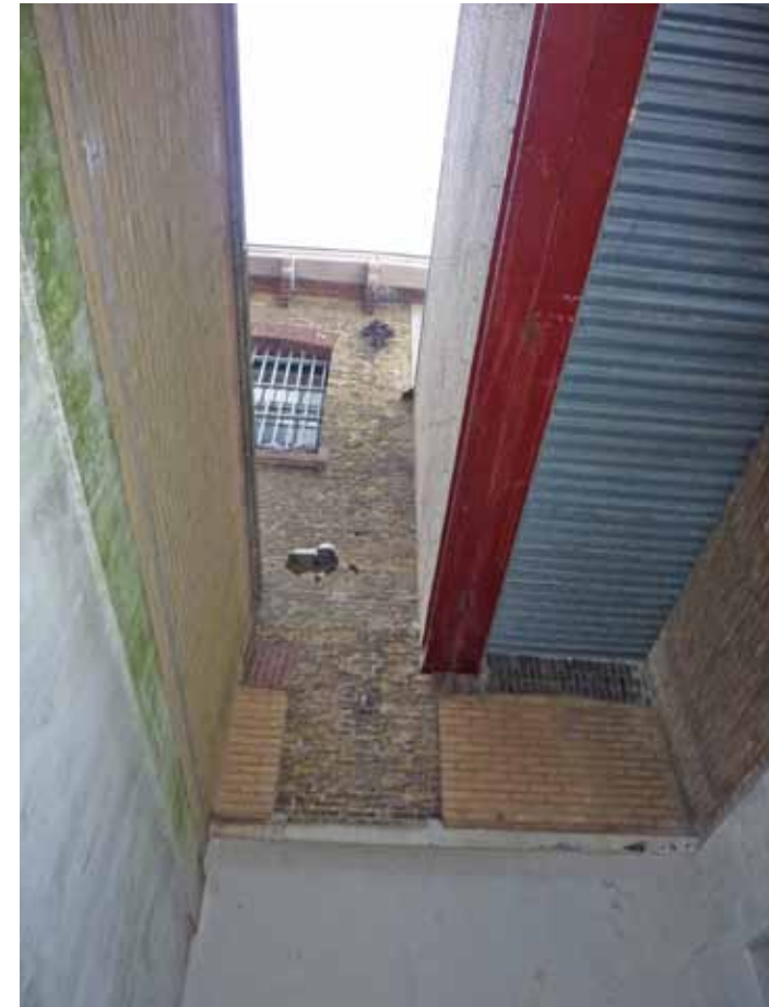
Afbeelding 9. De vensters in de zestiende en zeventiende vensteras zijn dichtgezet (1948) tijdens de aanbouw van de nieuwe smederij en ten behoeve van de luchtplaats van de strafcellen. Tevens is het metselwerk hier voorzien van een pleisterlaag.
