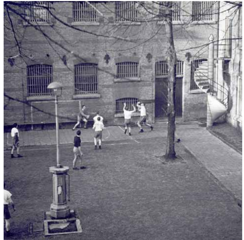
Afbeelding 131. Zicht op de tweede binnenplaats gezien richting het westen in 1948. Door het wijzigen van de ideeën over het luchten van de gevangenen - wat voorheen in luchtkooien plaatsvond - werd de tweede binnenplaats in gebruik genomen als sport- en wandelplaats. Foto: Collectie beeldbank Leeuwarden, documentnr.: FDBLHSPLA036.
