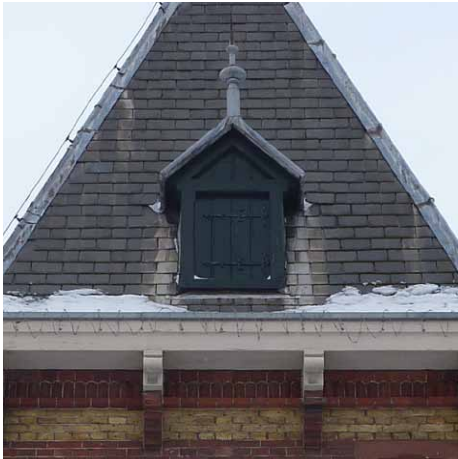
Afbeelding 12. Overzicht van een dakkapel in de traptoren. De dakkapellen zijn zorgvuldig vormgegeven met houten stijlen voorzien van vellingkanten, een opgeklampt luik in kraaldelen met versierde gehengbladen, zijn afgedekt met lood en worden bekroond door een loden piron.
