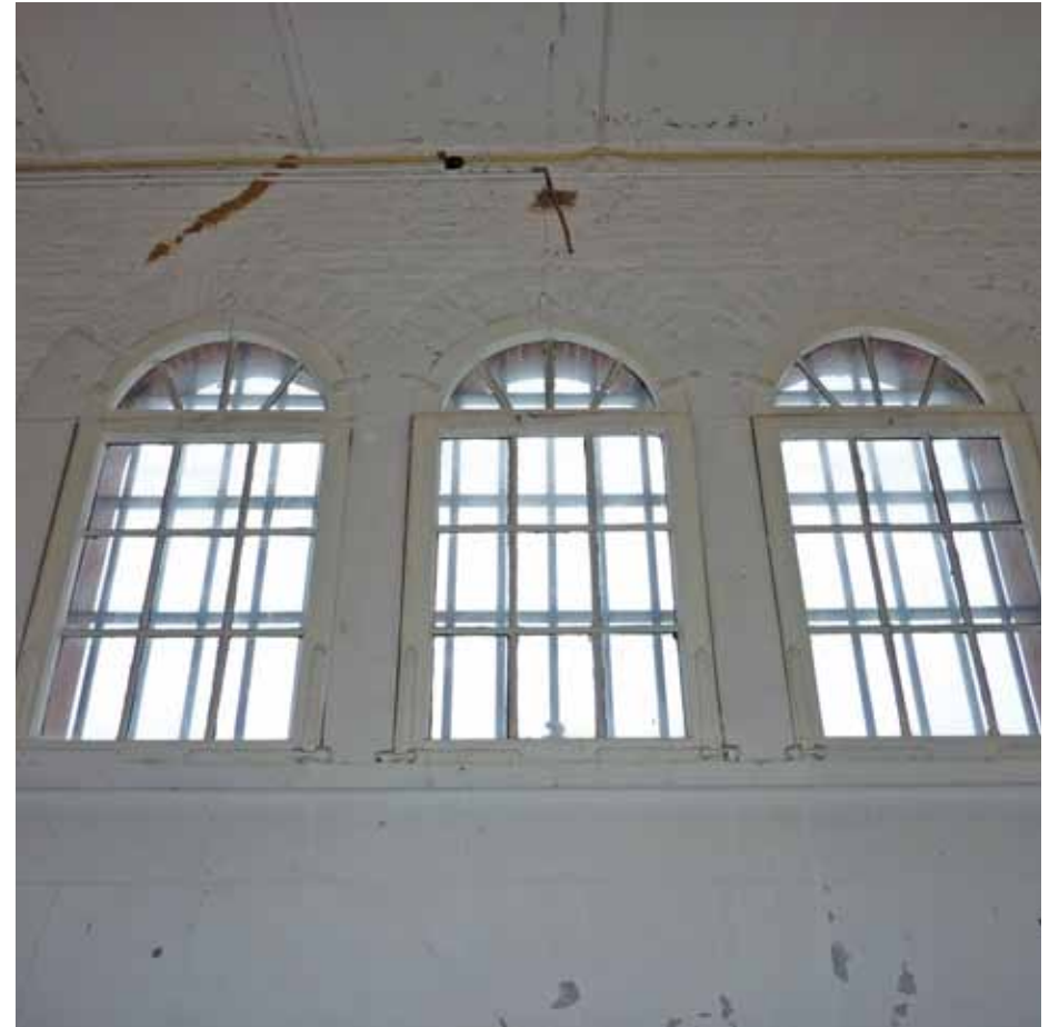
Afbeelding 35. Zicht op het venster in de oostwand van de overloop. Het drie-licht (1874) bezit kleppende onderramen. Ter plaatse van het venster zijn geen sporen van eventuele binnenwanden van de privaten zichtbaar, wat het waarschijnlijk maakt dat deze niet werden uitgevoerd.
