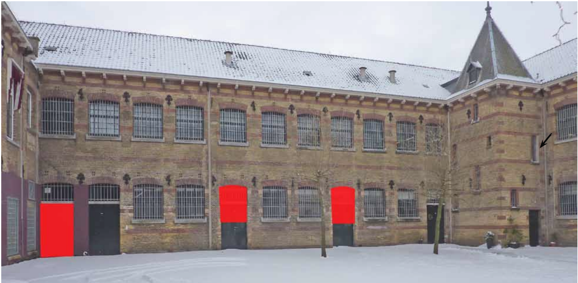
Afbeelding 17. Overzicht van de noordgevel van de grachtvleugel van bouwdeel D met daarop aangegeven de oorspronkelijke grootte van de gevelopeningen. De oorspronkelijke deuropening in de eerste vensteras is dichtgezet en voorzien van een aubergine gesausde pleisterlaag (1997). Tevens zijn enkele vensters later voorzien van 3-ruits bovenramen en 3-ruits onderramen. De pijl geeft aan dat van dit venster de rechter Udelfanger zandstenen stijl vervangen is door een betonnen stijl (Afbeelding 19).
