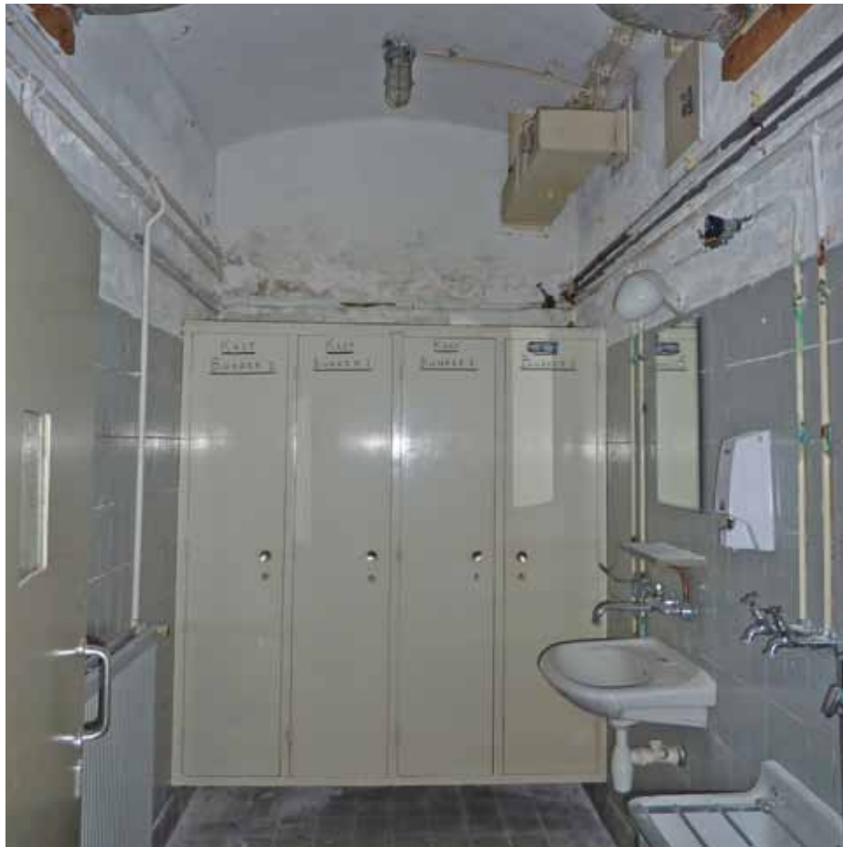
Afbeelding 123. De wanden van de ruimte 10.02 zijn voorzien van een tegel-lambris. Tegen de oostwand zijn vier stalen locker-kasten geplaatst. De zuidwand is voorzien van een wastafel en een uitstortgootsteen. De doorgang naar de gang bevindt zich in de westwand . Tevens is de ruimte voorzien van diverse installaties.
