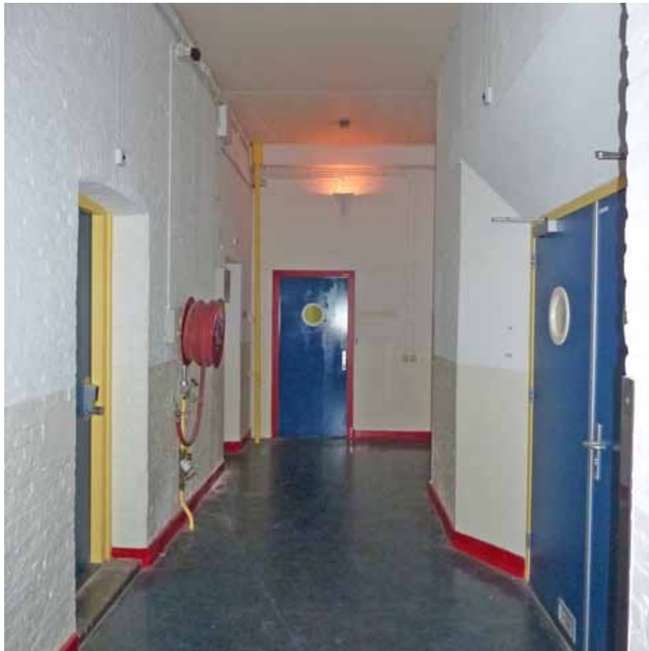
Afbeelding 107. Overzicht van de gang gezien richting het noorden. De dubbele deuren (1988) geven toegang tot de in 1988 gerealiseerde kerk in de oostelijke uitbouw (bouwdeel E). De voorste doorgang links is oorspronkelijk, de tweede deur werd in 1988 ingebroken ter plaatse van een venster in de voormalige (tot 1948) buitenwand.
