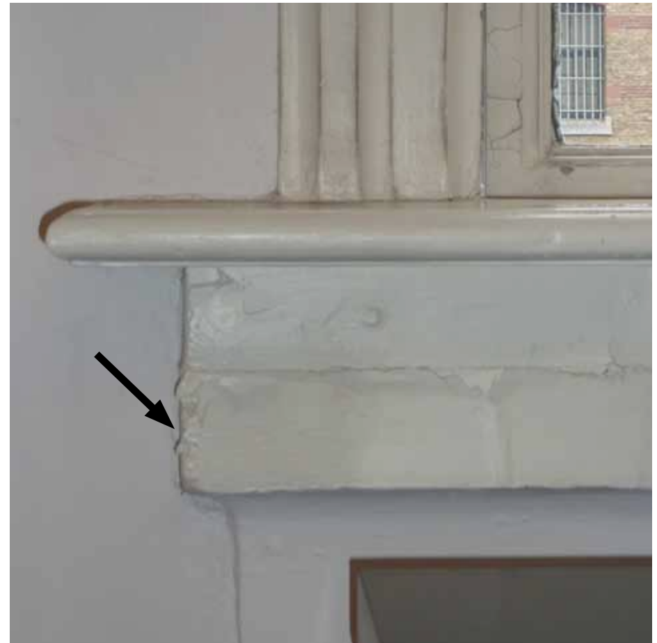
Afbeelding 111. Detail van de linker onderhoek van één van de vensters. De hoog geplaatste kleine vensters in de ruimten F1.26 en F1.27 werden verlengd (1949, zie Afbeelding 143), waarbij de huidige kozijnen, lijsten en vensterbanken werden aangebracht. De hardstenen onderdorpel (pijl) werd hierbij vermoedelijk herplaatst.
