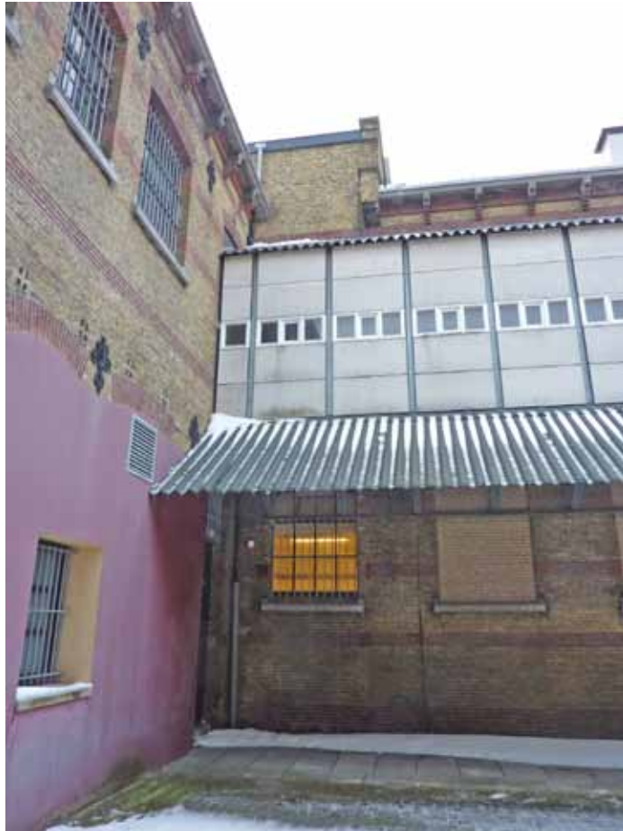
Afbeelding 27. De oostgevel van de keukenvleugel is vier vensterassen breed en wordt ter hoogte van de verdieping bijna geheel aan het zicht onttrokken door een met eterniet platen beklede gang (1988), voorzien van een met golfplaten afgedekt lessenaarsdak.
