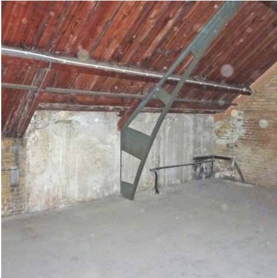
Afbeelding 113. Zicht op de noordwestelijke hoek van ruimte J2.02. Het gepleisterde deel van de borstwering is vermoedelijk de oostgevel van de vooranger van bouwdeel I. Dit gebouw werd pas in 1893 gesloopt ten behoeve van de huidige cellenvleugel.
