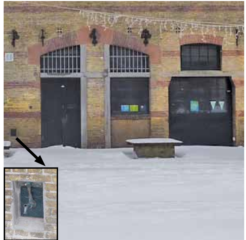
Afbeelding 13. In de vierde vensteras bevindt zich onder een keperboog (1873) een voormalige dubbele gevelopening. In het rechterdeel is de dubbele deur vervangen door een 12-ruits venster met een bakstenen onderdorpel en eronder een visgraten metselwerk invulling. Het korte venster in de vijfde vensteras is vervangen (XXb) door een getoogd 8-ruits ventser, eronder is een betonnen latei geplaatst op een gemetselde getrapte uitkraging. Onder de latei bevindt zich een stalen schuifdeur voorzien van een 8-ruits venster en gemetselde dagkanten.
