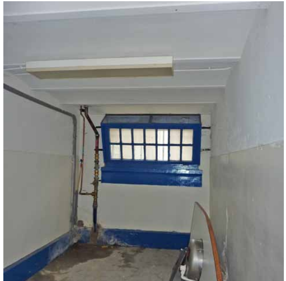
Afbeelding 46. Overzicht van ruimte B0.47 (opslag). De halfsteens troggewelven op IPN-liggers werden in 1894 aangebracht, evenals het venster in de oostwand.
