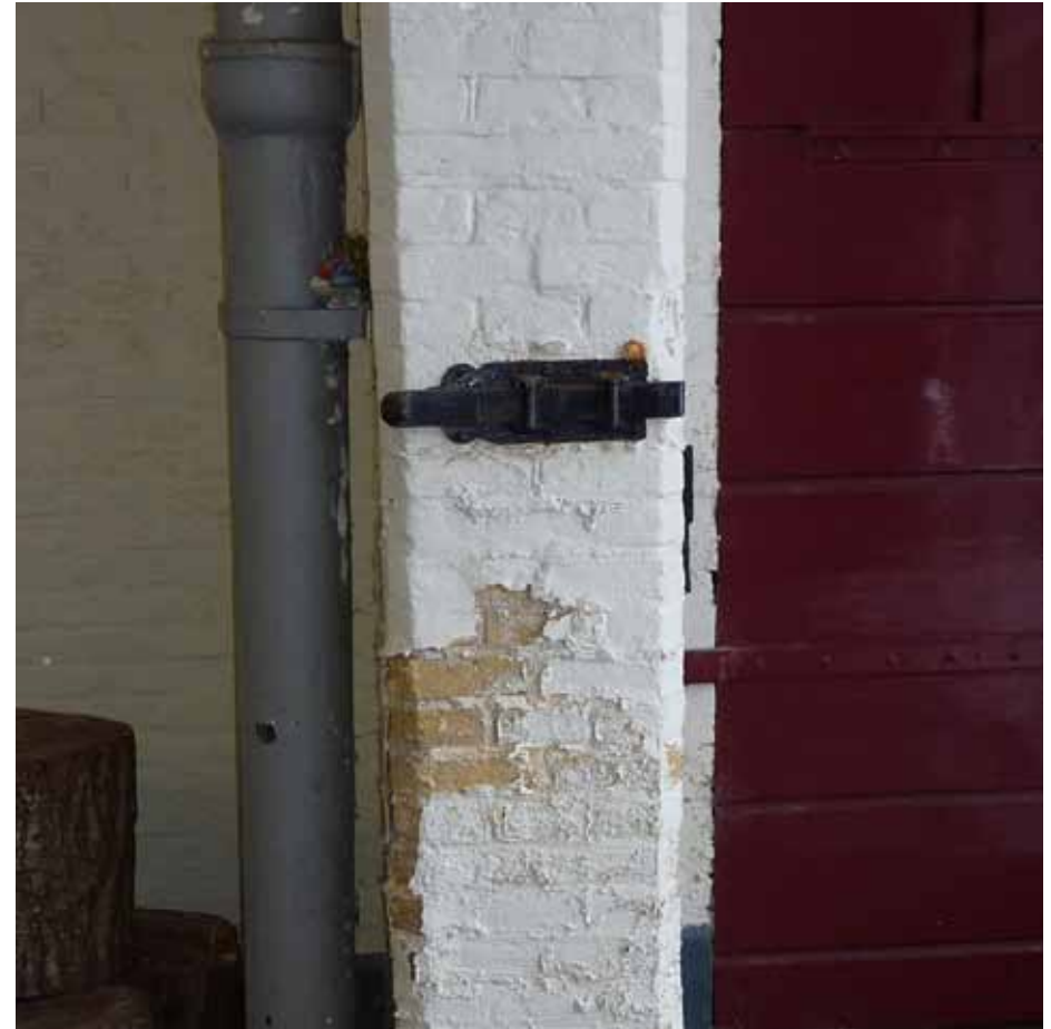
Afbeelding 32. Op de muurdam in de zuidwand bevindt zich een kantschuif ten behoeve van het vastzetten van de oorspronkelijke poortdeuren in geopende toestand.
