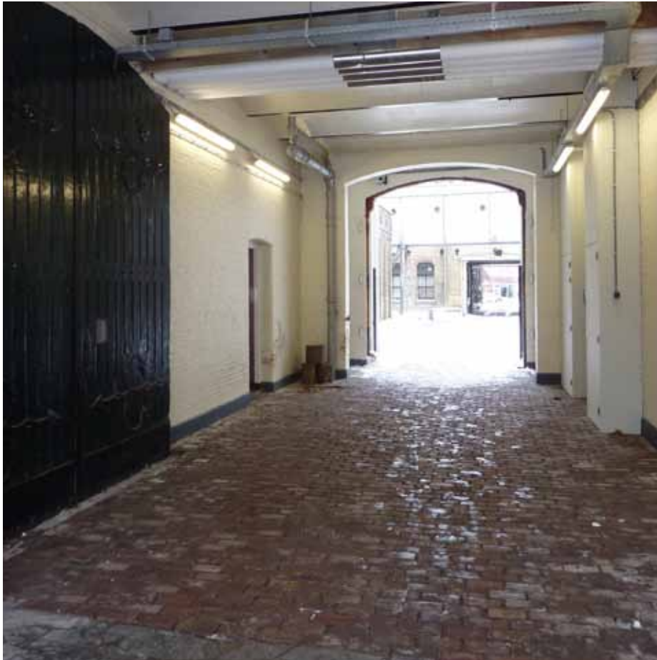
Afbeelding 29. Overzicht van de poort (ruimte P0.10) gezien richting het westen. De oorspronkelijke poortdeuren werden in 1998 verwijderd en tegen de zuidwand geplaatst. Tevens werden er enkele kasten tegen de noordwand aangebracht ten behoeve van de electra.
