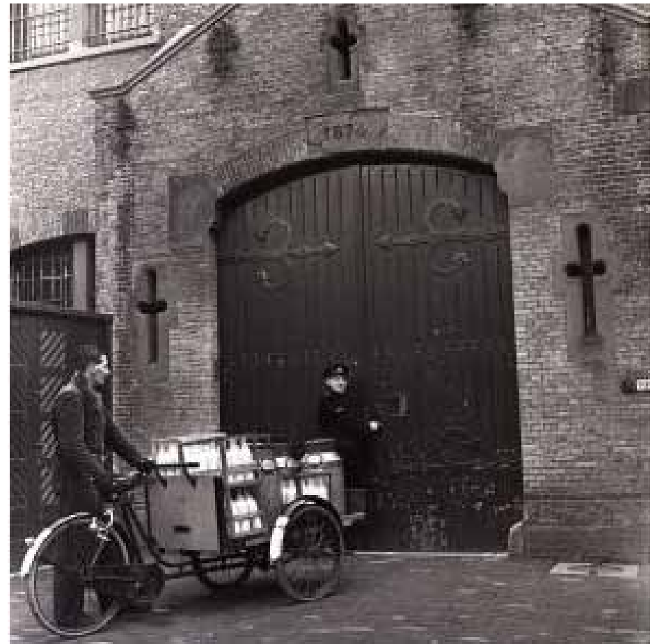
Afbeelding 7. Foto van de toegangspoort naar de tweede binnenplaats in 1959. Links van de doorgang is een houten afscheiding te zien met een detaillering gelijk aan de deuren van de smederij (bouwdeel J) uit 1948. De poortdeuren zijn op dit moment geplaatst tegen de noordwand van de poortdoorgang.
