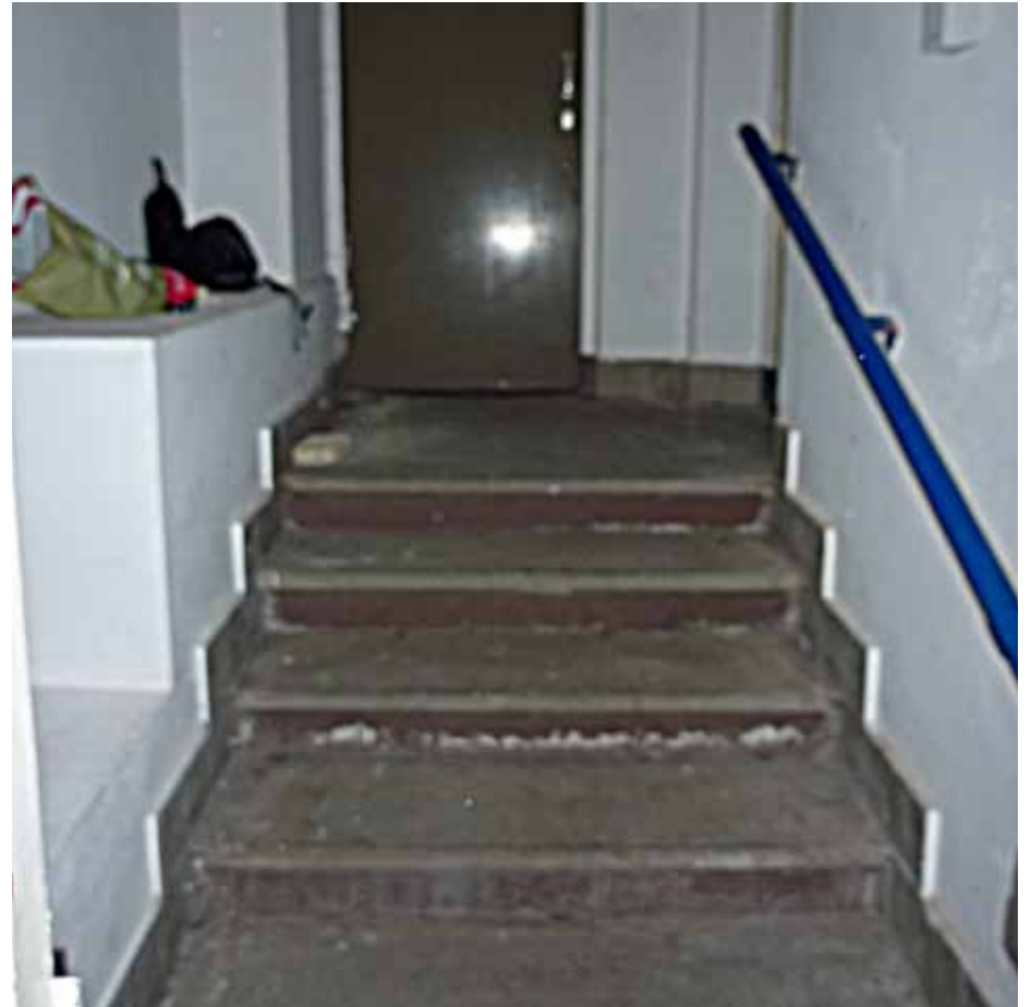
Afbeelding 122. Aan de noordzijde van de gang bevindt zich een betonnen trap (XXb), waarvan de stootborden van de treden voorzien zijn van een rode kleur.
