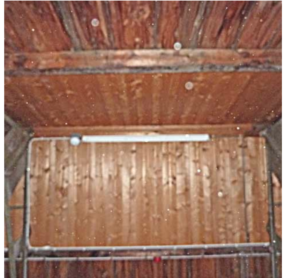
Afbeelding 116. Zicht op het lichter gekleurde dakbeschoot ter plaatse van de nok. In elk van de grote zolderruimten bevond zicht tot 1974 een dakkapel op de nok van het zadeldak (vergelijk met Afbeelding 120).
