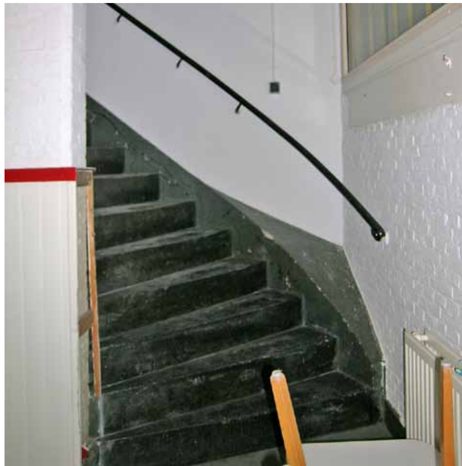
Afbeelding 81. Zicht op de onderzijde van de hardstenen trap (1874) naar de zolder van bouwdeel D. De ijzeren leuning kent een gekruld uiteinde.
