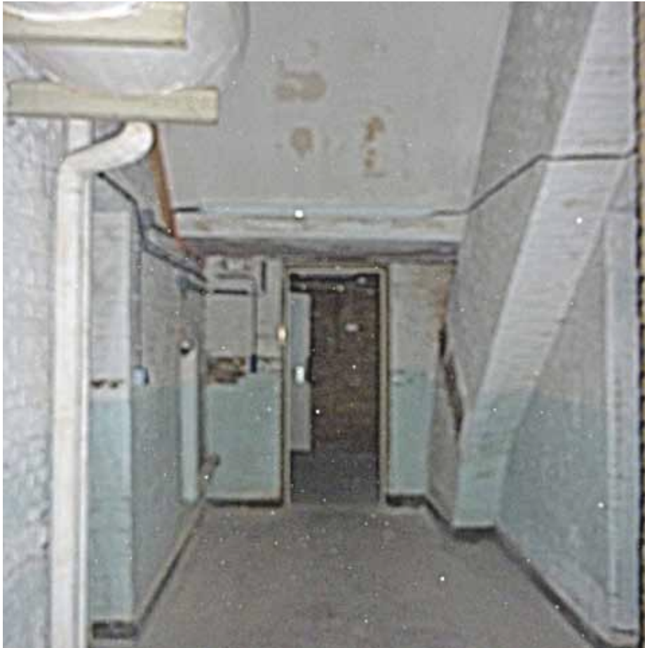
Afbeelding 117. Overzicht van ruimte F2.07 gezien richting het noorden. Achter de doorgang bevinden zich de boven de keukenvleugel gelegen zolderruimten. Oorspronkelijk was deze ruimte bereikbaar via een hardstenen trap vanaf de verdieping, maar deze werd in 1988 verwijderd (zie Afbeelding 106). De sporen hiervan zijn nog zichtbaar in de vloer aan de zuidzijde van de ruimte en op de wanden van de onderliggende gang.
