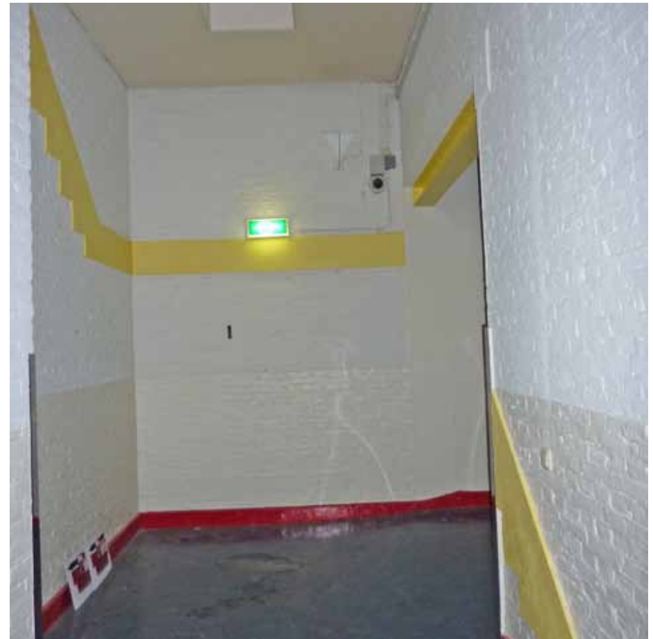
Afbeelding 106. Overzicht van het zuidelijke deel van de gang. Hier werd in waarschijnlijk in 1988 - of kort daarna - het oorspronkelijke trappenhuis verwijderd ten behoeve van de nieuwe verbindingsgang. Ter plaatse van de vroegere hardstenen treden werd bewust een pleisterlaag aangebracht, zodat de sporen van de trap voor iedereen zichtbaar bleven. De trap verbond de eerste verdieping met de zolder, maar niet met de begane grond.
