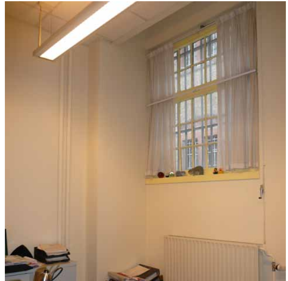
Afbeelding 96. Overzicht van ruimte H1.16 gezien richting het zuidwesten. De buitengevel is voorzien van een voorzetwand (1988/1997), hierbij werd de onder- en bovendorpel van het venster aan het zicht onttrokken. Het rookkanaal hoort vermoedelijk bij een oudere kachel van de onderliggende ruimte. Het kanaal werd in 1988 vergroot in verband met de aanleg van een cv-ruimte in de onderliggende ruimte.
