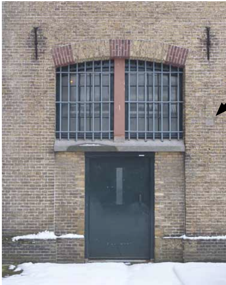
Afbeelding 6. In de eerste vensteras van de westgevel van de binnenplaatsvleugel is onder het getoogde venster secundair (1957) een deur geplaatst. Tussen de eerste en tweede vensteras is een hardstenen blokje aanwezig met erboven een zwarte afdruk die mogelijk duidt op de plaats van een vroegere lantaarn.
