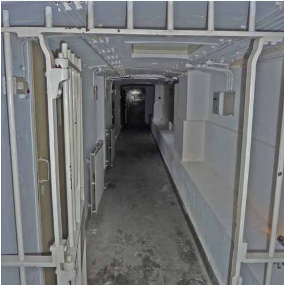
Afbeelding 121. Overzicht van de gang naar de isoleercellen gezien richting het zuiden. Op de voorgrond het stalen hekwerk (XXc) dat de gang aan de noordzijde afsluit.
