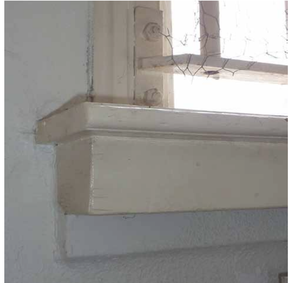
Afbeelding 105. Detail van de linker onderhoek van het venster van de voorgaande afbeelding. Het venster bezit dezelfde aftimmerlijsten en detaillering van de stolpramen als de vensters in de naastgelegen ruimten F1.26 en F1.27, die in 1948 werden verlengd. Het venster werd geplaatst op een hardstenen onderdorpel (1948), die waarschijnlijk herbegruipt werd van het venster van de voormalige buitenwand ter plaatse van de huidige gangwand.
