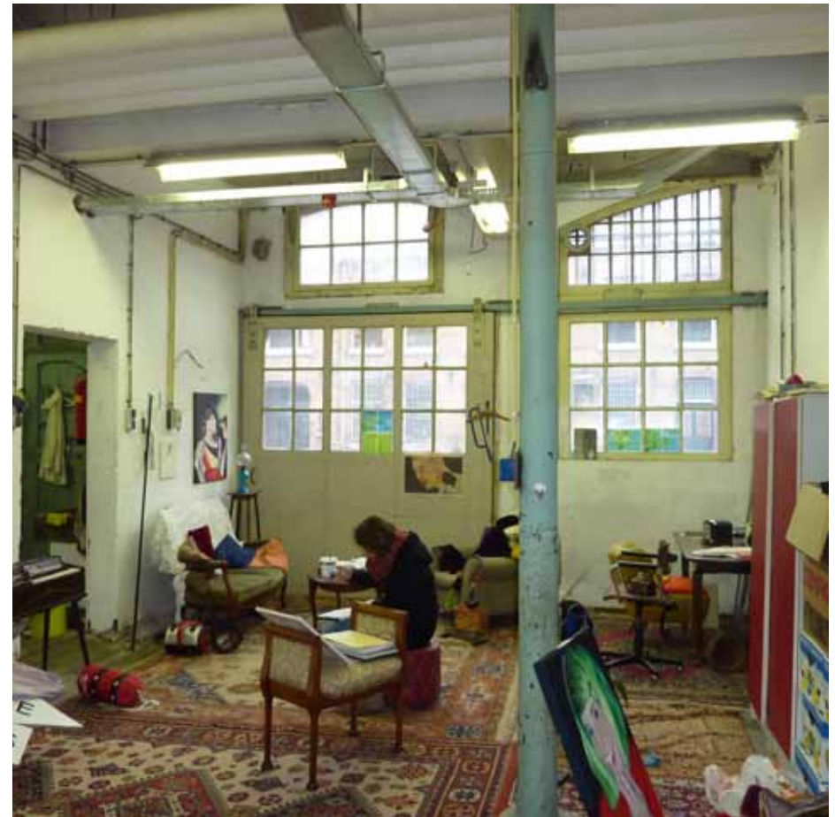
Afbeelding 61. Overzicht van ruimte J0.01 gezien richting het oosten. De schuifdeur in de doorgang naar de tweede binnenplaats is secundair (XXb) en voorzien van een 18-ruits venster en stalen platen op de onderpanelen. Boven de schuifdeur bevindt zich een 8-ruits naar binnen kleppend venster (XXb). Rechts van de schuifdeur is onder het oorspronkelijke half getoogde bovenraam een 12-ruits venster met zinken roeden geplaatst (XXb). De rest van de oorspronkelijke deuropening is dichtgezet en gepleisterd.
