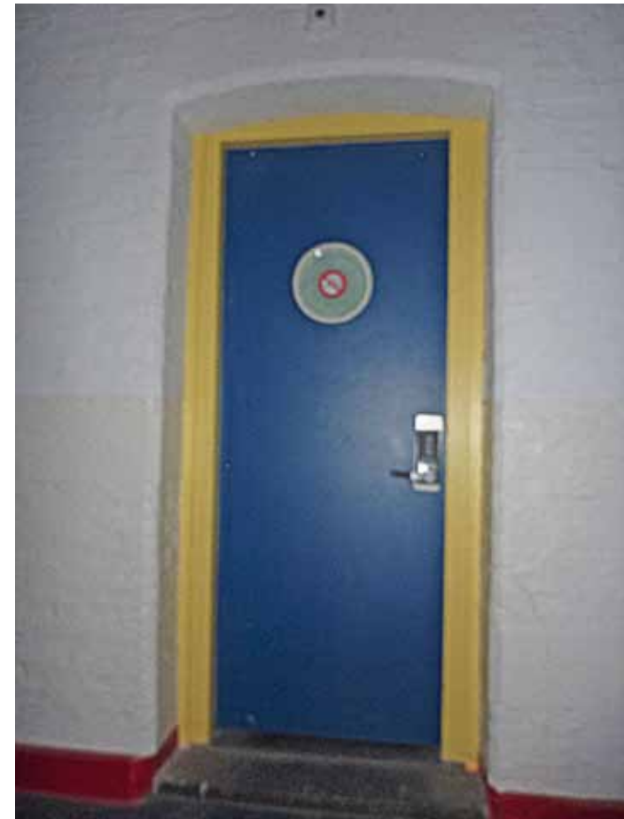
Afbeelding 108. Zicht op de doorgang naar de behandelkamer (H1.03). De deur werd in 1988 geplaatst in een oudere doorgang (1874).
