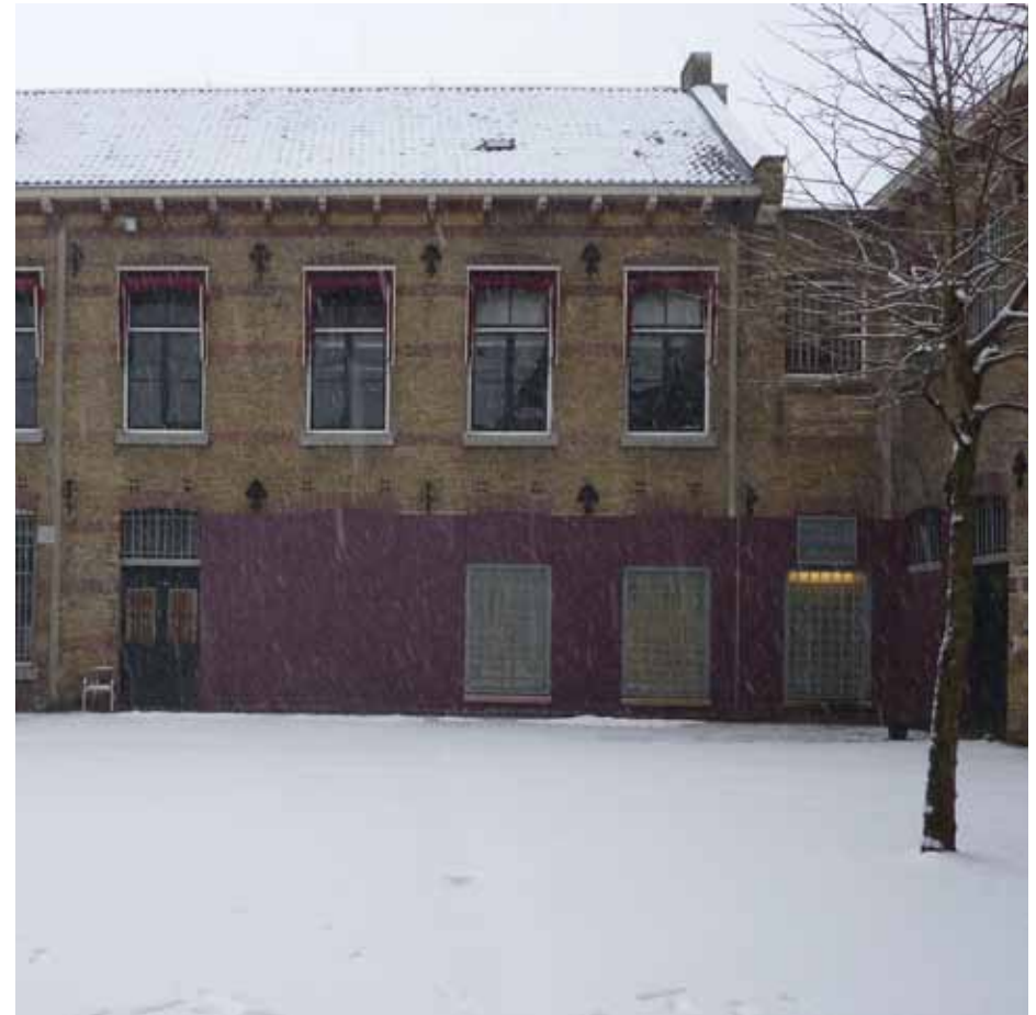
Afbeelding 24. De westgevel van de keukenvleugel is ter hoogte van de begane grond voorzien van een aubergine gesausde pleisterlaag (1997) op de plaats van de voormalige keukenaanbouw. Boven deze pleisterlaag zijn nog vier segmentbogen in rode baksteen zichtbaar. Onder de segmentbogen in de derde, vierde en vijfde vensteras zijn vensters (1997) aangebracht uit glazen bouwstenen met een betonnen omlijsting en een betonnen onderdorpel. Tussen het venster en de segmentboog in de vijfde vensteras is een ventilatierooster aangebracht.
