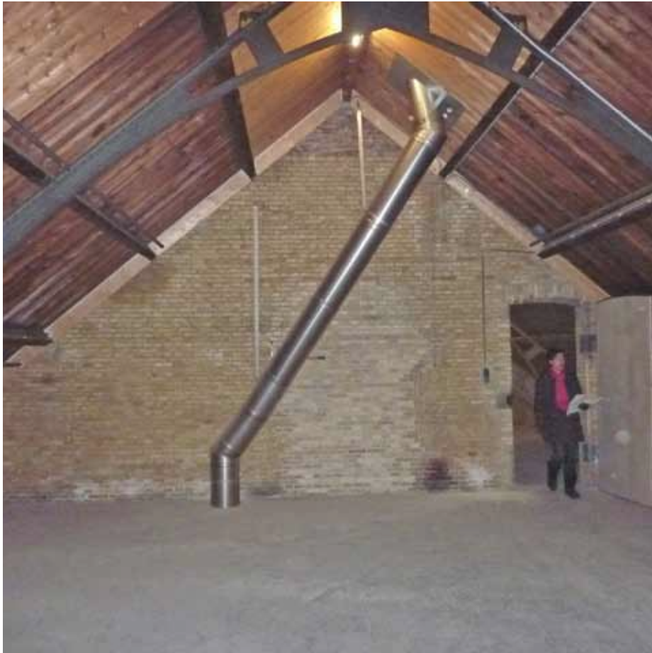
Afbeelding 115. Zicht op de brandmuur tussen de ruimten J2.02 en J2.03 vanuit ruimte J2.02, gezien richting het zuiden. In 1957 werd de oorspronkelijke opening in het midden dichtgezet en werd een deur meer naar rechts aangebracht ten behoeve van het doorvoeren van de rookgasafvoer van de nieuwe cv-installatie. In het dakbeschoot is juist voor de wand een lichtere zone zichtbaar (zie ook Afbeelding 116).
