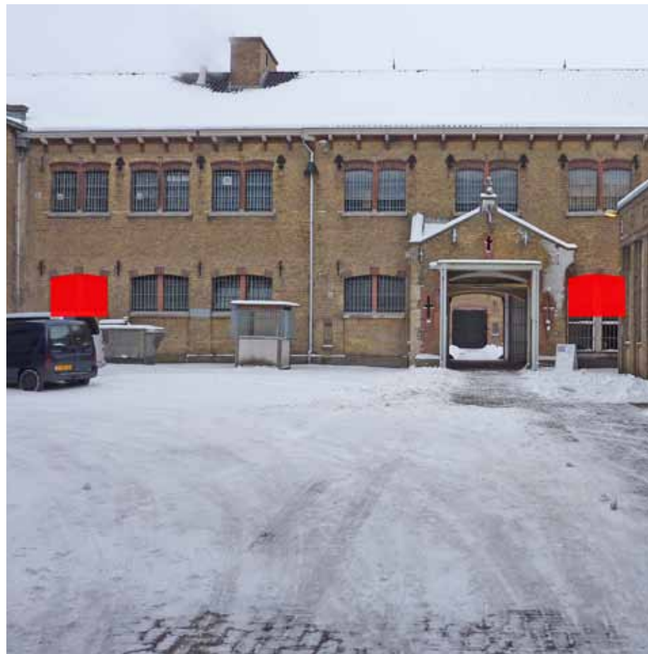
Afbeelding 5. Overzicht van de westgevel van de binnenplaatsvleugel van bouwdeel D, gezien vanaf de eerste binnenplaats, met daarop aangegeven de oorspronkelijke grootte van de gevelopeningen.
