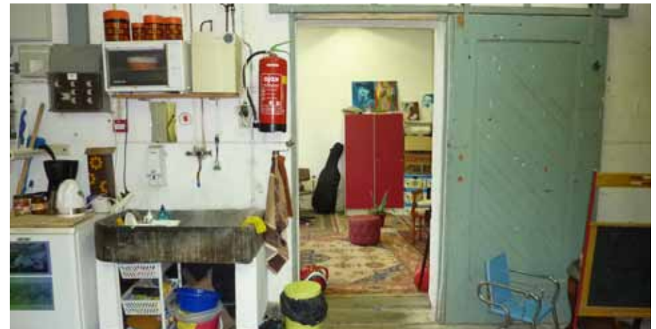
Afbeelding 58. Overzicht van ruimte J0.02 gezien richting het zuiden (ruimte J0.01). De doorgang bevat een houten schuifdeur (1948), waarvan het paneel voorzien is van schuine latten. Links naast de doorgang is een hardstenen gootsteen op gemetselde halfsteensmuurtjes geplaatst.
