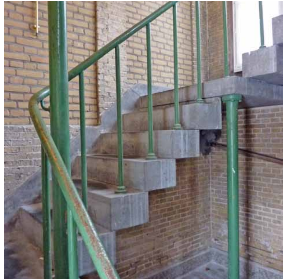
Afbeelding 33. Overzicht van het interieur van de noordelijke traptoren. De trappen zijn opgebouwd uit hardstenen blokken van 27 x 19 cm en voorzien van ijzeren balusters. De hardstenen bordessen worden ondersteund door ijzeren kolommen. De invullingen aan de achterzijde zijn secundair (XXc).
