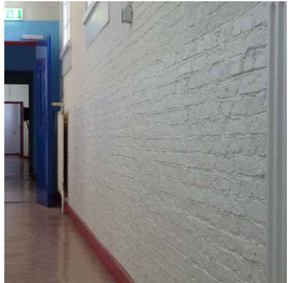
Afbeelding 85. Zicht op de onderzijde van de oostwand van de gang. Onder de hoog geplaatste vensters zijn delen van het metselwerk uitgevoerd als vuil werk. Mogelijk zijn dit dichtzettingen van nissen ten behoeve van radiatoren.
