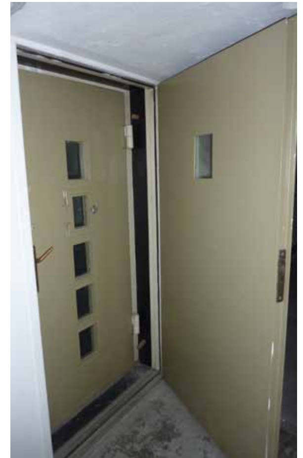
Afbeelding 124. Links de oorspronkelijke opgeklampte houten celdeur (1874) van de ruimten 10.06 en 10.07. De deur is voorzien van een kijkgat, een rechthoekig opdek- en een schuifslot. Rechts de celdeur van de ruimten 10.03 en 10.05 die bestaat uit een dubbele stalen deur (1948), waarbij de buitenste deur aan de gangzijde op een zichtluikje na geheel gesloten is, terwijl de binnendeur van glaspanelen is voorzien.
