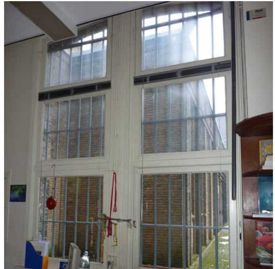
Afbeelding 64. Overzicht van ruimte J0.04 gezien richting het westen. Het 6-ruits getoogde venster (XXb) bestaat uit een samengesteld kozijn, waarvan beide bovenramen kleppend en het rechter onderraam draaiend is uitgevoerd. Tevens is het venster voorzien van een eenvoudige houten vensterbank geplaatst op een hardstenen onderdorpel.
