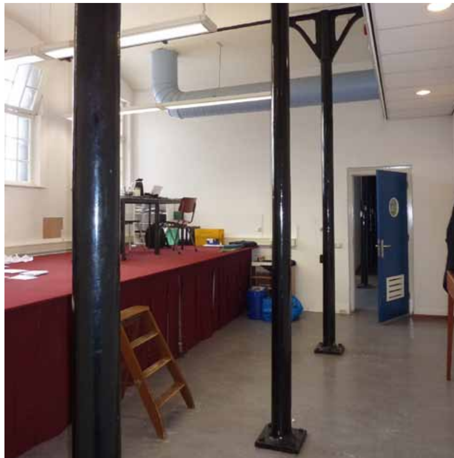
Afbeelding 132. Zicht in ruimte H1.09. De ruimtelijke kwaliteit van de vertrekken kan sterk winnen door verwijdering van de verlaagde plafonds, opdat de troggewelven weer zichtbaar worden. Tevens zou overwogen kunnen worden de vertrekken weer verticaal via de diverse trappenhuisen te ontsluiten, zodat de gang - rechts op de foto - verwijderd kan worden. De ruimten zouden daarbij weer hun oorspronkelijke verhoudingen terugkrijgen én via beide buitengevels voldoende daglichttoetreding krijgen.
