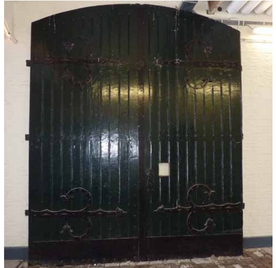
Afbeelding 30. Voor de dichtzettingen in de zuidwand zijn de oorspronkelijke poortdeuren, voorzien van siersluitwerk en zware gehengen, geplaatst.
