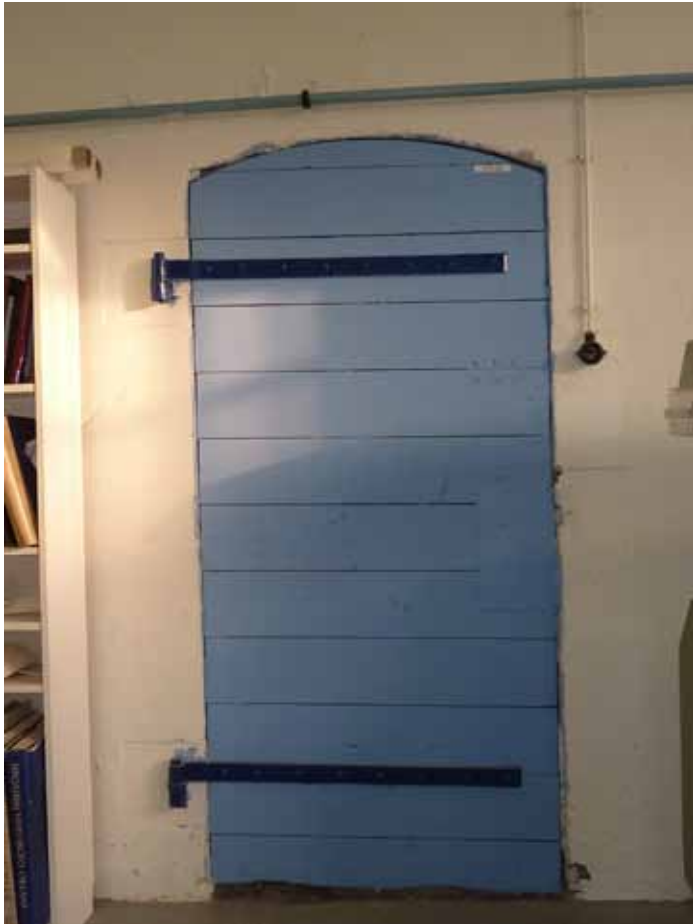
Afbeelding 69. Zicht op de deur in de oostwand (voorgaande afbeelding). De zwaar uitgevoerd deur werd in 1948 gelijktijdig met de wand angebracht en is aan de andere zijde voorzien van verticale kraaldelen.
