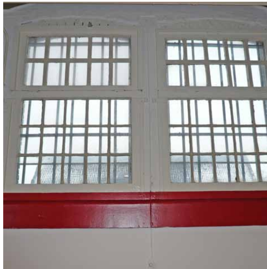
Afbeelding 90. Detail van één van de vensters in de oostgevel van ruimte J1.08. De vaste onderramen zijn vastgezet aan ingemetselde hardstenen blokken door middel van ijzeren doken. Boven de kleppende bovenramen zijn vaste bovenstukken geplaatst, voorzien van ventilatiegaten die door middel van ijzeren platen kunnen worden afgesloten danwel geopend.
