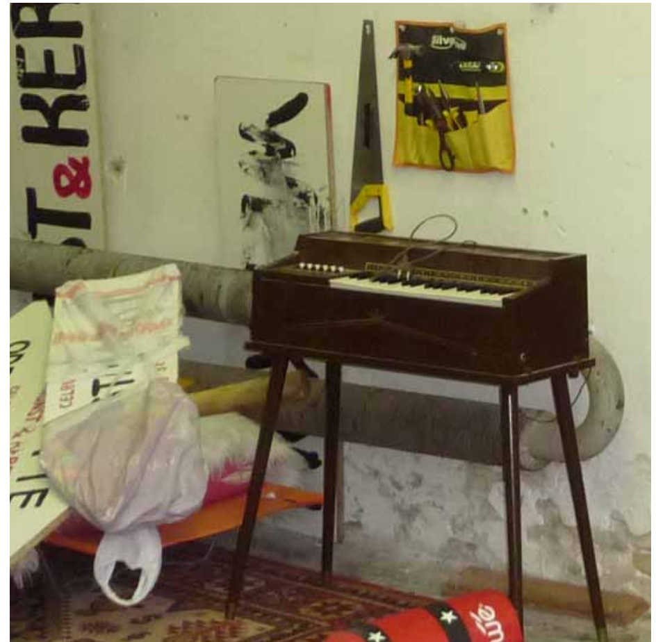
Afbeelding 63. Detail van de buisradiator tegen de noordwand van ruimte J0.01, links naast de doorgang die toegang geeft tot ruimte J0.02.
