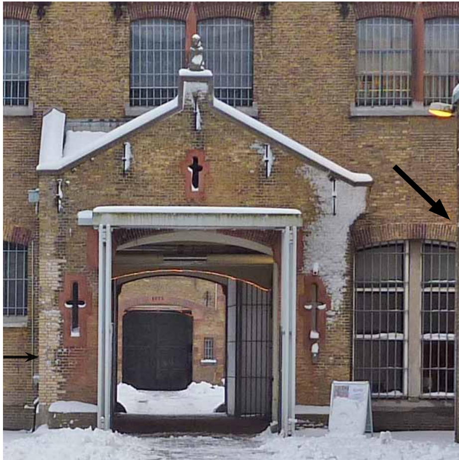
Afbeelding 8. Voor de poort naar de tweede binnenplaats is een stalen hekwerk (XXd) geplaatst voorzien van een hardstenen dekplaat. Links van deze doorgang zijn inboetingen in het metselwerk zichtbaar. Rechts van deze doorgang is het oorspronkelijke venster vervangen door een getoogd 6-ruits venster (XXb) met hardstenen vaste middenstijl en onderdorpel.
