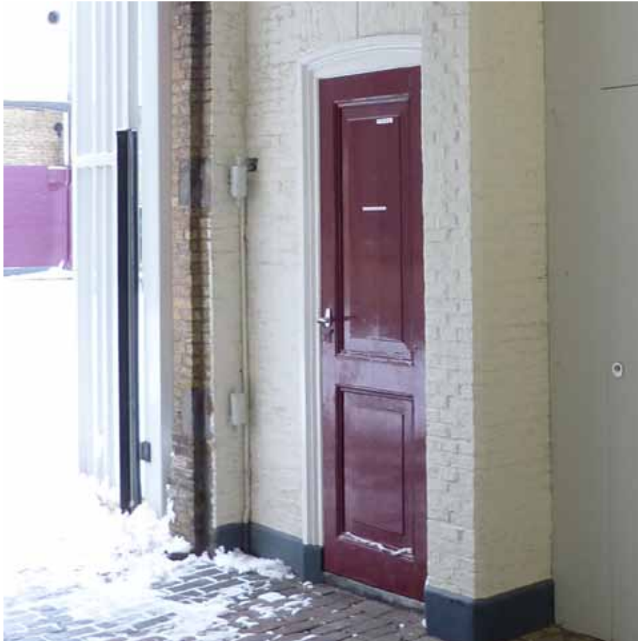
Afbeelding 31. Links naast de muurdam in de noordwand bevindt zich, op de plaats van een vroeger privaat (1874), een in halfsteens verband gemetselde wand (XXc). De kastdeuropening in deze wand is voorzien van een segmentboog en een hergebruikte binnendeur met kozijn. Het kozijn (vermoedelijk 1874) bezit een getoogde bovendorpel en is voorzien van geprofileerde lijsten en neuten. De deur is een paneel deur.
