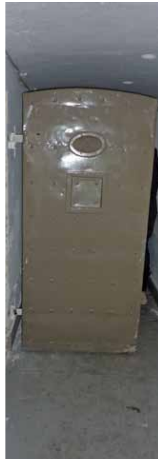
Afbeelding 124. Links de oorspronkelijke opgeklampte houten celdeur (1874) van de ruimten 10.06 en 10.07. De deur is voorzien van een kijkgat, een rechthoekig opdek- en een schuifslot. Rechts de celdeur van de ruimten 10.03 en 10.05 die bestaat uit een dubbele stalen deur (1948), waarbij de buitenste deur aan de gangzijde op een zichtluikje na geheel gesloten is, terwijl de binnendeur van glaspanelen is voorzien.
