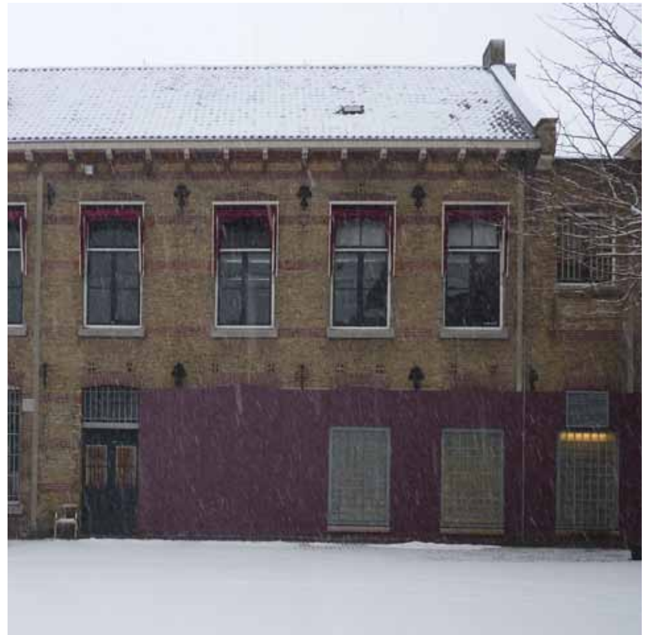
Afbeelding 129. De westgevel van de keukenvleugel is ter hoogte van de begane grond voorzien van een aubergine gesausde pleisterlaag (1997) op de plaats van de voormalige keukenaanbouw. Boven deze pleisterlaag zijn nog vier segmentbogen in rode baksteen zichtbaar. Herstel van de oorspronkelijke vensterindeling is aanbevelenswaardig.
