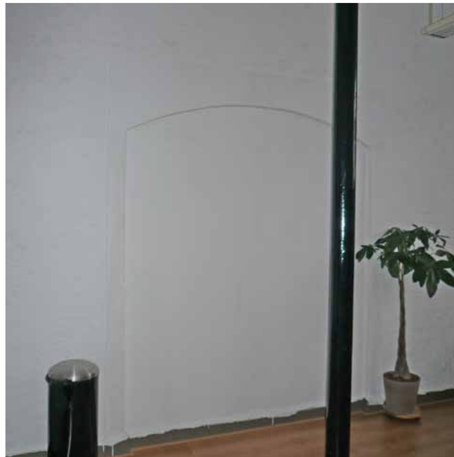
Afbeelding 93. Zicht op de zuidwand van ruimte J1.04. Deze doorgang in een wand uit de bouwtijd werd vermoedelijk doorgebroken in 1948 en in 1976 weer gedicht. Aan de andere zijde (ruimte J1.03) is deze halfsteense dichtzetting eveneens zichtbaar.
