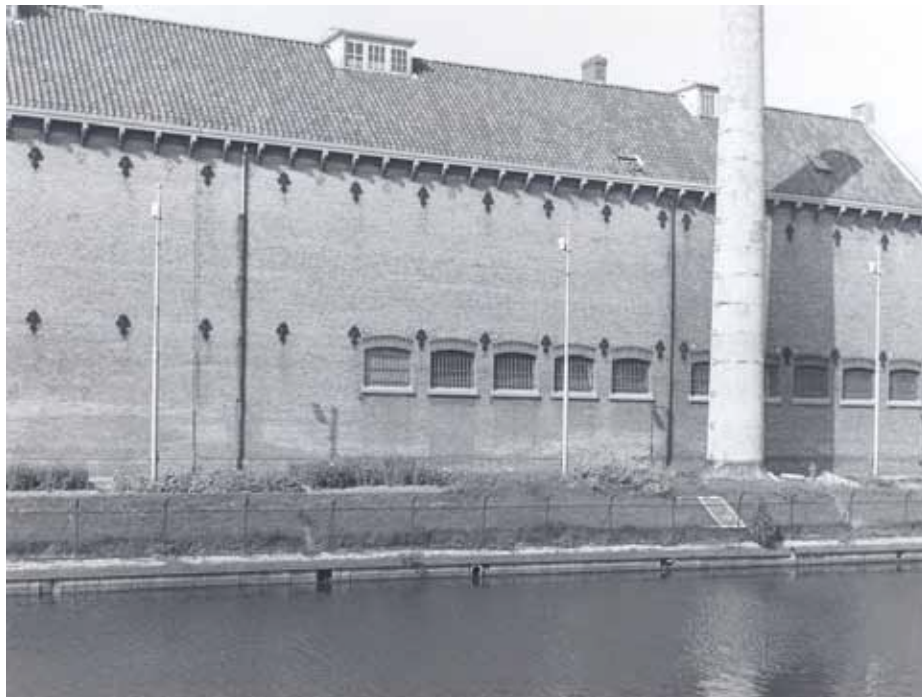
Afbeelding 119. Zicht op de zuidgevel van de grachtvleugel tussen 1970 en 1974. De dakkapellen op de nok waren hier nog aanwezig, evenals het oorspronkelijke rookkanaal ten noorden van de nok (zie ook Afbeelding 118), dat in 1975 werd vervangen door een kanaal ten zuiden van de nok. Foto: Collectie beeldbank Leeuwarden, documentnr.: FDBLHSPLA059
