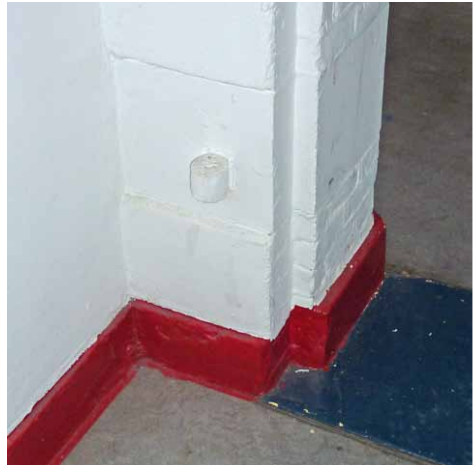
Afbeelding 84. Detail van de voorgaande afbeelding. In de doorgang bevond zich een zware houten deur die door middel van gehengen aan de duimblokken was bevestigd.
