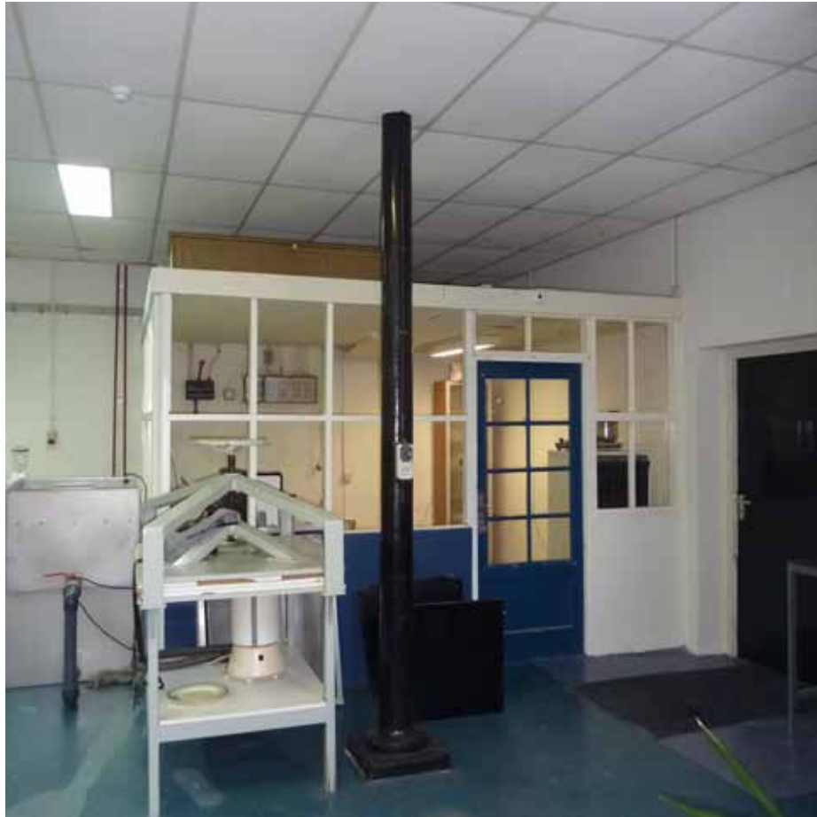
Afbeelding 66. Zicht op het kantoortje in de noordwestelijke hoek van de ruimte. Het kantoortje werd in 1976 gerealiseerd, waarbij vermoedelijk materialen van elders uit het complex werden hergebruikt. De deur rechts werd na 1988 aangebracht en komt uit in de verbindinggang tussen de tweede binnenplaats en bouwdeel C (het Alcovegebouw). De oorspronkelijke doorgang (1874) bevond zich achter de huidige toiletruimte (1976) en werd in 1894 dichtgezet.
