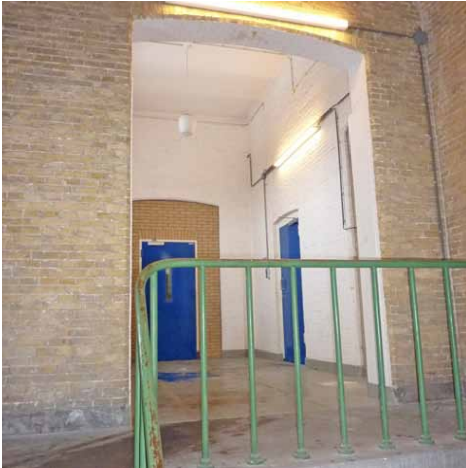
Afbeelding 34. Zicht op de overloop boven de poort vanaf het bordes van de noordelijke traptoren. De doorgang naar de zuidelijke toren werd in het midden van de 20 ste eeuw dichtgezet en voorzien van een deur. Vermoedelijk werd eveneens de tweede doorgang in de westwand aangebracht. Op de bouwtekening (Afbeelding 136) is een viertal privaten aangegeven, maar mogelijk zijn deze niet uitgevoerd of reeds voor 1894 verwijderd.
