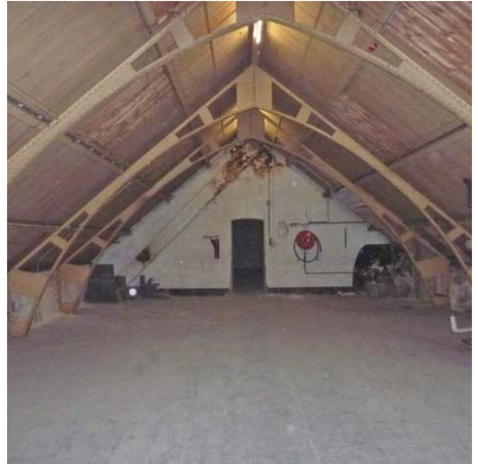
Afbeelding 114. Zicht op de brandmuur tussen de ruimten J2.03 en J2.04, vanuit ruimte J2.04, gezien richting het noorden. Deze wand is - in tegenstelling tot de andere brandmuren - voorzien van pleisterwerk. Dit hangt samen met de oorspronkelijke functie van dit deel van de zolder, waarbij deze zone bestemd was als slaapruidten voor de bewaarders (zie Afbeelding 137).
