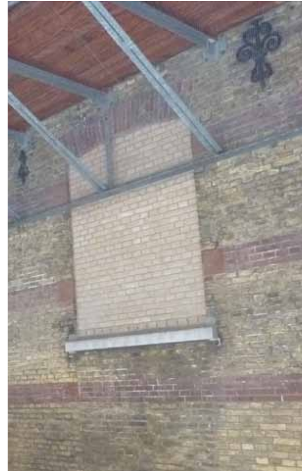
Afbeelding 28. Detail van dichtgezet venster dat voorzien is van een gemetselde invulling (1988) in kruisverband.
