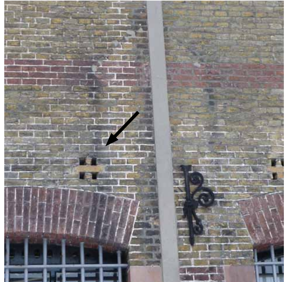
Afbeelding 26. Detail van de ventilatieopeningen boven de vensters. De aangegoten versiering van het anker is hier nog deels aanwezig.
