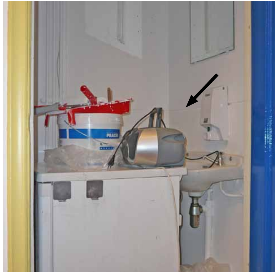
Afbeelding 92. Zicht in het interieur van de voorruimte van één van de toiletten. De wanden zijn voorzien van een verdiepte lambriseringlijst zoals deze ook tijdens de bouw (1874) in een aantal privaten werd uitgevoerd.
