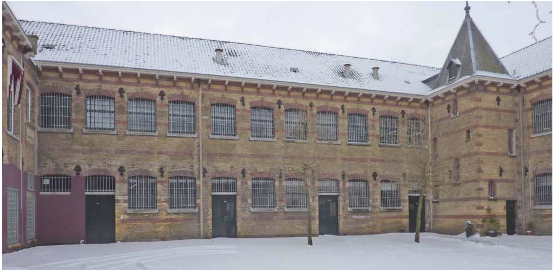
Afbeelding 16. Overzicht van de noordgevel van de grachtvleugel van bouwdeel D.
