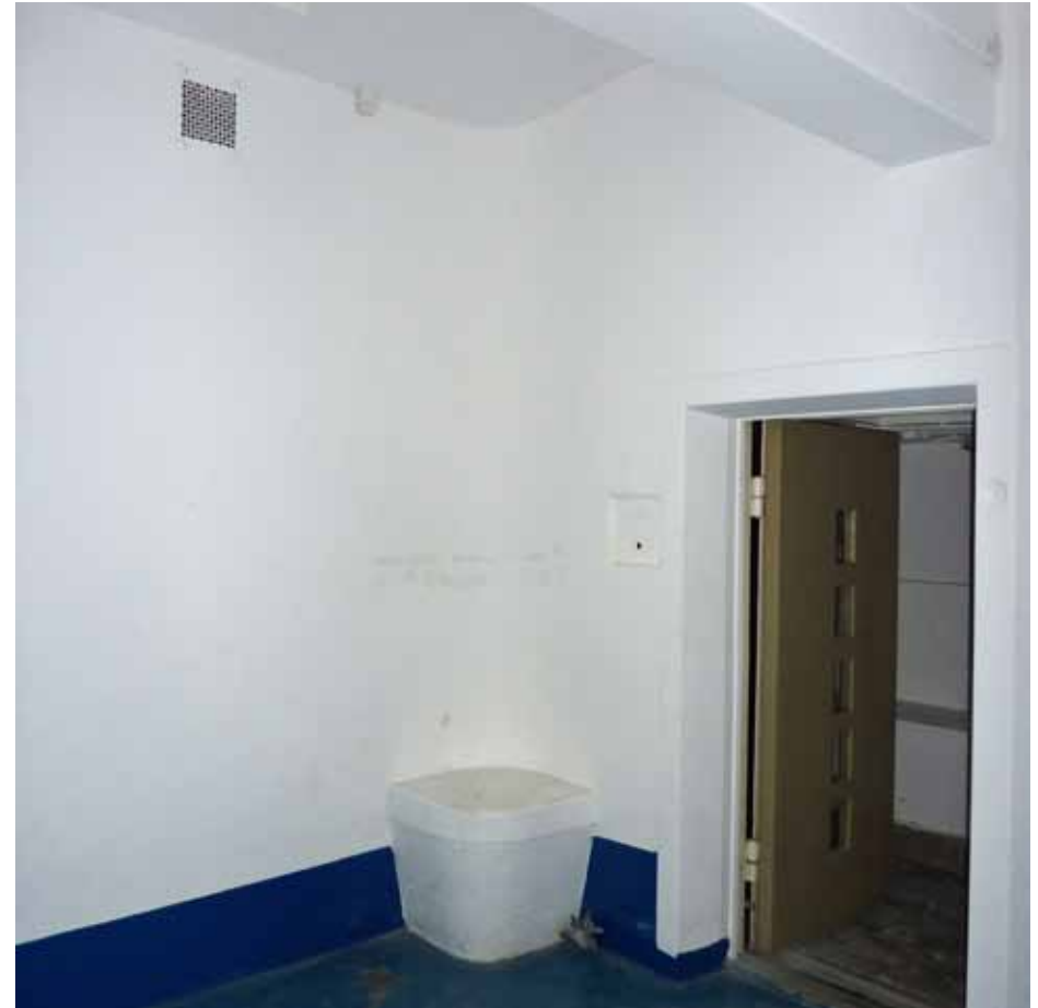
Afbeelding 126. Zicht in één van de twee samengevoegde isoleercellen, gezien naar het zuidwesten. In de ronde hoek bevindt zich een closet voorzien van een vaste wc-bril. In het midden van het plafond bevindt zich een balk die erop duidt dat de ruimte oorspronkelijk uit twee cellen bestond. De vloeren zijn voorzien van een blauwe epoxy gietvloer (1997) met een blauw geschilderde plint.
