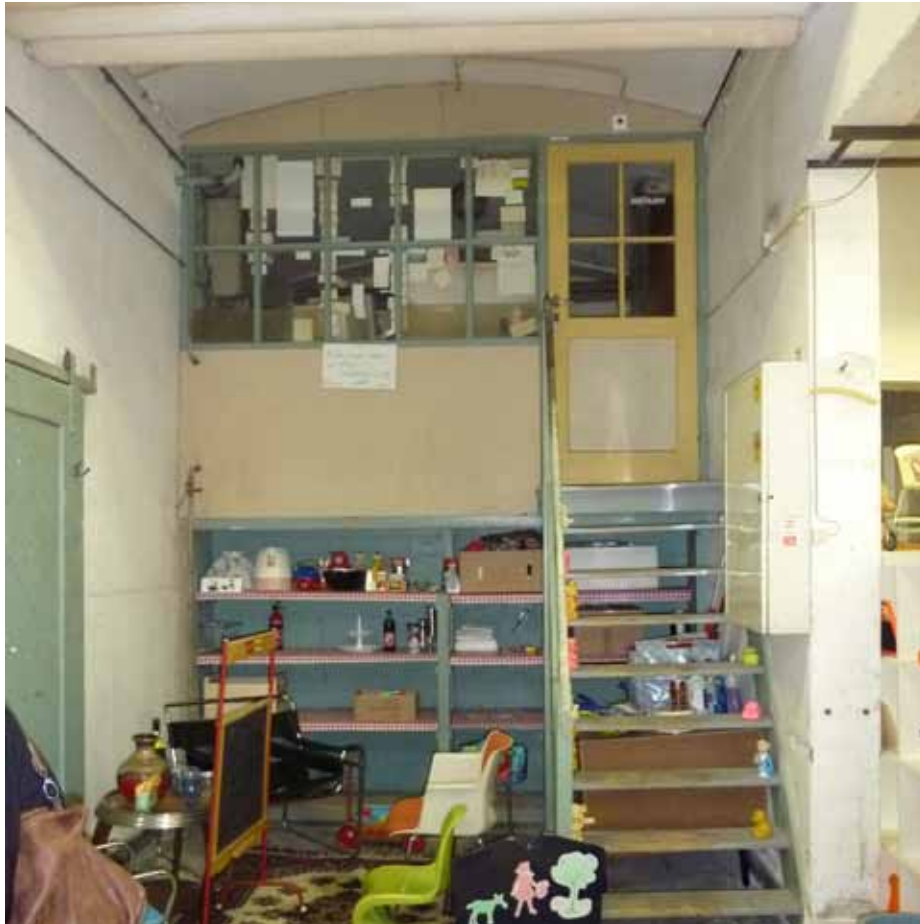
Afbeelding 59. Tegen de westwand is een hoger gelegen kantoortje, voorzien van een glasroedenpui, geplaatst (1948) dat middels een houten trapje te bereiken is. Onder het kantoortje bevindt zich een open kast met planken.
