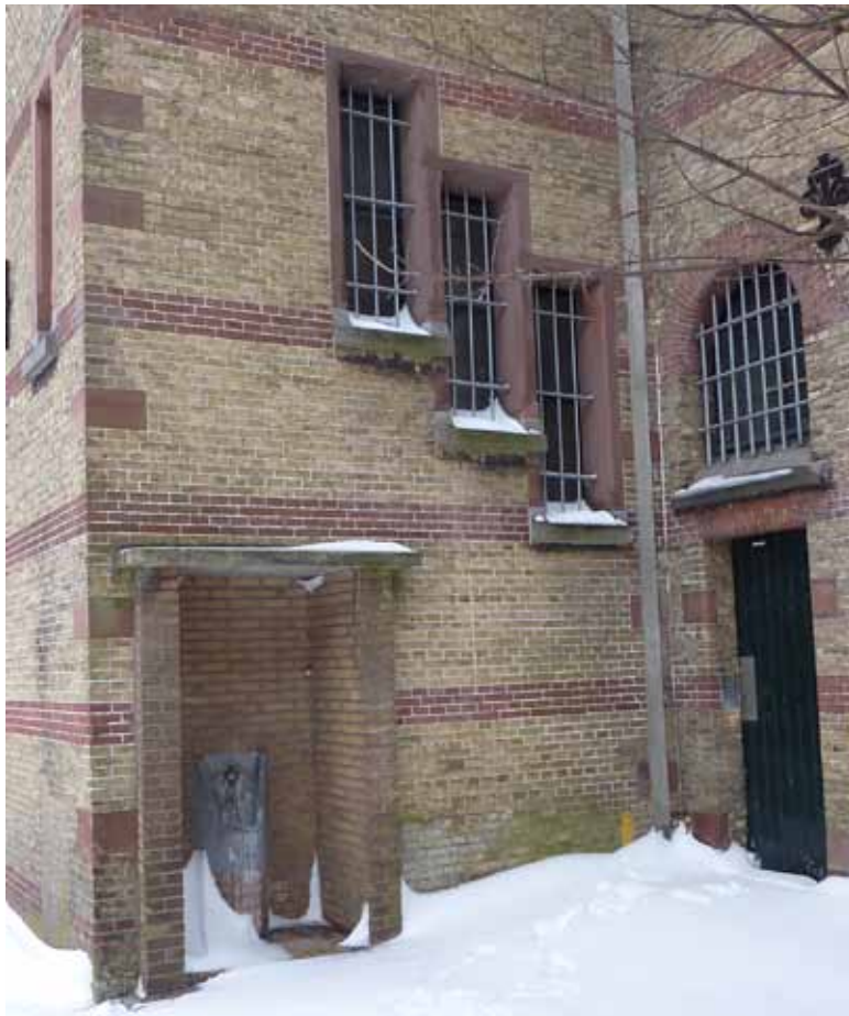
Afbeelding 14. In de noordgevel van het risalerende geveldeel is een nis gemetseld met daarin een hardstenen pissoir op een gemetselde voet (1948). De nis wordt gedekt door een betonnen dak. Rechts boven deze nis bevindt zich een getrapte venster met hardstenen onderdorpels en Udelfanger stijlen en bovendorpels, voorzien van vellingkanten en kapelletjes. Boven de oorspronkelijke doorgang (1873) links naast de negende vensteras is secundair een 20-ruits venster met halfronde beëindiging aangebracht.
