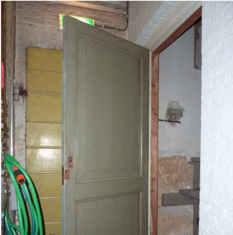
Afbeelding 56. Zicht op de paneel deur van de kast J0.08 gezien richting het oosten met daarachter de deur naar de tweede binnenplaats. De paneel deur stamt vermoedelijk uit de bouwtijd en gaf toegang tot een spreekvertrek.
