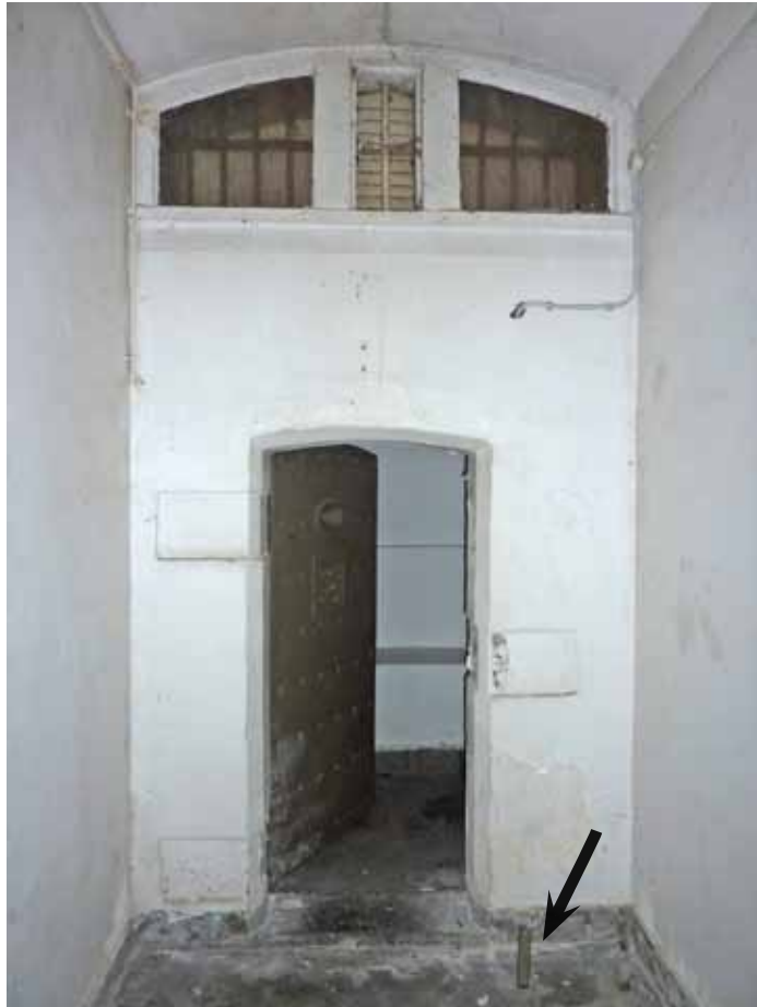
Afbeelding 125. Overzicht van cel 10.06 gezien richting het westen. Boven de doorgang bevindt zich een getoogd tweelicht voorzien van 10-ruits ramen. Tussen de witgesausde tussenstijlen bevindt zich een kleine ventilatieopening voorzien van stalen tralies. In ruimte 10.07 zijn de ramen dichtgezet en gepleisterd. Rechts naast de doorgang steken twee stalen pinnen uit de vloer (pijl) wat mogelijk duidt op de plaats van een vroeger closet.
