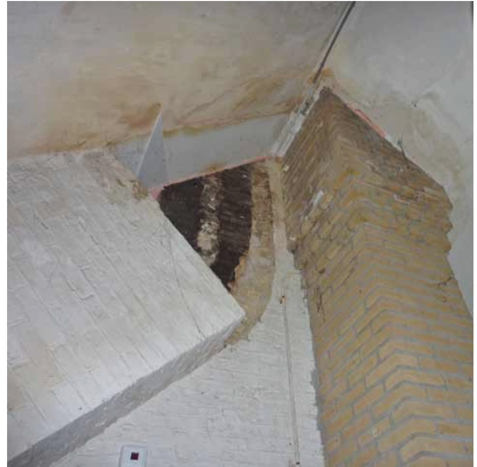
Afbeelding 118. Zicht op het oorspronkelijke rookkanaal (links) en het rookkanaal (rechts) dat rond 1975 werd aangebracht bij het vernieuwen van de onderliggende voorzieningen (zie Afbeelding 119).
