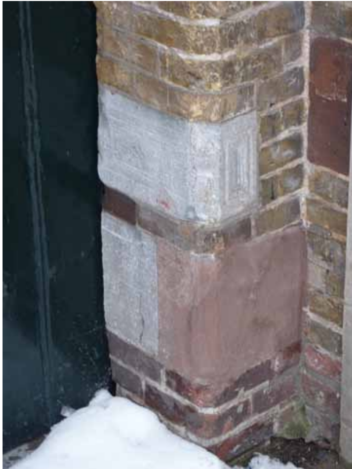
Afbeelding 18. Detail van de versierde hardstenen blokken - aan de aanslagzijde van de deur - van de oorspronkelijke deuropening in de elfde vensteras.
