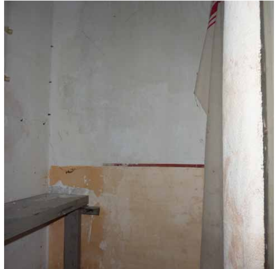
Afbeelding 57. Zicht in de kast van de voorgaande afbeelding richting het westen. De wand links werd in 1976 aangebracht, maar de westwand vermoedelijk in 1894. Deze geeft mogelijk een indruk van de oorspronkelijke wandafwerking van het bouwdeel met een oker geschilderde lambrisering en een rode bias. Op de wanden van de gang zijn eveneens okertinten aangetroffen onder het afbladderende recentere sauserwerk.
