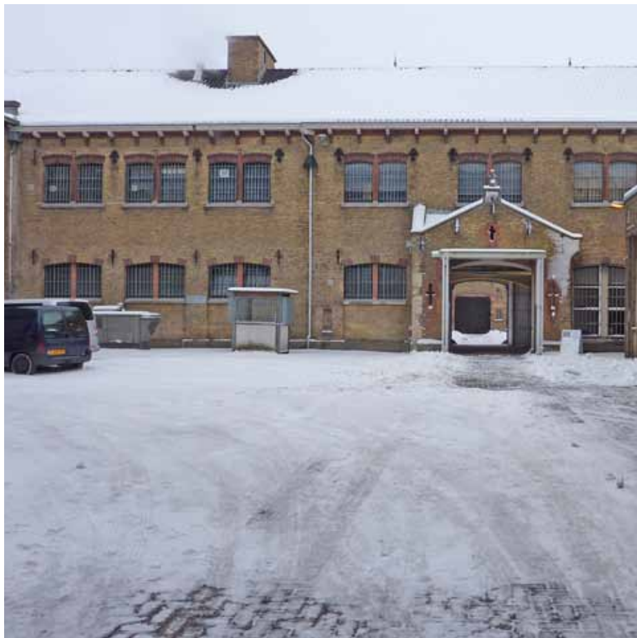
Afbeelding 4. Overzicht van de westgevel van de binnenplaatsvleugel van bouwdeel D, gezien vanaf de eerste binnenplaats.
