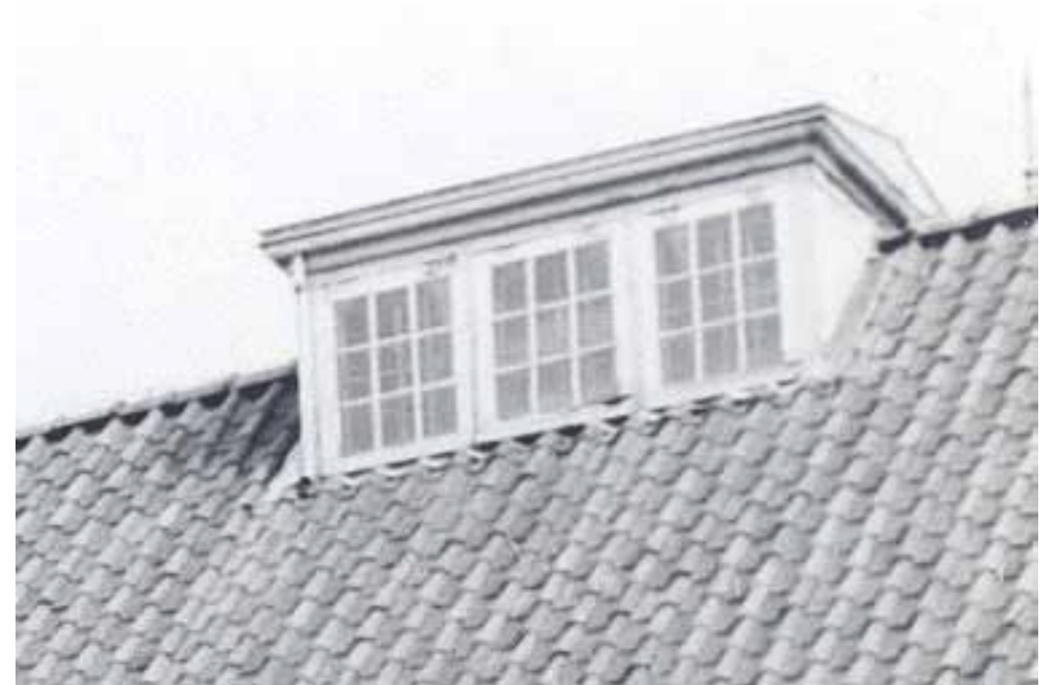
Afbeelding 120. Aanzicht van één van de dakkapellen (lantaarns) zoals deze tot 1974 aanwezig waren op de nok van de bouwdelen D en E. De plaatsen tekenen zich af in de vorm van lichter dakbeschot (zie Afbeelding 116). Foto: Collectie beeldbank Leeuwarden, documentnr.: FDBLHSPLA057.
