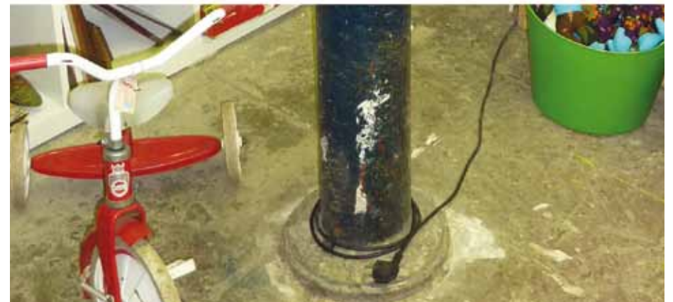
Afbeelding 60. Detail van een gietijzeren kolom voorzien van consoles en een cirkelvormige voetplaat van cement.
