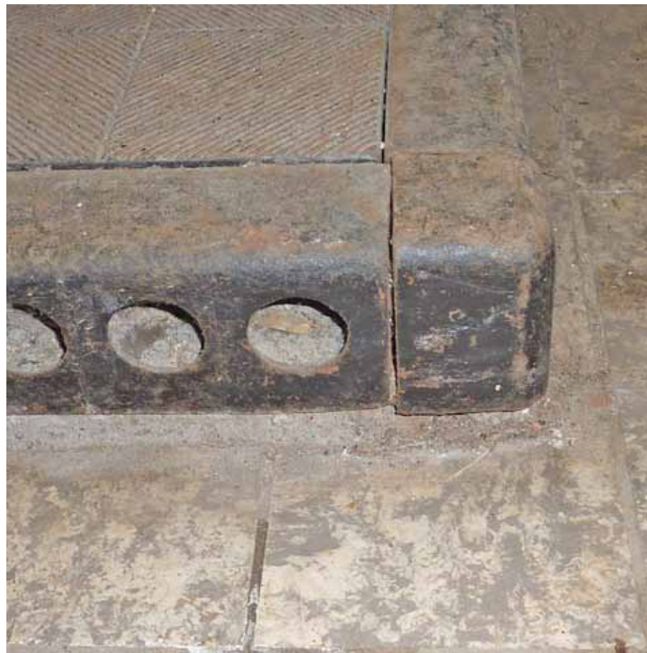
Afbeelding 52. Detail van de installatievloer (1957) in het midden van de ruimte. De vloer is opgebouwd uit holle stalen profielen en geribde stalen tegels.
