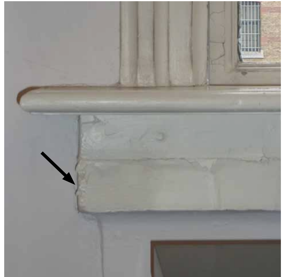
Afbeelding 87. Detail van de linker onderhoek van één van de vensters. De hoog geplaatste kleine vensters in de ruimten F1.24 en F1.25 werden verlengd (1949, zie Afbeelding 113), waarbij de huidige kozijnen, lijsten en vensterbanken werden aangebracht. De hardstenen onderdorpel (pijl) werd hierbij vermoedelijk herplaatst.
