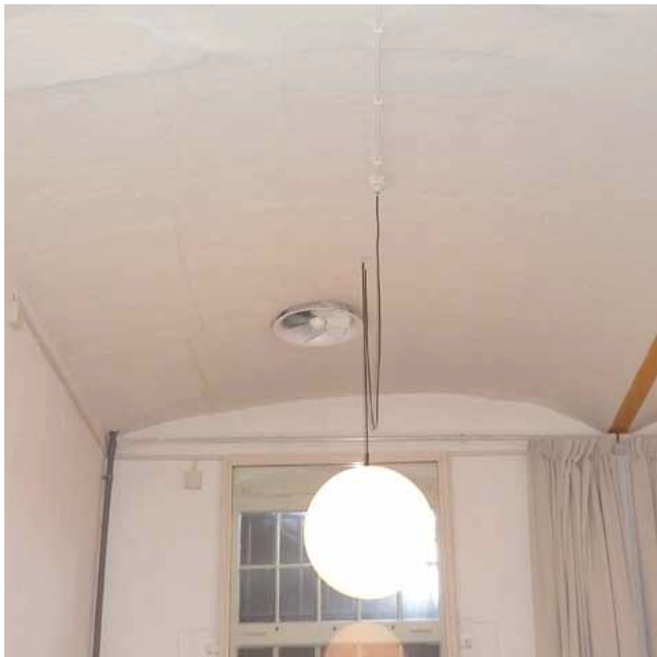
Afbeelding 91. Zicht op het meest westelijke troggewelf. Hier bevond zich direct na de bouw een trappenhuis, dat echter voor 1888 werd verwijderd (vergeleijk Afbeelding 109 en Afbeelding 111 met Afbeelding 118). Door het aanhelen van het gewelf ter plaatse van de spiltrap is de vorm niet helemaal gelijkmatig.
