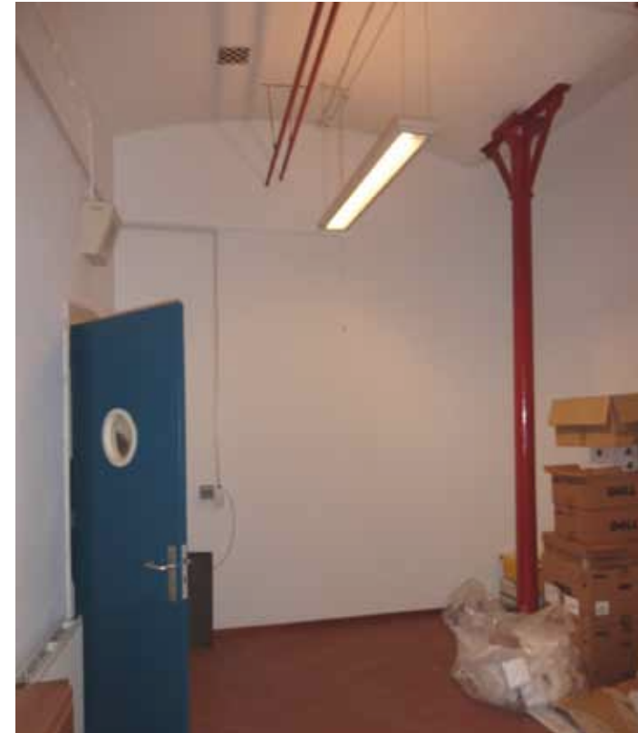
Afbeelding 33. Overzicht van ruimte F0.03 gezien richting het oosten.
