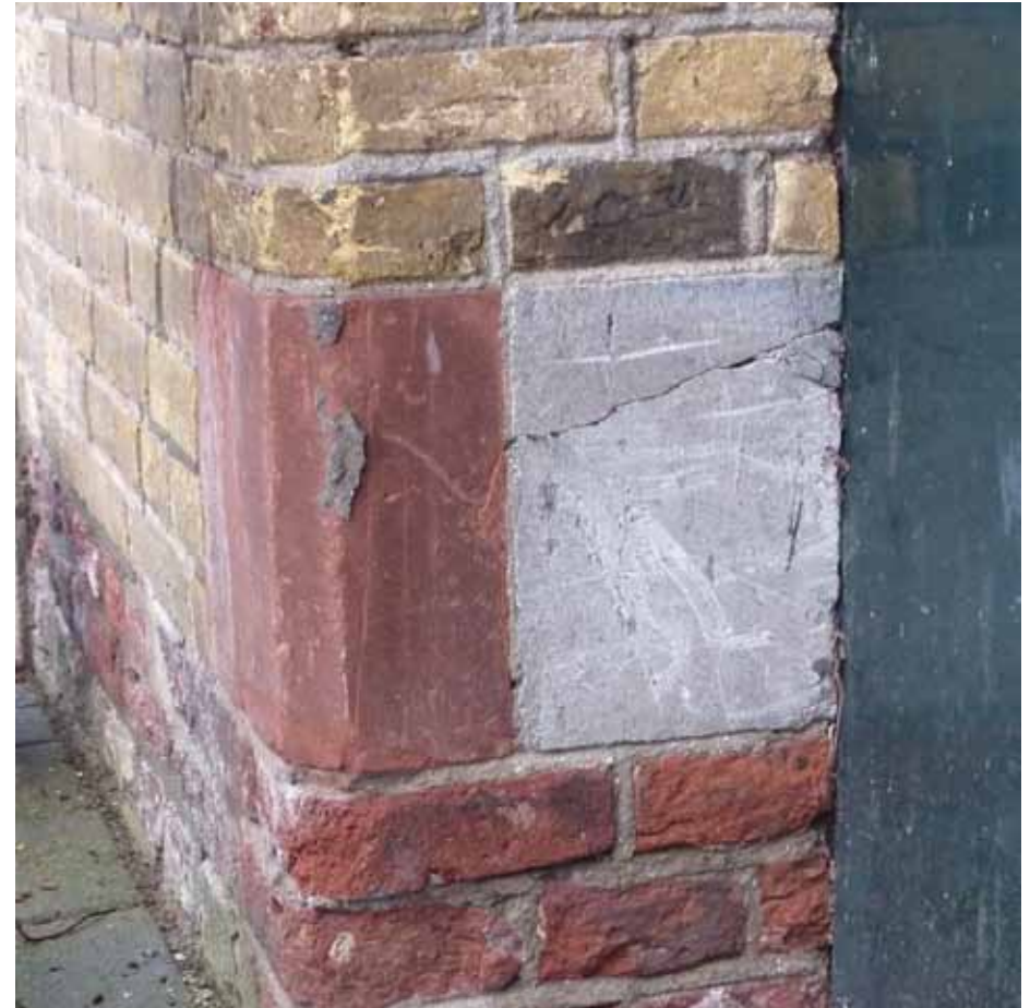
Afbeelding 13. Detail van de linker onderhoek van één van de toegangen in de westgevel. Het metselwerk is voorzien van geknipte voegen en ter plaatse van de doorgangen van vellingkanten. De gevels worden verlevendigd door blokken rode Udelfanger zandsteen. Omdat deze steen zacht is, zijn de dui-men van de deuren bevestigd in hardstenen blokken. Tevens zijn de blokken zandsteen op verschillende plaatsen gerepareerd met op kleur gebrachte mortel, die als gevolg van beregning van de gevel sporen op het metselwerk achterlaat.
