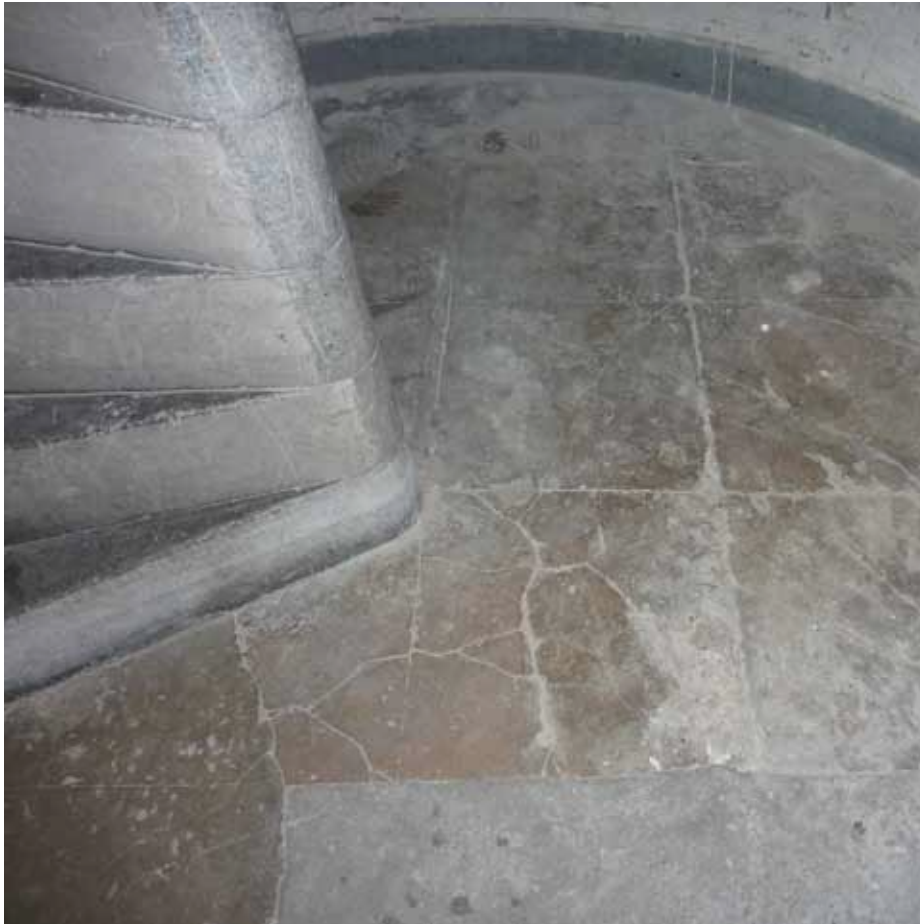
Afbeelding 25. De cementvloer van de begane grond is voorzien van ingekaste voegen op een raster van 50 x 50 cm. De vloer is gescheurd en diverse malen gerepareerd. De donker gezoete massieve harstenen treden van de eerste vlucht zijn uitgesleten.
