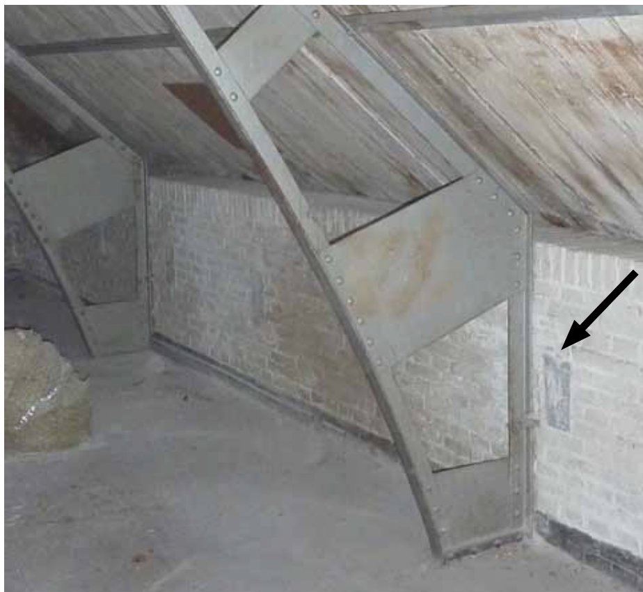
Afbeelding 99. Zicht op de voet van één van de ijzeren spanten. De T-profielen zijn door middel van vastgeklonken ijzeren platen tot spanten samengesteld. Rechts van het spant is de achterzijde van één van de hardstenen gootconsoles zichtbaar.
