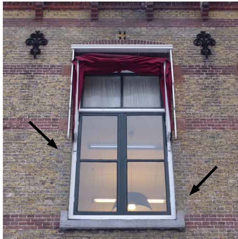
Afbeelding 15. Overzicht van het derde venster van links, links van de poort. Een aantal vensters werd verlengd (1949) bij het wijzigen van de functie van de achterliggende vertrekken (vergelijk met Afbeelding 5 en Afbeelding 113).
