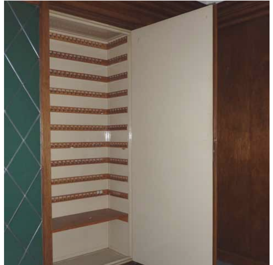
Afbeelding 77. Achter de middelste schuifdeur rechts van de schouw bevindt zich een door een stalen deur af te sluiten sleutelkluis. De buitenzijde van de deur is voorzien van houtimitatie.
