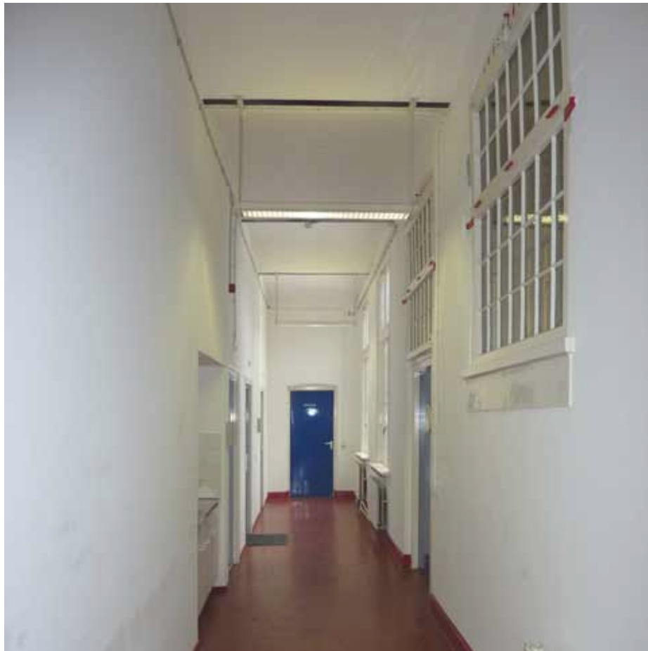
Afbeelding 57. Overzicht van ruimte F1.08 gezien richting het noorden. Ter plaatse van de derde vensteras van links is de borstwering doorgebroken en zijn de onderste ruiten en onderdorpel van het venster verwijderd ten behoeve van een toegangsdeur (1988) naar de verbindingsgang met bouwdeel F.
