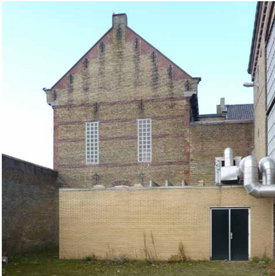
Afbeelding 10. Overzicht van de kopgevel (oost) van de oostelijke aanbouw.
