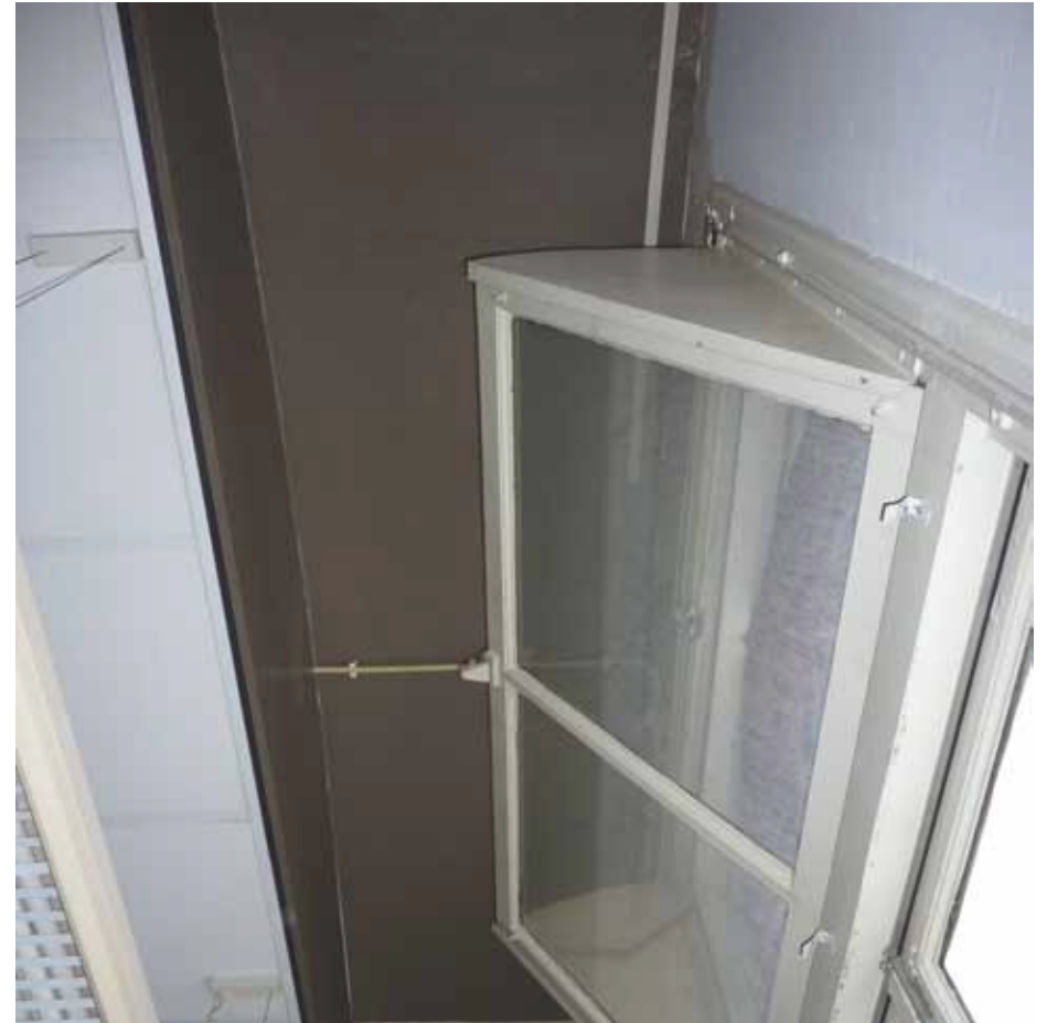
Afbeelding 89. Detail van één van de vensters in de westgevel. Het systeemplafond (1988) is niet tot tegen westgevel aangebracht, om de bovenramen van de vensters te kunnen openen. Hier zijn de troggewelven nog in het zicht. Enkel het valraam van het rechter venster in ruimte F1.24 is voorzien van een geleiding.
