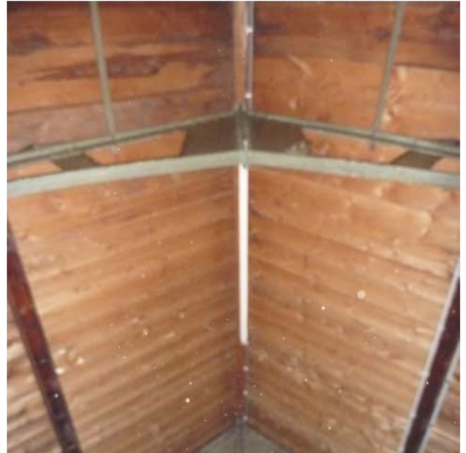
Afbeelding 95. Zicht op het lichter gekleurde dakbeschoot ter plaatse van de nok. In elk van de drie zolderruimten bevond zich tot 1974 een dakkapel op de nok van het zadeldak (vergelijk met Afbeelding 96).
