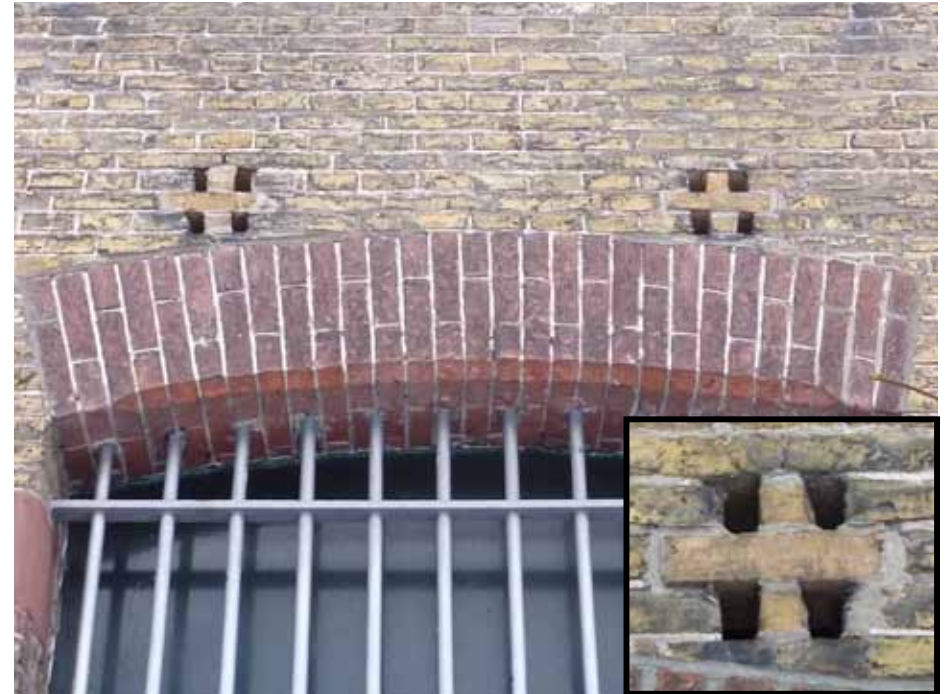
Afbeelding 19. Boven verschillende vensters bevinden vier kleine openingen. Dit is mogelijk één rechthoekige opening geweest, voorzien van een rooster ten behoeve van de ventilatie van de achterliggende vloerconstructie. De horizontale en verticale stenen die de opening in vier delen zijn secundair (zie inzet). Ter plaatse van de twee openingen waar zich in het ontwerp (zie Afbeelding 113) een deur bevond, is de segmentboog aan de onderzijde voorzien van een vellingkant met kapelletjes. Deze vellingkant is bij het tweede - thans - venster rechts van de poort aangeheeld.
