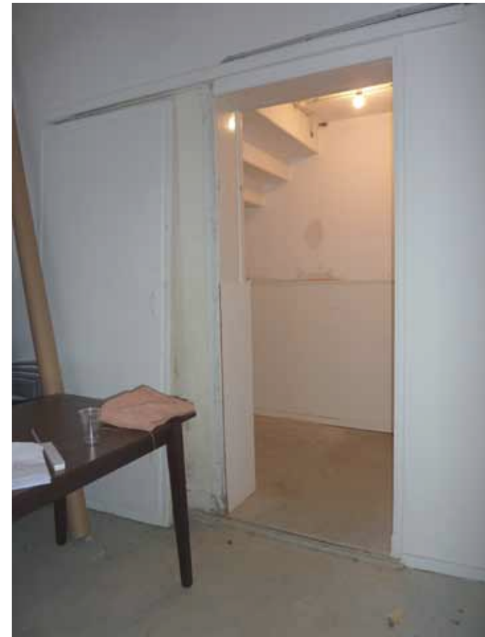
Afbeelding 39. Overzicht van ruimte F0.12 gezien richting het oosten. Het onder het trappenhuis gelegen gedeelte is door middel van een schuifdeur af te sluiten.
