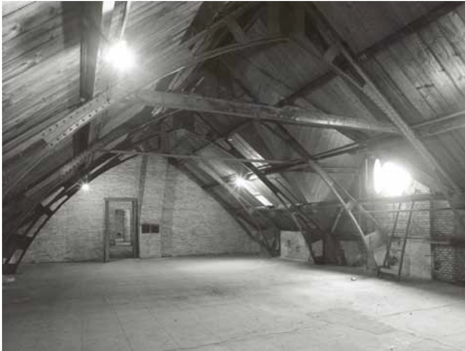
Afbeelding 96. Overzicht van ruimte F2.02 gezien richting het zuidwesten in februari 1983. Foto: Collectie Beeldbank Leeuwarden, documentnr.: FDBLH-SPLB080.
