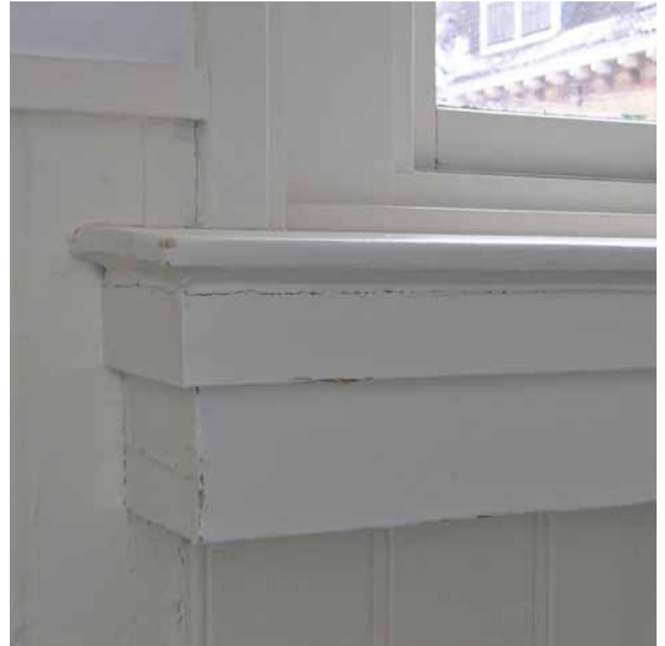
Afbeelding 67. Detail van de linker onderhoek van het venster in het noordelijke deel van ruimte F1.15. Ook hier werd het schuifvenster gewijzigd, maar de detaillering van de architraven en vensterbank zijn eenvoudiger. Dit houdt waarschijnlijk verband met de oorspronkelijke functie van de ruimte (zie Afbeelding 111).
