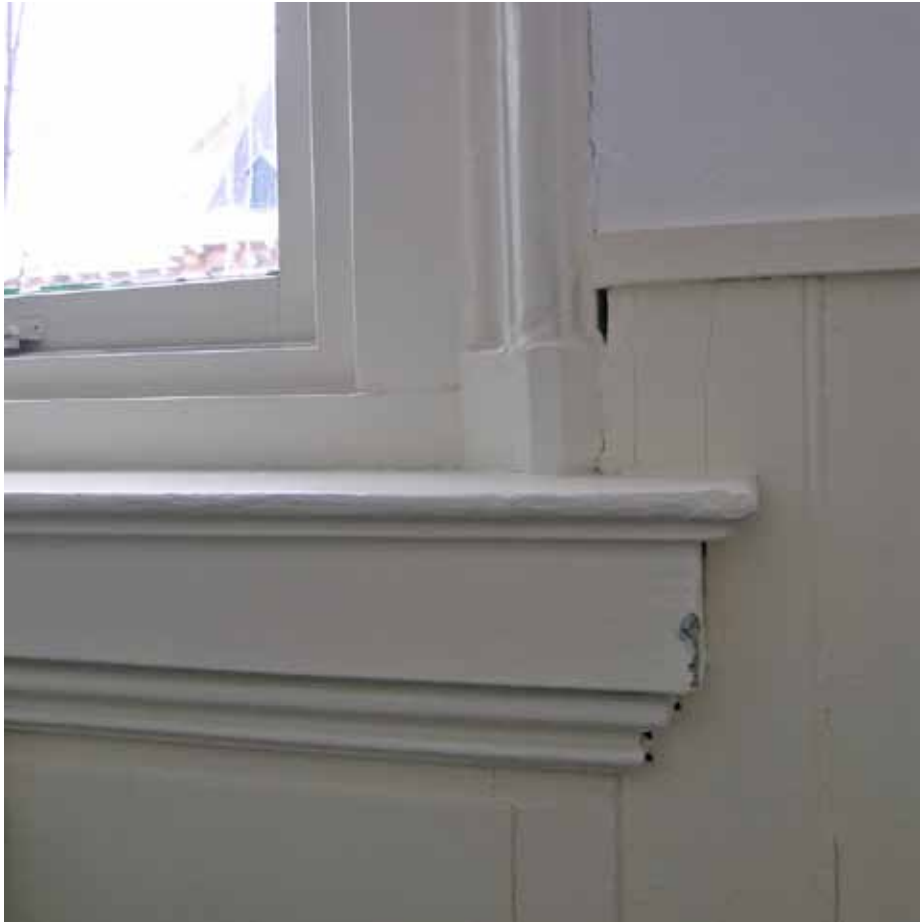
Afbeelding 66. Detail van de rechter onderhoek van één van de twee vensters in het zuidelijke deel van ruimte F1.15. Het onderraam van het oorspronkelijke schuifvenster werd vervangen door twee stolpramen. De architraven en vensterbank werden herplaatst, de lambrisering onder het venster paste men aan. De oorspronkelijke uitvoering van de lambrisering is in een aantal ruimten van bouwdeel G nog aanwezig.
