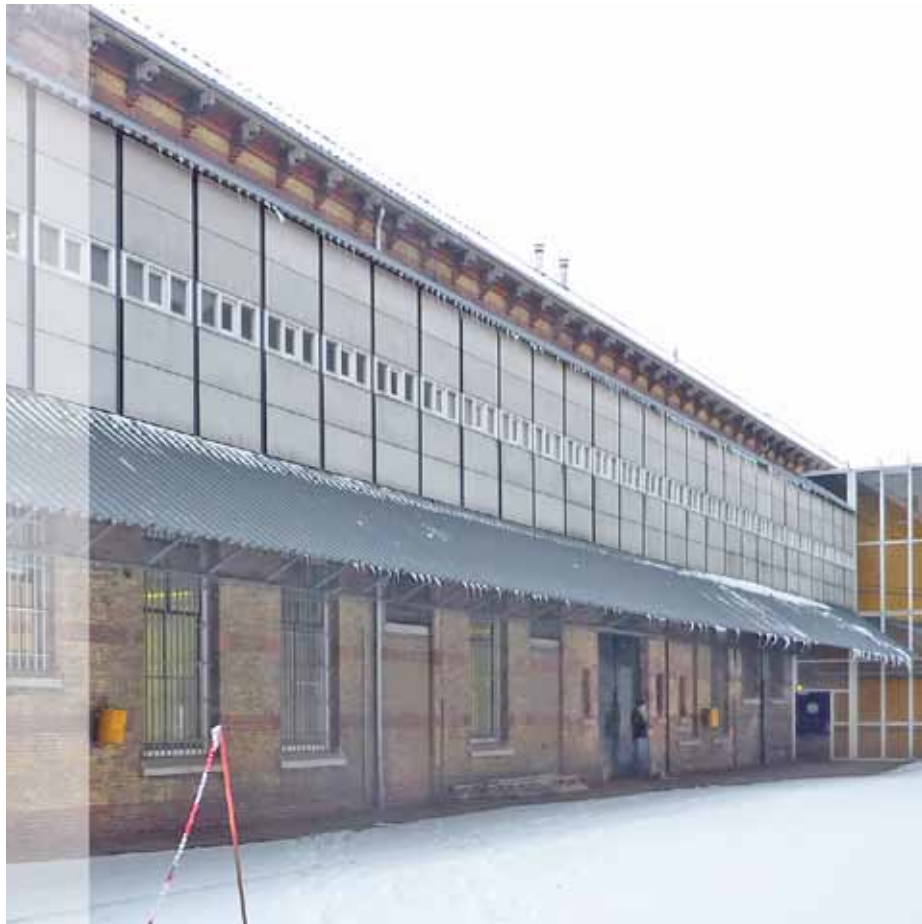
Afbeelding 6. Overzicht van de oostgevel. Ter hoogte van de eerste verdieping werd in 1988 een gang aangebracht, waardoor een groot deel van de gevel aan het zicht werd onttrokken.
