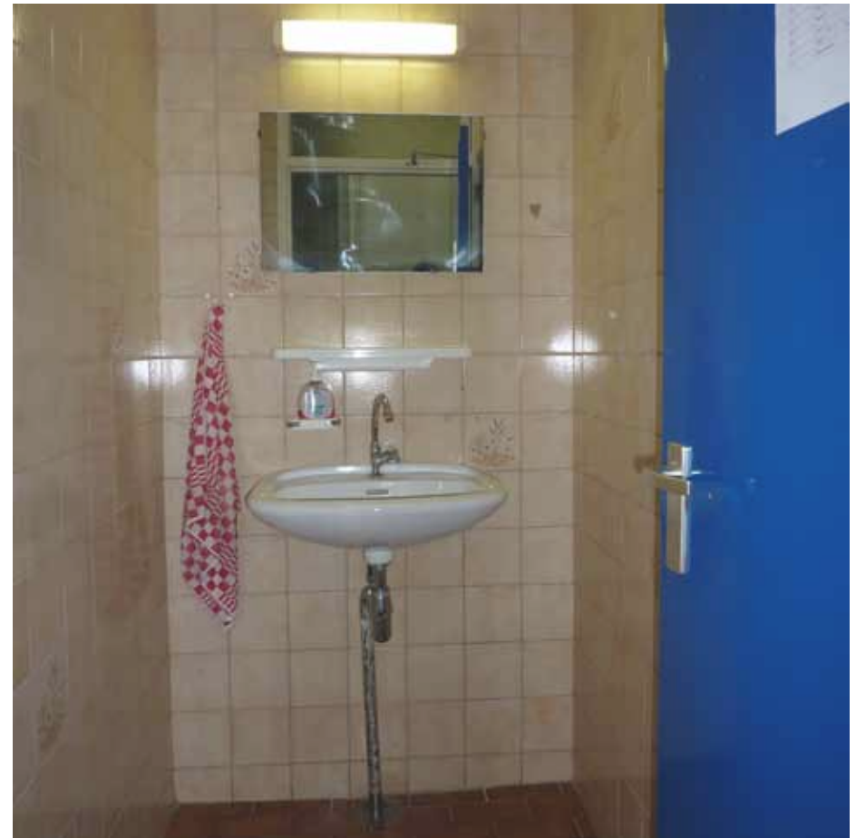
Afbeelding 74. Overzicht van één van de voorruimten van de toiletten.
