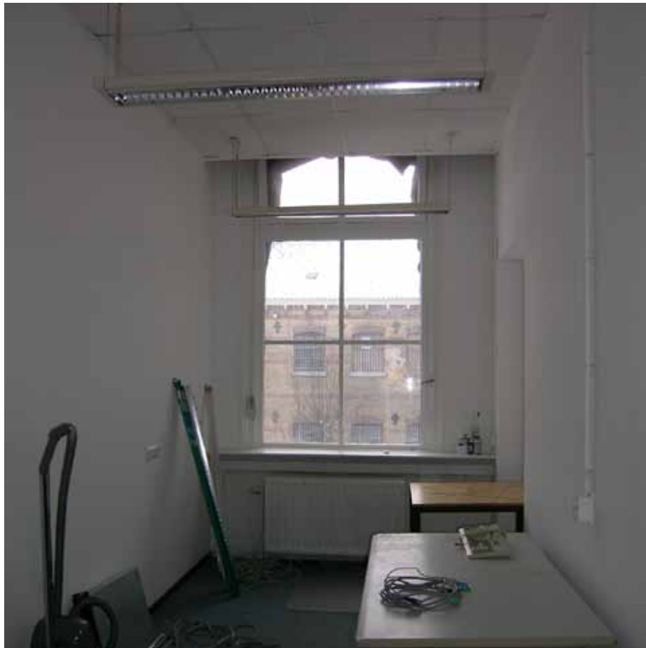
Afbeelding 59. Overzicht van ruimte F1.10 gezien richting het westen. De nis rechts is een dichtgezette (1957) opening naar de voormalige archiefruimte. Het oorspronkelijke schuifvenster werd vervangen (1957) door een 4-ruits vast onder- en 2-ruits naar binnen kleppend bovenraam. Het raam is te openen door middel van de wartel op de rechter stijl.
