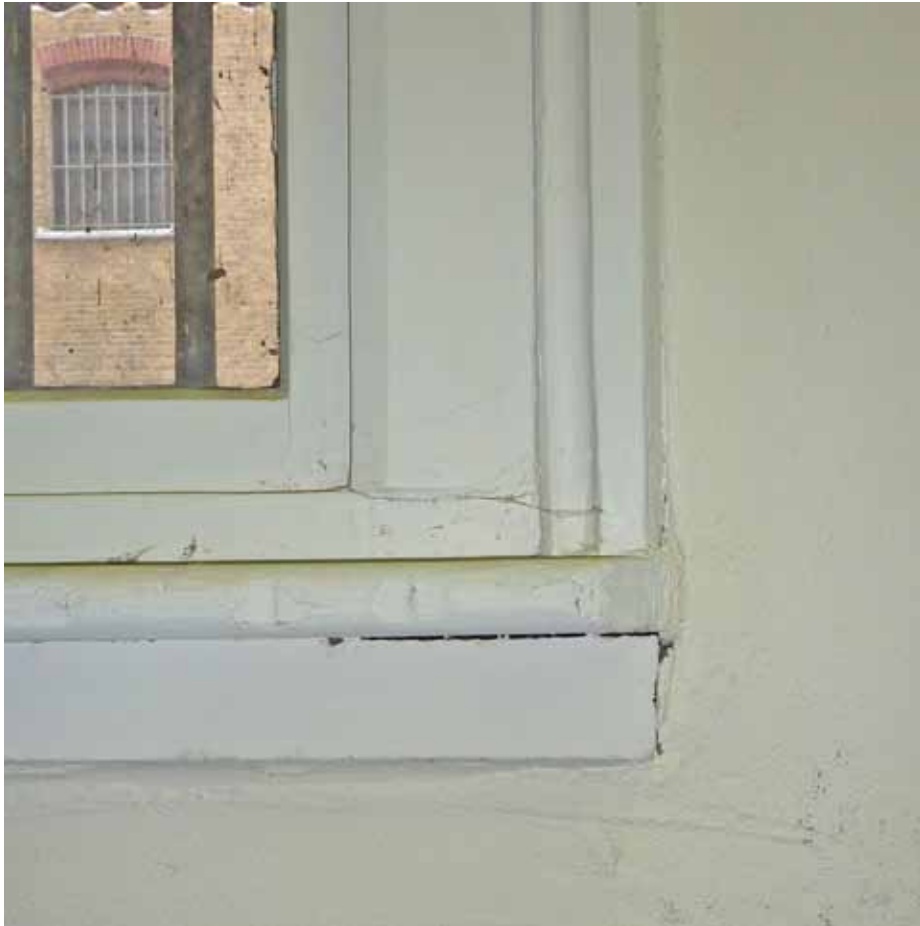
Afbeelding 31. Detail van de aftimmering van het 6-ruits schuifvenster in de oostgevel. De profilering van de architraven en vensterbank is eenvoudig.
