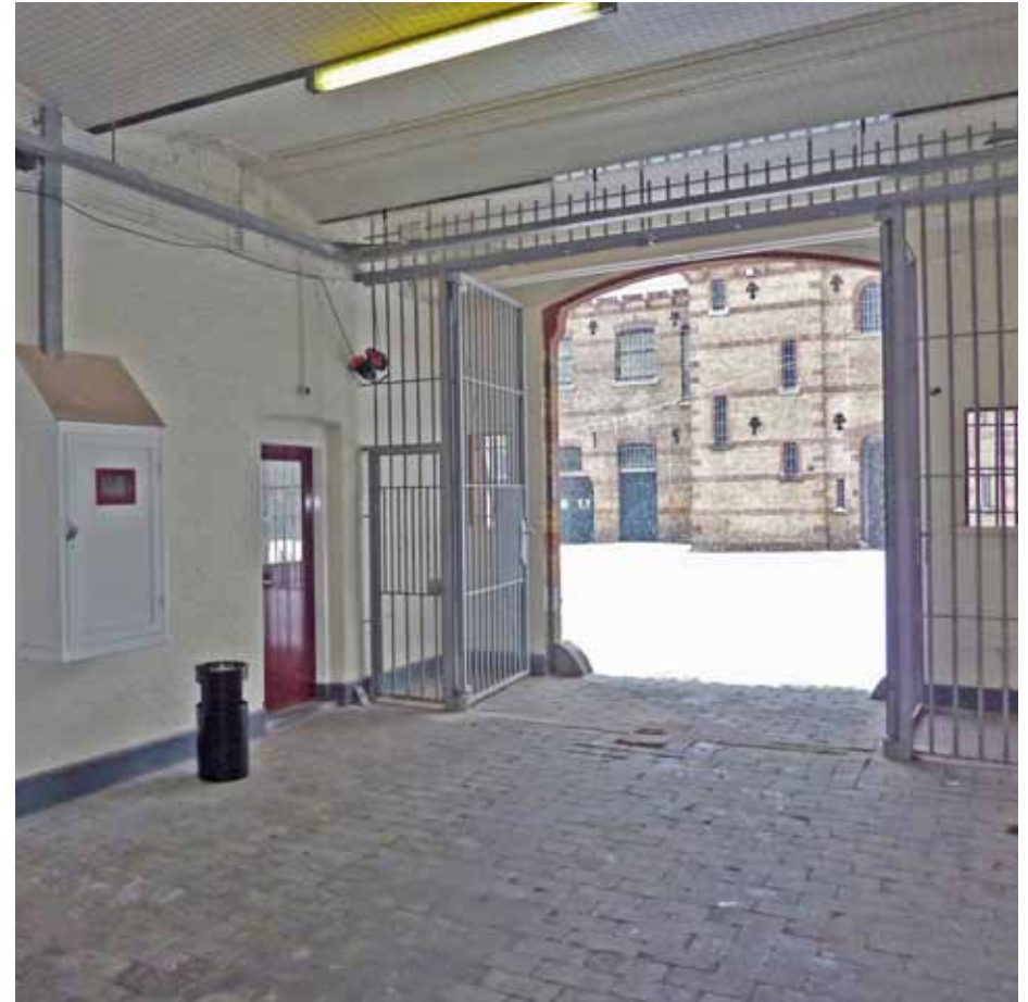
Afbeelding 21. Overzicht van de poort richting het westen. De oorspronkelijk aan deze zijde open doorgang wordt afgesloten door een stalen hekwerk (1974). De rode deur links bevindt zich in een oudere doorgang (1875).
