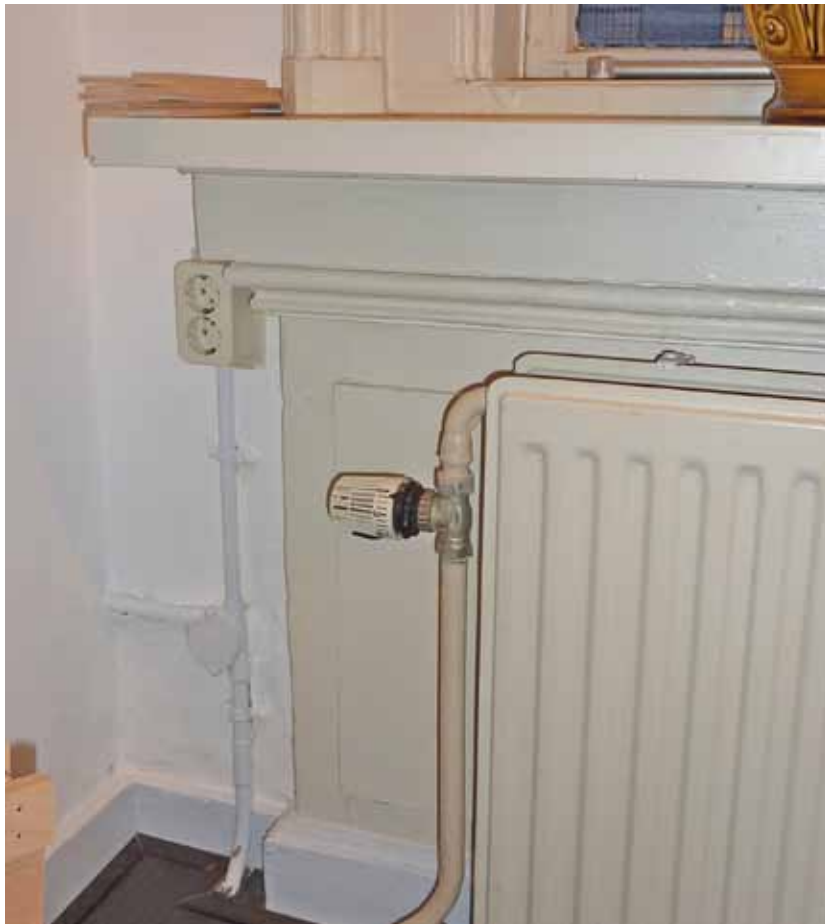
Afbeelding 83. Detail van de onderzijde van het linker venster in de westwand. De lambriseringen onder de vensters zijn afkomstig uit de bouwtijd (1875), maar het bovenste deel van de vensterbank en het vlakke triplex paneel zijn secundair (1974). Deze ruimte is één van de drie ruimten op de verdieping die van een luxere afwerking werd voorzien. In de voormalige directiekamer (ruimte F1.22) werd de oorspronkelijke betimmering in het derde kwart van de 20 ste eeuw verwijderd, maar in de gang en het zuidelijke deel van ruimte F1.15 is deze nog aanwezig (zie Afbeelding 66).
