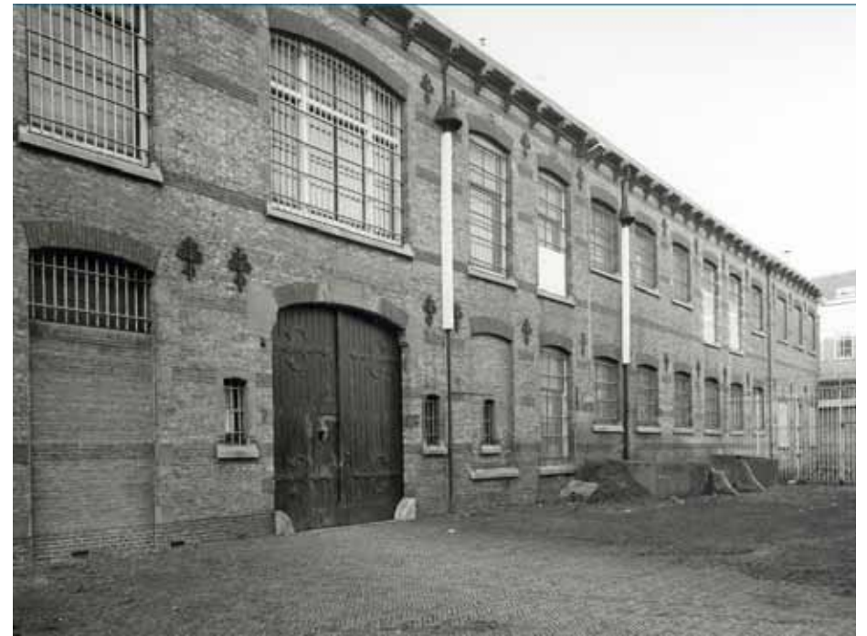
Afbeelding 103. Overzicht van de oostgevel in februari 1983. Foto: Collectie Beeldbank Leeuwarden, documentnr.: FDBLHSPLB030.
