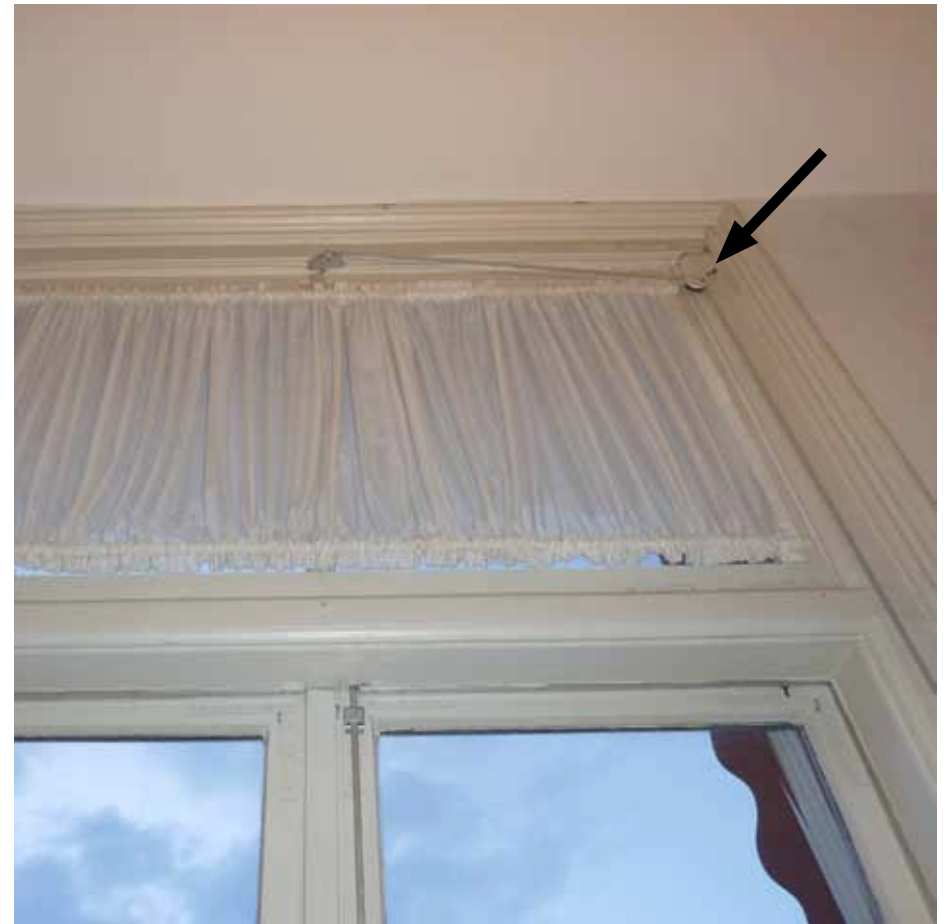
Afbeelding 84. Zicht op de bovenzijde van één van de vensters in de westgevel. Het naar binnen vallende bovenraam is te openen middels een via een wartel te bedienen katrolletje (zie pijl).
