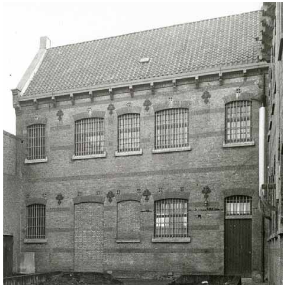
Afbeelding 9. Overzicht van de noordgevel van de oostelijke uitbouw in februari 1983 waarop de oorspronkelijke indeling van de gevel nog zichtbaar is. De linker deur en het raam ernaast waren reeds dichtgezet, maar de twee vierkante vensters en het pleisterwerk waren nog niet aangebracht. Foto: Collectie Beeldbank Leeuwarden, documentnr.: FDBLHSPLB031.
