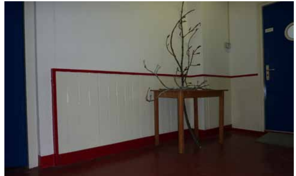
Afbeelding 56. Zicht op de lambrisering rechts van de doorgang in de zuidwand. De houten kraaldelen bezitten een werkende breedte van 11,5 cm en zijn tevens in verschillende ruimten aan de westgevel aangebracht.
