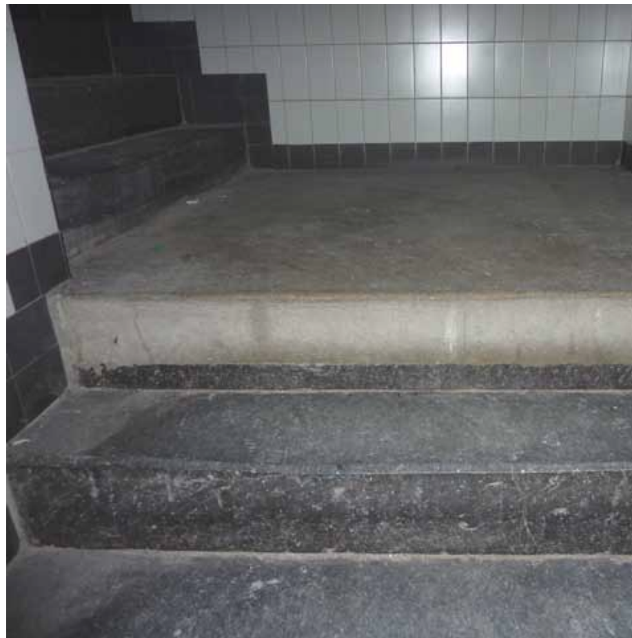
Afbeelding 44. Zicht op het tweede bodes en links de derde steek van de trap. Deze twee steken en bordes bevinden zich op hun oorspronkelijke plaats (1875), maar het bordes werd aangeheeld met beton.
