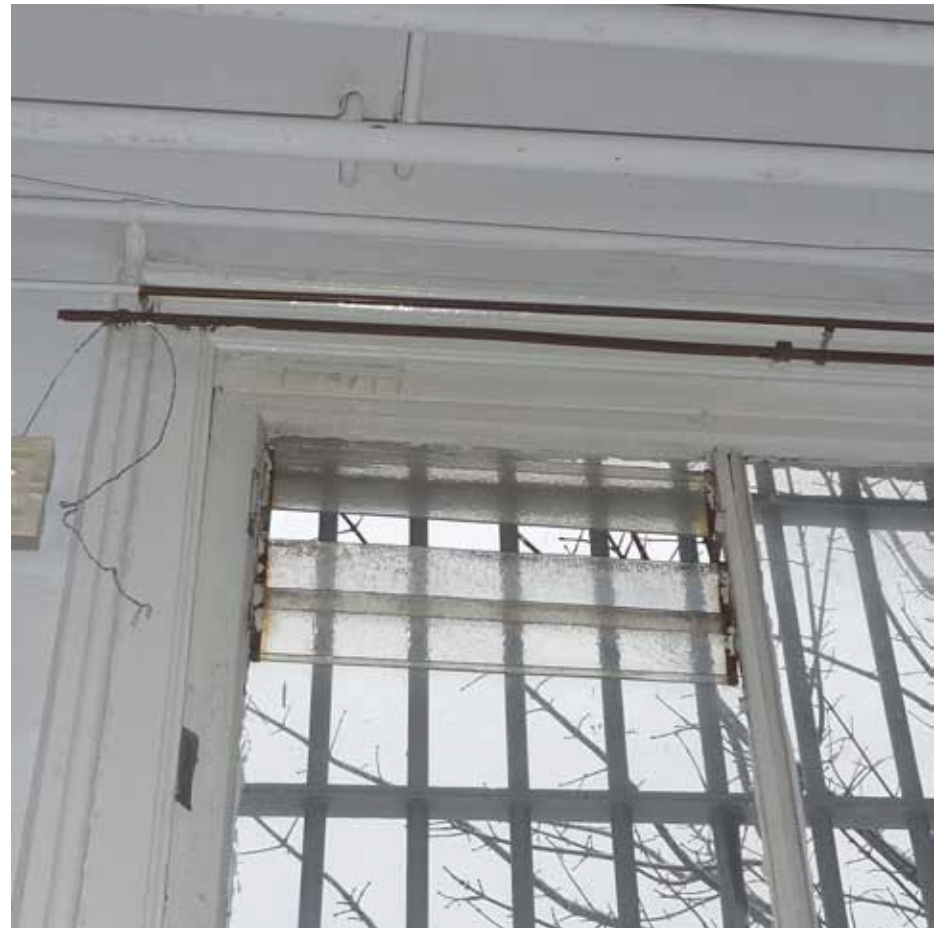
Afbeelding 41. Detail van de voorgaande afbeelding. Het venster is voorzien van eenvoudige lijsten en in de linker bovenruit zijn twee ventilatieschoepjes aangebracht.
