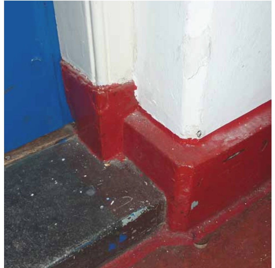
Afbeelding 73. Detail van de rechter onderhoek van de middelste deur in de westwand van het zuidelijke deel van de gang (naar ruimte F1.23). Het deuropening werd aangebracht bij het verlengen van de gang in het laatste kwart van de 19 de eeuw. Het kozijn is voorzien van een kraal en hardstenen neuten en dorpel.
