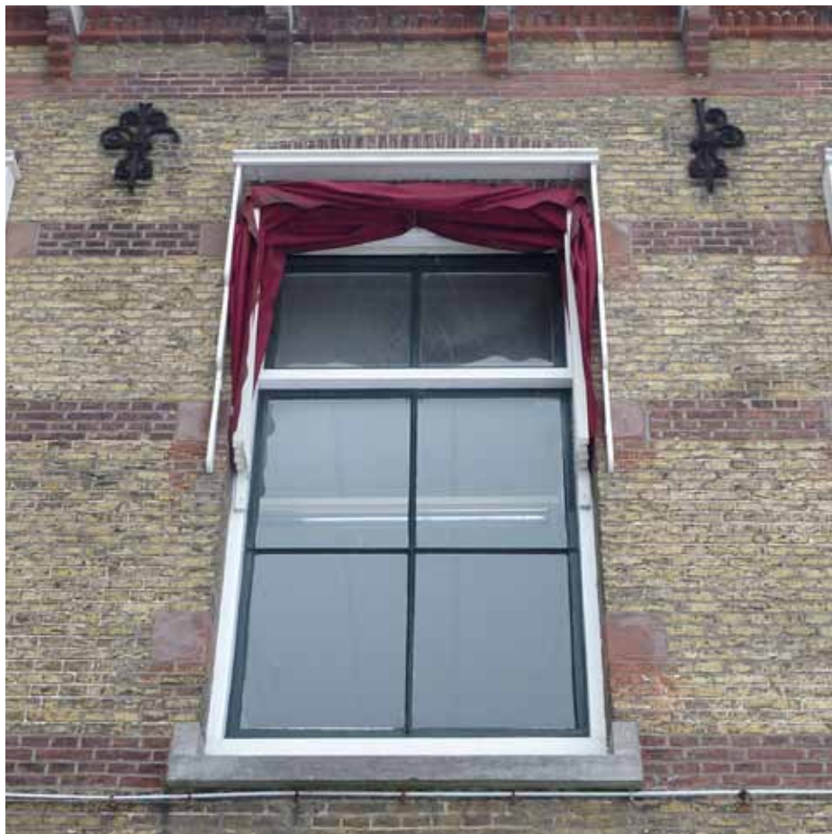
Afbeelding 14. Overzicht van het meest linker venster ter hoogte van de eerste verdieping. Dit venster was ontworpen als groot venster en bezit zes Udel-fanger zandsteen blokken. Tevens bevindt zich in dit kozijn - net als in het kozijn direct rechts ervan - een 4-ruits onderraam (1957) in plaats van 2-ruits stolpramen (1974).
