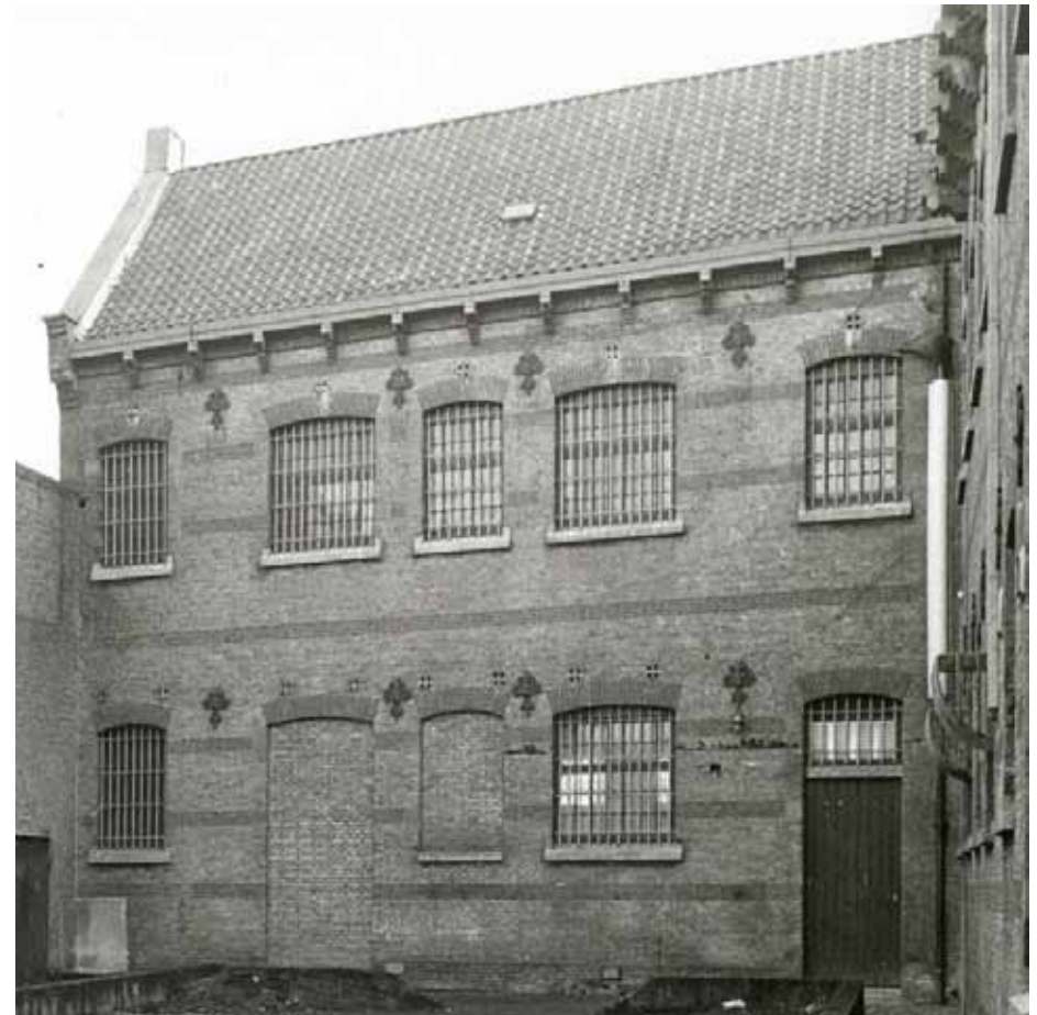
Afbeelding 105. Overzicht van de noordgevel van de oostelijke uitbouw in februari 1983, waarop de oorspronkelijke indeling van de gevel nog zichtbaar is. De linker deur en het raam ernaast waren reeds dichtgezet, maar de twee vierkante vensters en het pleisterwerk waren nog niet aangebracht. Foto: Collectie Beeldbank Leeuwarden, documentnr.: FDBLHSPLB031.
