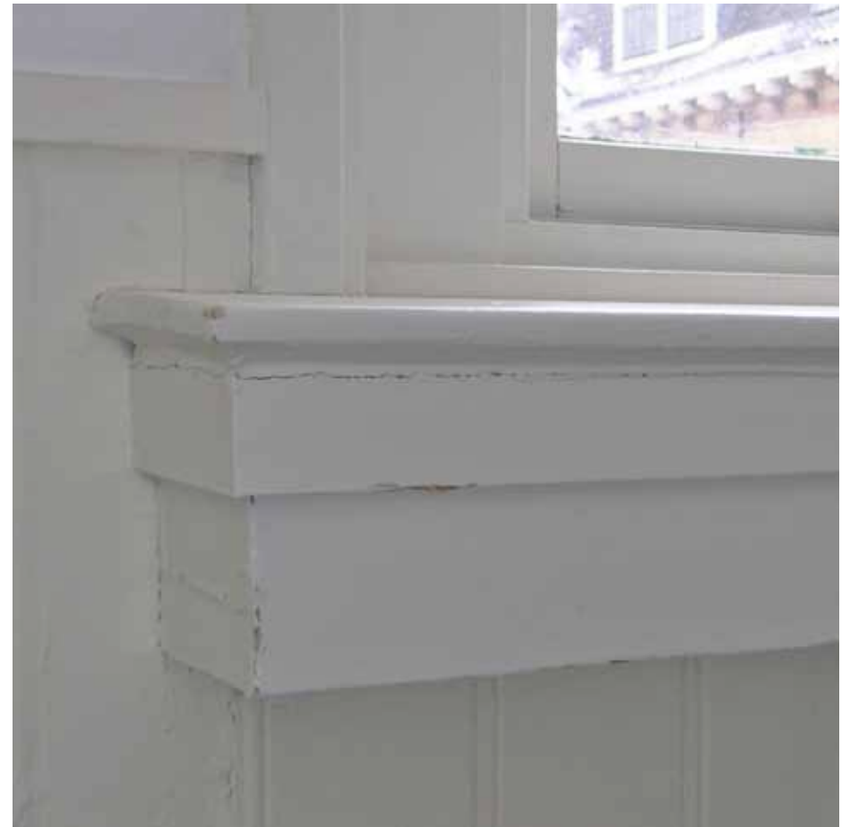
Afbeelding 108. Detail van de linker onderhoek van het venster in het noordelijke deel van ruimte F1.15. Ook hier werd het schuifvenster gewijzigd, maar de detaillering van de architraven en vensterbank zijn eenvoudiger. Dit houdt waarschijnlijk verband met de oorspronkelijke functie van de ruimte (zie Afbeelding 111).
