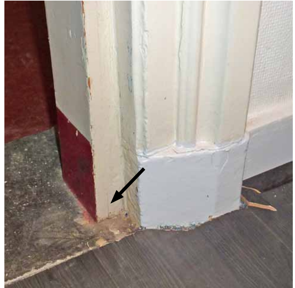
Afbeelding 82. Detail van de onderzijde van de rechter kozijnstijl van de toegangsdeur op de voorgaande afbeelding. Het kozijn is voorzien van geprofileerde lijsten en houten neuten. De sponning van het kozijn is secundair opgedikt.
