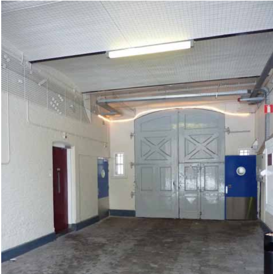
Afbeelding 20. Overzicht van de poort (ruimte P0.12) gezien richting het oosten. De blauwe patrijspoortdeuren werden in 1988 aangebracht, waarbij de linker deur in een bestaande (1875) opening werd geplaatst.
