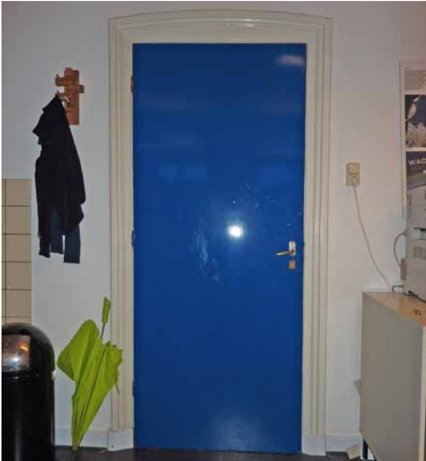
Afbeelding 81. Zicht op de toegangsdeur in de oostwand van de ruimte. De doorgang is tegelijk met de wand aangebracht in het laatste kwart van de 19 de eeuw bij het verlengen van de gang (vergelijk Afbeelding 111 met Afbeelding 118). Het kozijn en lijstwerk zijn origineel, de deur is secundair (1957), waarbij de sponning werd opgedikt.
