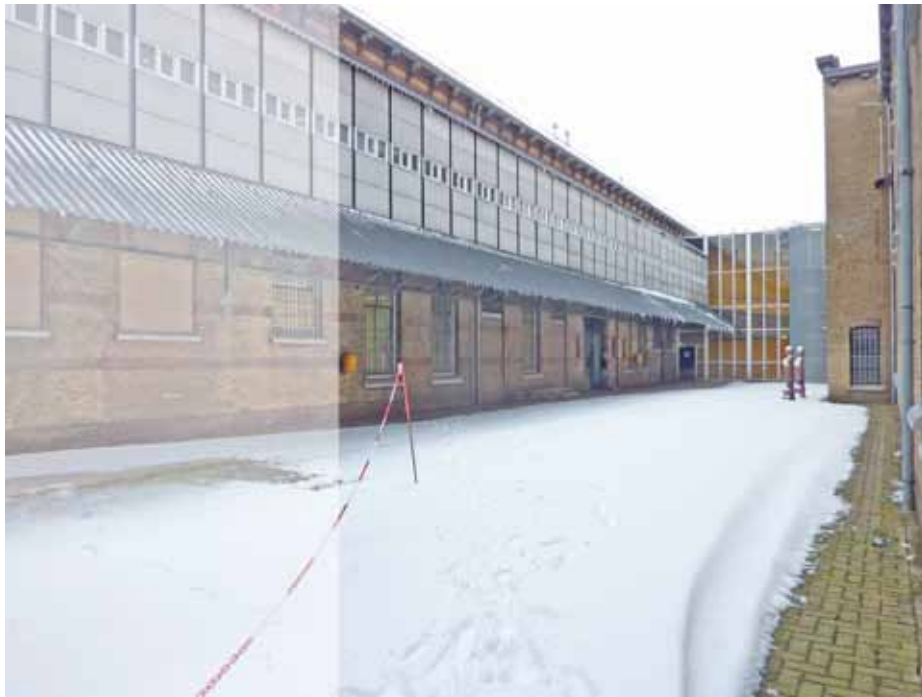
Afbeelding 102. Overzicht van de huidige situatie van de oostgevel. Ter hoogte van de eerste verdieping werd in 1988 een gang aangebracht, waardoor een groot deel van de gevel aan het zicht werd onttrokken.
