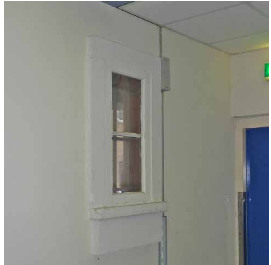
Afbeelding 32. Het kleine venster geheel rechts in de oostwand. De vensterbank, stijlen en bovendorpel komen naar voren ten opzichte van het omringende pleisterwerk. In het ontwerp van Metzelaar bevond zich op deze plaats een privaat, voorzien van een 2 cm dikke portlandcementbepleistering.
