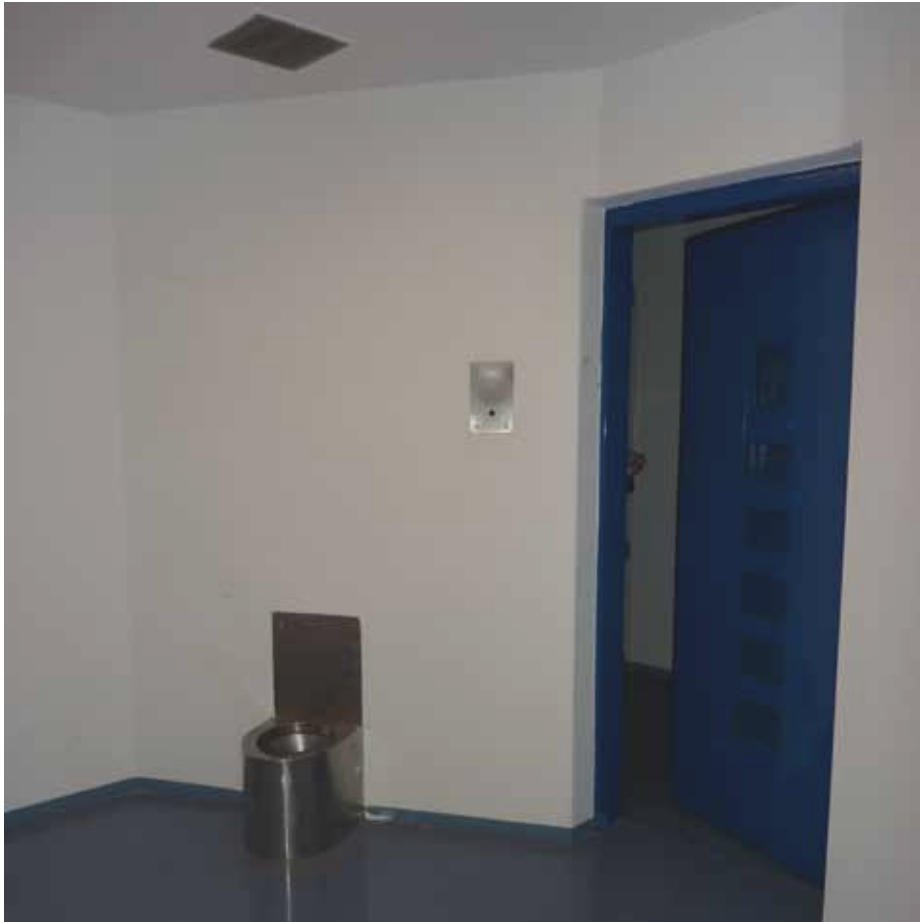
Afbeelding 54. Interieur van één van de isoleercellen. De inrichting bestaat uit een rvs toilet (1997). De ventilatie en verwarming van de cellen vindt plaats door middel van roosters in het plafond.
