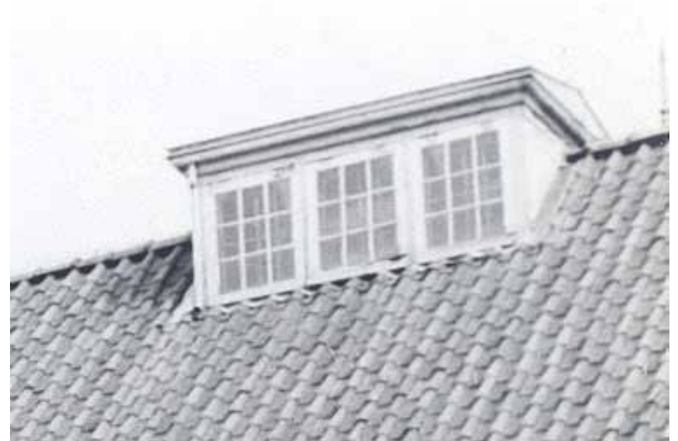
Afbeelding 97. Aanzicht van één van de dakkapellen (lantaarns) zoals deze tot 1974 aanwezig waren op de nok van de bouwdelen D en E. De plaatsen tekenen zich af in de vorm van lichter dakbeschot. Foto: Collectie Beeldbank Leeuwarden, documentnr.: FDBLHSPLA057.
