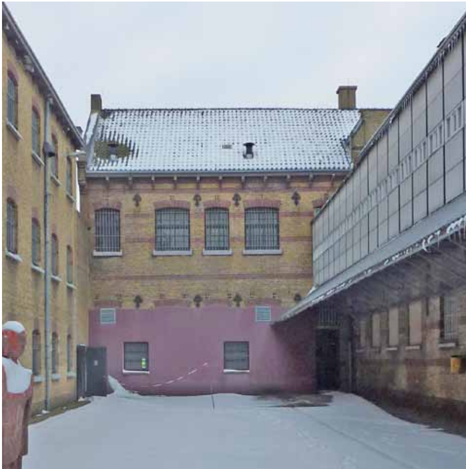
Afbeelding 104. Overzicht van de huidige situatie van de noordgevel van de oostelijke uitbouw. De gevel werd in 1997 ter hoogte van de begane grond voorzien van een pleisterlaag, waardoor de oorspronkelijke gevelindeling deels aan het zicht werd onttrokken. Het verwijderen van de pleisterlaag, herstellen van het metselwerk en heropenen van de vensters zou de daglichttoetreding van de achterliggende ruimten verbeteren.
