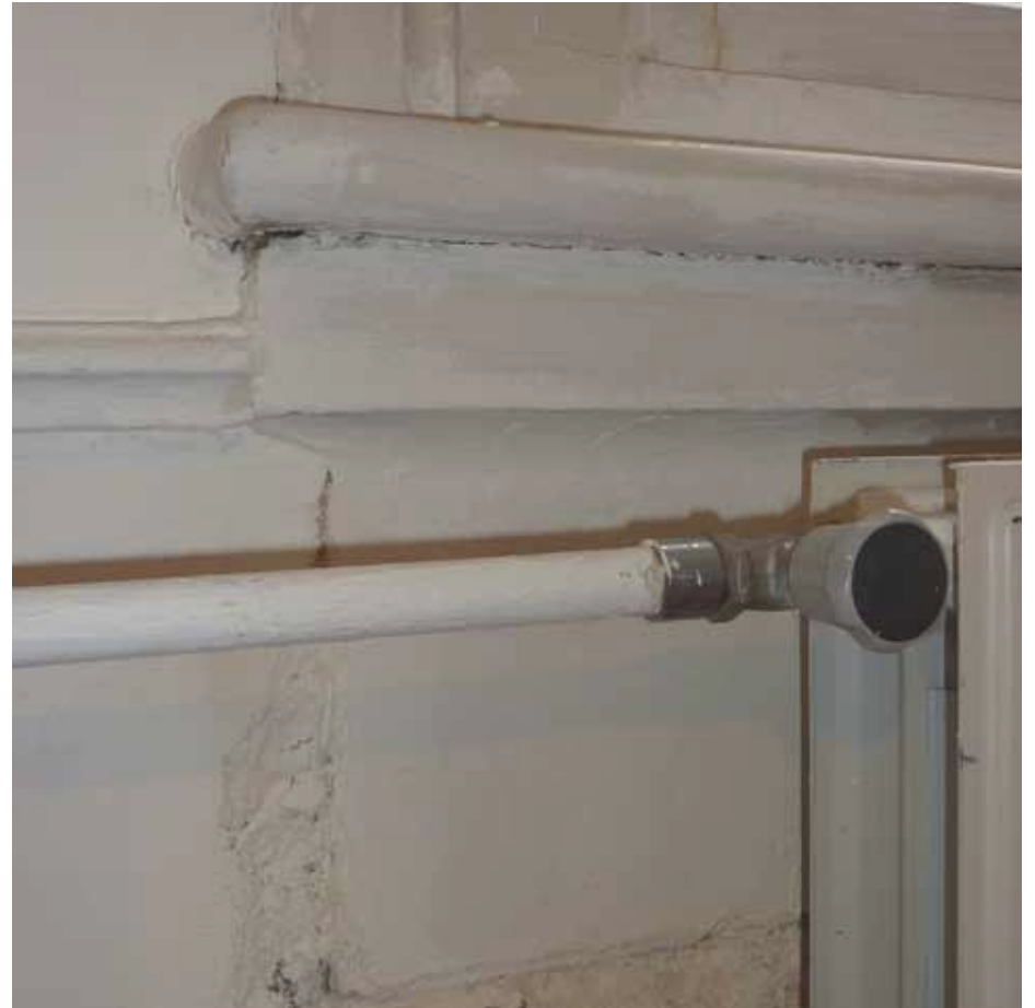
Afbeelding 47. Onderdetail van één van de vensters in de westwand. De houten vensters werden geplaatst op hardstenen onderdorpels die op verschillende plaatsen - gedeeltelijk - achter het pleisterwerk schuilgaan.
