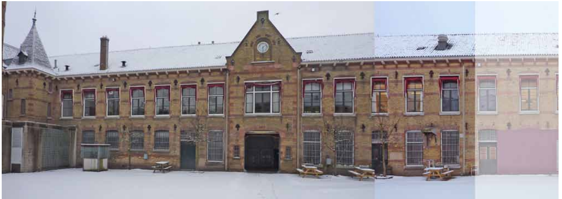
Afbeelding 4. Overzicht van de westgevel van bouwdeel E. Het lichtere gedeelte rechts - vanaf de zesde vensteras rechts van de poort - behoort tot bouwdeel D.
