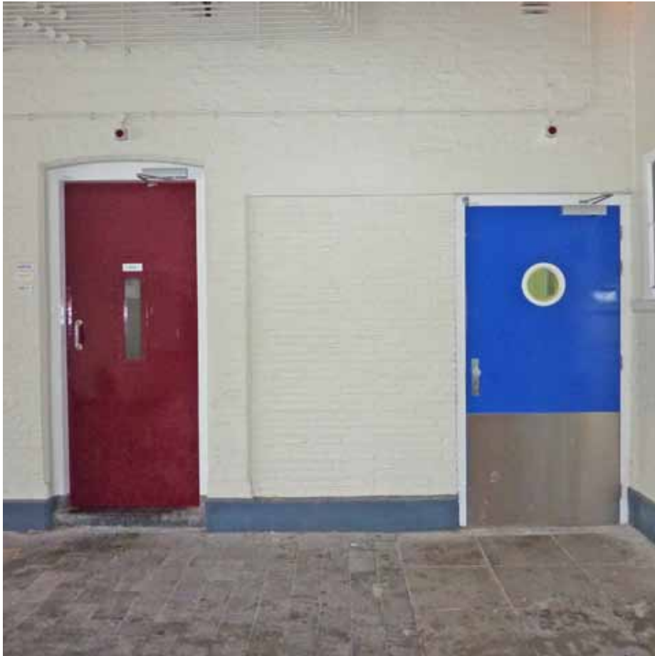
Afbeelding 22. Rechter gedeelte van de noordwand. De deur links bevindt zich in een oorspronkelijke doorgang, maar de deur zelf werd aangebracht bij de functiewijziging van de achterliggende ruimte rond 1950. Rechts bevinden zich twee dicht naast elkaar geplaatste segmentbogen met daaronder een betonlatei. Onder de rechter boog is recent een nieuwe deur (1988) geplaatst. Het linker deel is ingevuld met metselwerk in klezorverband (1988).
