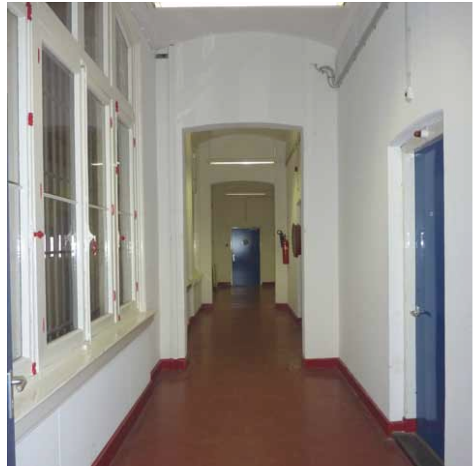
Afbeelding 69. Overzicht van het tweede deel van ruimte F1.20, gezien richting het zuiden. De nu open doorgangen in de dwarswanden bezaten oorspronkelijk de deuren tussen twee kantoorruimten. Reeds voor 1888 werd de gang naar bouwdeel D doorgetrokken en werden deze ruimten ontsloten via deze gang (zie Afbeelding 111 en Afbeelding 118). De samengestelde pui bezit een - ten opzichte van de vensters op de begane grond - rijkere detaillering.
