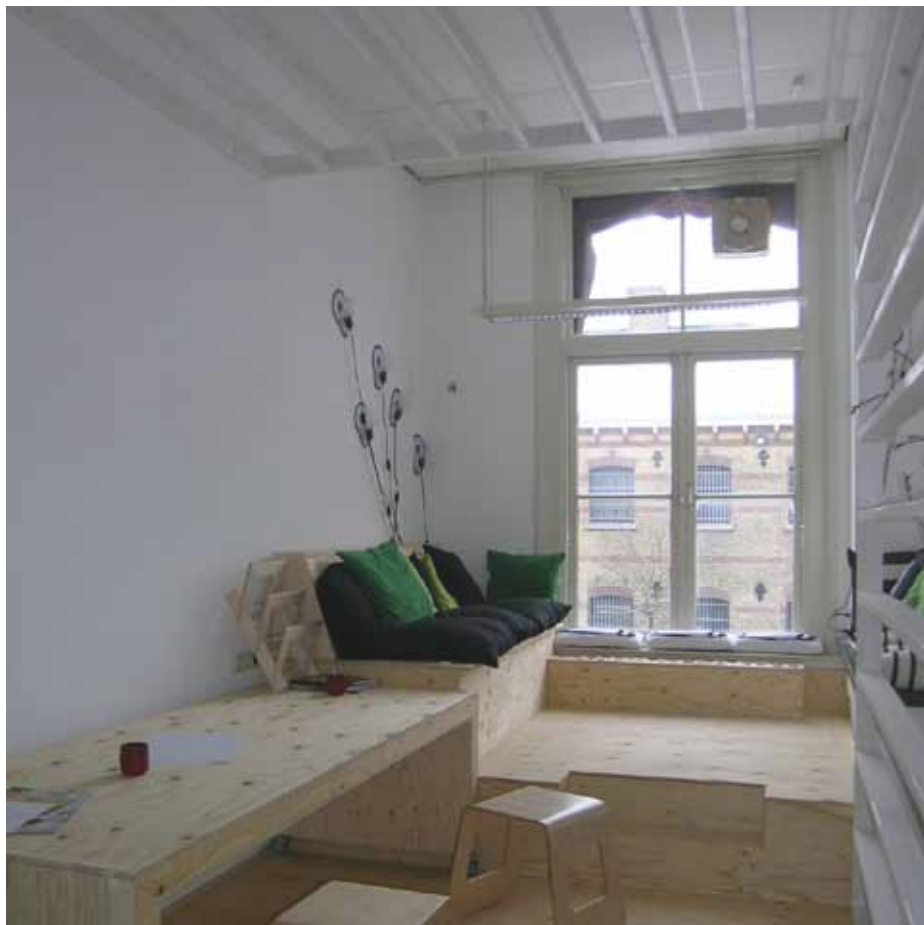
Afbeelding 61. Overzicht van ruimte F1.12. Het onderraam werd hier vervangen door 2-ruits stolpramen. De inrichting uit multiplex platen is door de huidige gebruikers aangebracht.
