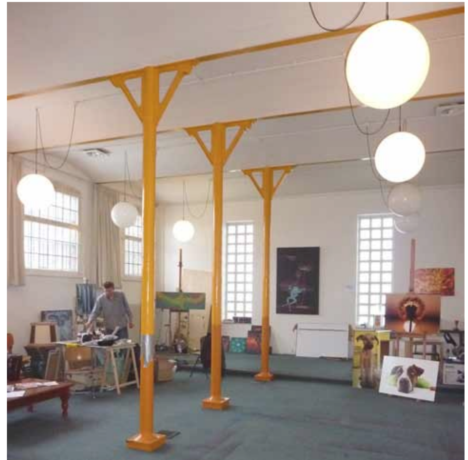
Afbeelding 90. Overzicht van ruimte 1.31 gezien richting het oosten. De vensters in de oostgevel zijn opgebouwd uit glazen bouwstenen (1988).
