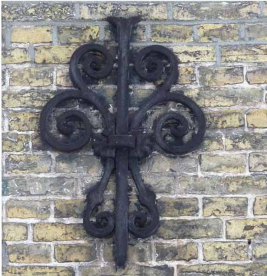
Afbeelding 18. Detail van één van de sierankers. De los aangegoten versieringen van de ankers zijn op verschillende plaatsen niet meer aanwezig.
