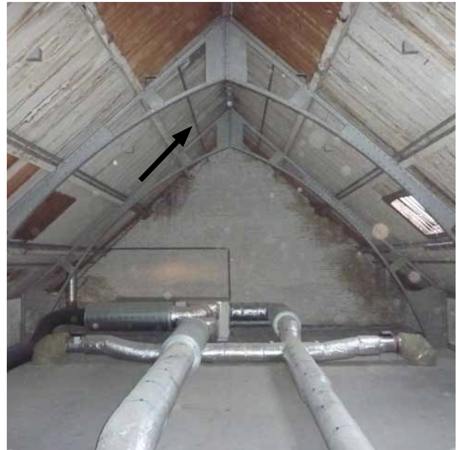
Afbeelding 98. Overzicht van ruimte F2.08 gezien richting het oosten. De plaats van de voormalige dakkapel is hier duidelijk te onderscheiden in de vorm van ongeschilderd dakbeschoot. Ter plaatse van de pijl bevindt zich één van de hoekstalen die aan de spanten zijn verbonden.
