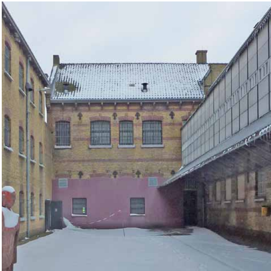
Afbeelding 8. Overzicht van de noordgevel van de oostelijke uitbouw.
