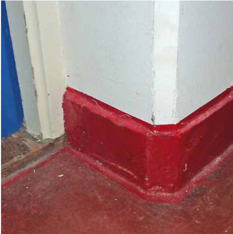
Afbeelding 72. Detail van de rechter onderhoek van de linker deur in de westwand in het zuidelijke deel van de gang. Dit kozijn (XXb) werd in een oudere doorgang (1875) geplaatst. De kozijnstijlen werden voorzien van een hol profiel en zonder neuten op de houten dorpel geplaatst.
