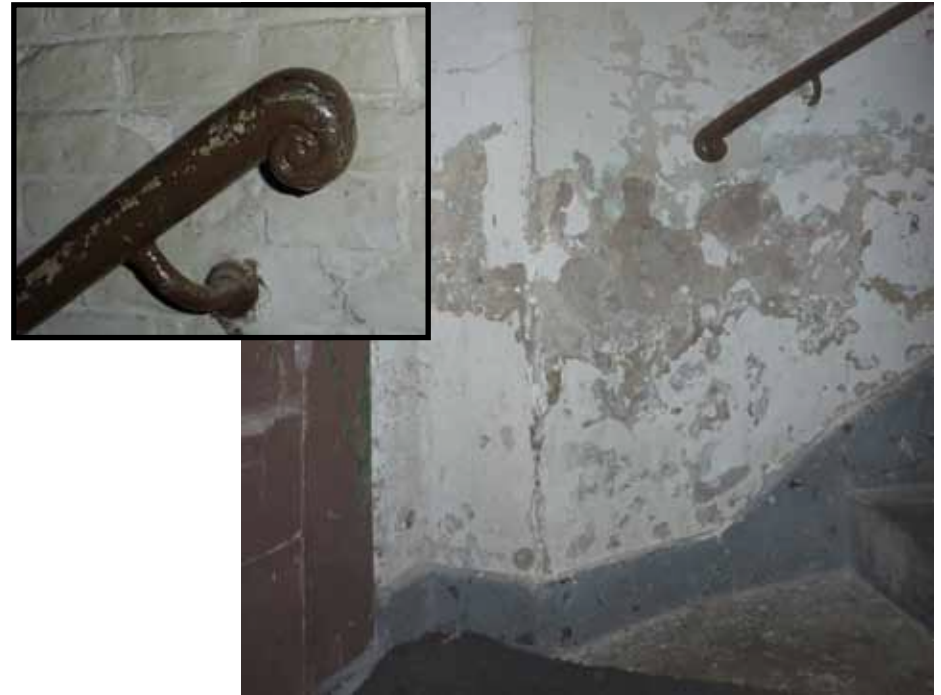
Afbeelding 26. Detail van de onderzijde van de trap met links de toegangsdeur naar de gang op de tweede binnenplaats. Het gehele trappenhuis is langs de wanden voorzien van een gecementeerde plint. Alleen het muurwerk rechts van de toegangsdeur tot de deur op de eerste verdieping is gepleisterd, waarin op 1,3 meter hoogte een dunne lambrisering te onderscheiden is. Mogelijk was het gehele trappenhuis voorzien van deze lambrisering, die later gedeeltelijk - Vanaf De eerste verdieping - werd verwijderd. De iets buiten het metselwerk uitstekende houten ingemetselde klosjes waaraan de leuning is bevestigd zouden hierop kunnen wijzen. De ijzeren leuning is uitgevoerd met gekrulde uiteinden (zie inzet).
