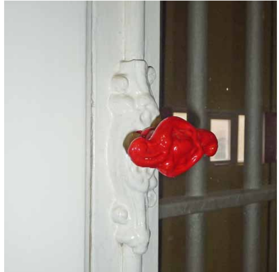
Afbeelding 71. Detail van één van de zorgvuldig vormgegeven espagnoletten van de samengestelde pui.
