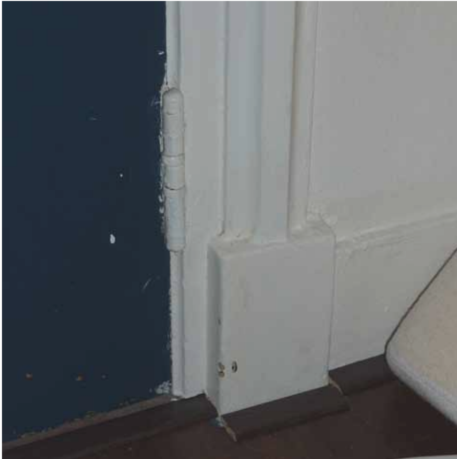
Afbeelding 88. Zicht op de rechter onderhoek van de linker deur naar de gang in ruimte F1.25. De architraaflijsten van deze toegangsdeur bezitten dezelfde profilering als de lijsten rond de verlengde vensters.
