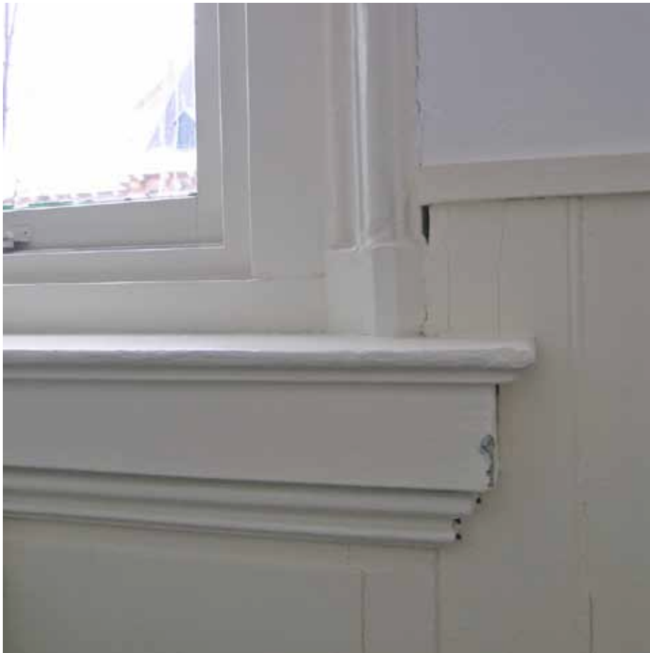
Afbeelding 107. Detail van de rechter onderhoek van één van de twee vensters in het zuidelijke deel van ruimte F1.15. Het onderraam van het oorspronkelijke schuifvenster werd vervangen door twee stolpramen. De architraven en vensterbank werden herplaatst, de lambrisering onder het venster paste men aan.
