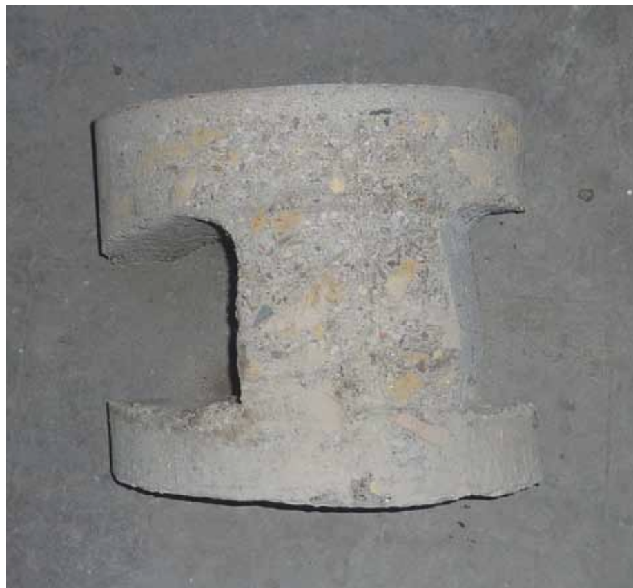
Afbeelding 100. Doorsnede van één van de betonnen troggewelven. De totale hoogte is 28,5 cm, waarbij de onderzijde van de holle 'wulfsels' 5,5 cm dik is en de bovenzijde 9 cm.
