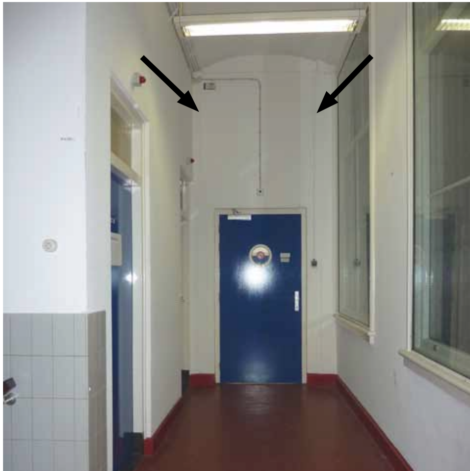
Afbeelding 68. Overzicht van het eerste deel van ruimte F1.20, gezien richting het noorden. Links zijn de tegels van het trappenhuis F0.13 zichtbaar. De noordwand bezit twee lijnen (aangegeven door middel van de twee pijlen) die een voormalige doorgang met vellingkanten en kapelletjes aangeven. De invulling en de deur werden in 1988 aangebracht.
