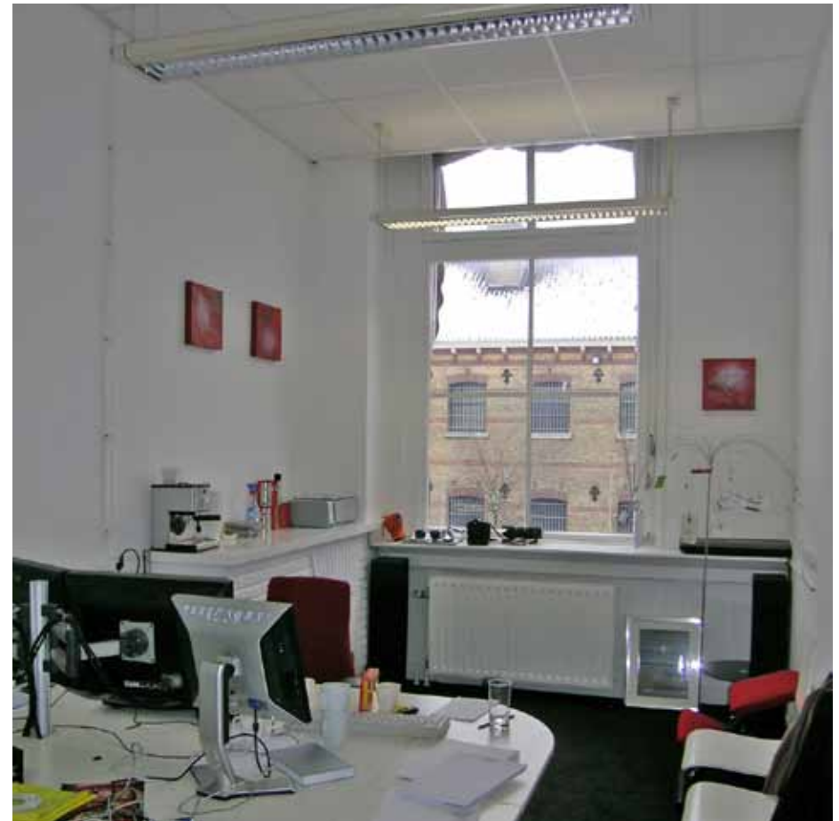
Afbeelding 60. Overzicht van ruimte F1.11 gezien richting het westen. Ook in deze ruimte werd het schuifraam vervangen, waarbij de beleglatten werden teruggeplaatst. In de zuidwesthoek bevindt zich een gemetselde schouw (1957).
