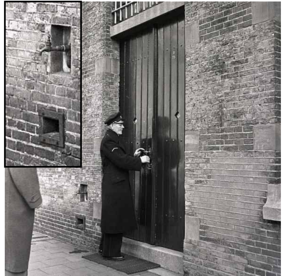
Afbeelding 17. De deur van de voorgaande afbeelding in januari 1959. Eén van de twee inboetingen was een buitenkraan. De grotere herstellingen van de voorgaande afbeelding waren hier reeds gedeeltelijk aanwezig. Foto: Collectie Beeldbank Leeuwarden, documentnr.: BDO0593
