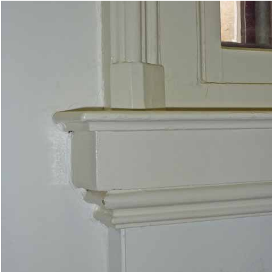
Afbeelding 70. Detail van de rechter onderhoek van de samengestelde pui. In tegenstelling tot de sobere detaillering van de vensters op de begane grond, is dit venster voorzien van architraaflijsten en een vensterbank met rijkere profilering. De borstwering was voorzien van een houten lambrisering (zie pagina 13), die nu is voorzien van een triplex omtimmering.
