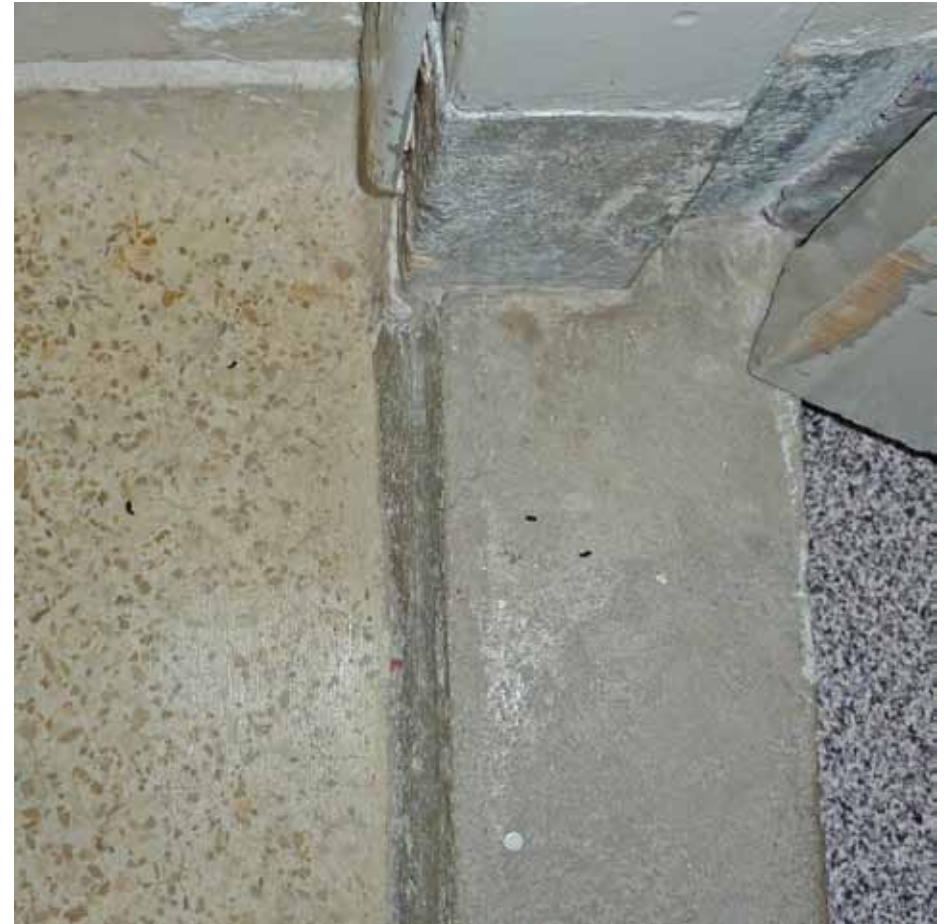
Afbeelding 38. Zicht op de dorpel tussen de bijkeuken (rechts) en berging. De vloer van de berging is voorzien van gele terrazzo, de vloer van de bijkeuken bestaat uit cement, net als de neuten en de dorpel van de doorgang.
