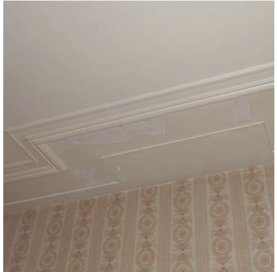
Afbeelding 29. Zicht op het plafond van de voorkamer ter plaatse van het voormalige rookkanaal, dat voor 1976 werd verwijderd.
