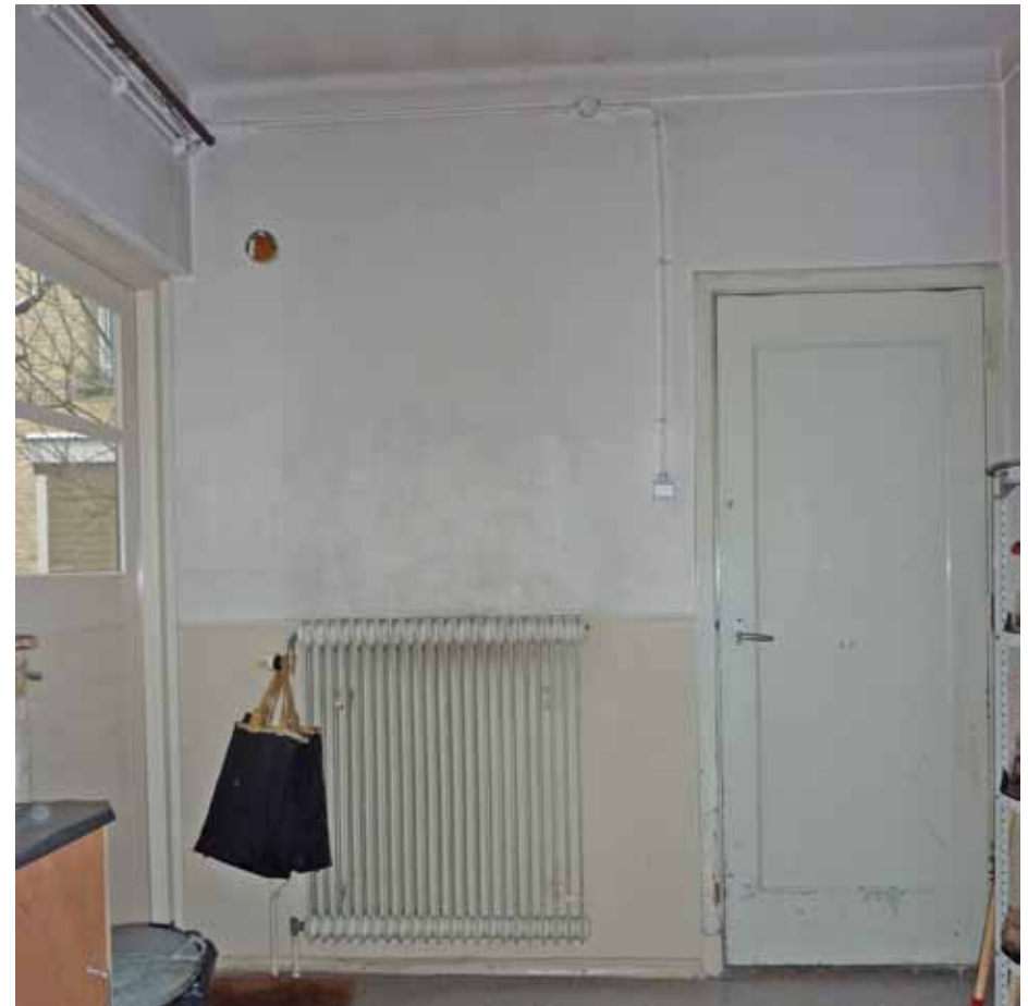
Afbeelding 36. Overzicht van de bijkeuken richting het zuiden. Vermoedelijk rond 1948 werd de ommuurde binnenplaats opgehoogd en overkapt. De daarvoor gerealiseerde ruimte werd gesplitst (XXb) door een binnenwand met daarin een paneeldeur. Op ongeveer 1,3 meter hoogte bevindt zich een verdiepte strook in het pleisterwerk, zoals ook in andere bouwdelen van het complex voorkomt.
