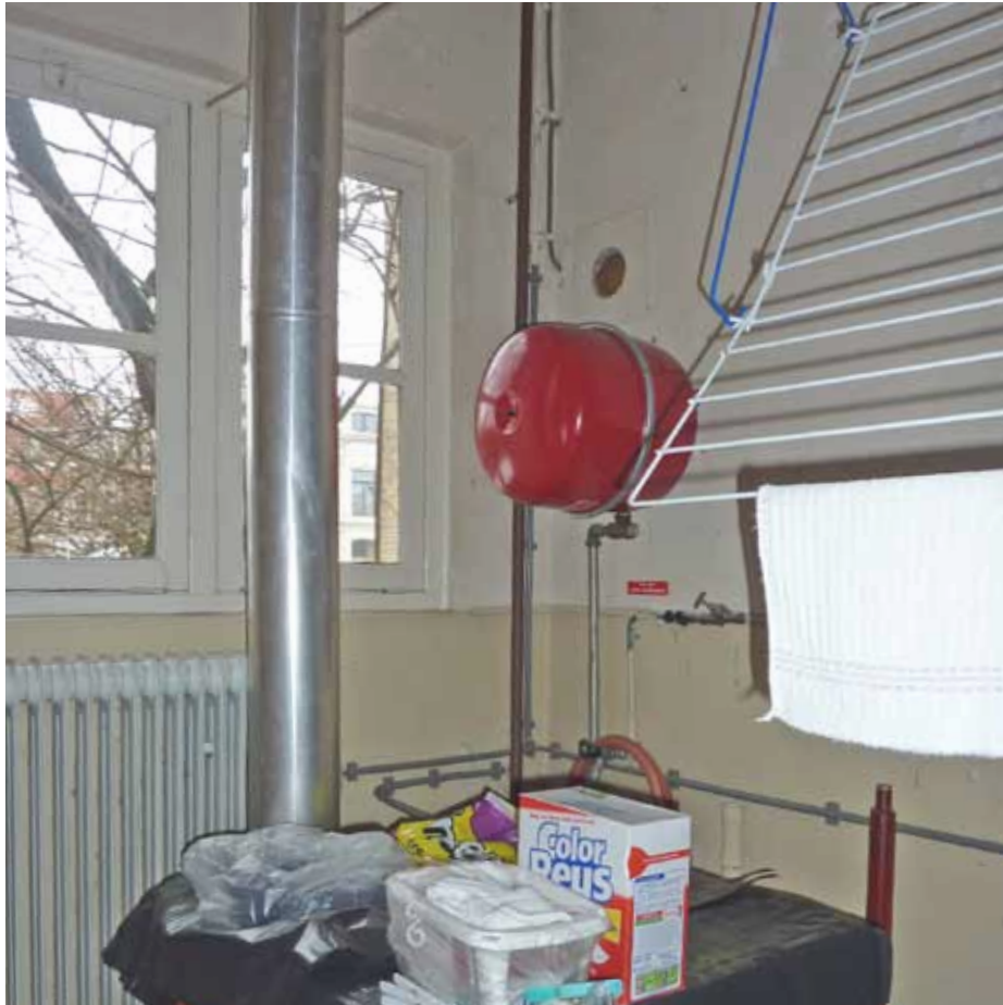
Afbeelding 37. Zicht op de zuidoostelijke hoek van de berging. In deze ruimte is de cv-installatie opgesteld. Het tweelicht met 2-ruits ramen werd aangebracht tijdens het verhogen en overkappen van het voormalige plaatsje (XXc). Het melkmeisje in de bijkeuken werd echter recent (rond 1997) vervangen.
