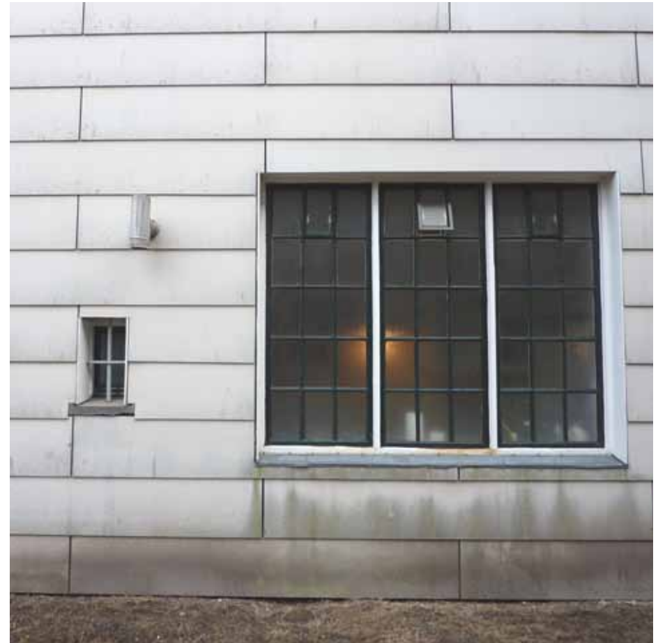
Afbeelding 12. Zicht op het drielicht aan de rechter zijde van de westgevel. De gepotdekselde eterniet beplating (XXIa) werd recent aangebracht en sluit door middel van dagstukken aan op de kozijnstijlen. De kleine vensters uit de bouw-tijd zijn voorzien van tralies en een hardstenen onderdorpel. Het secundaire venster (rond 1957) van de keuken is vormgegeven als drielicht met daarin 15-ruits stalen ramen. De onderdorpel is voorzien van een loodslabbe (XXIa).
