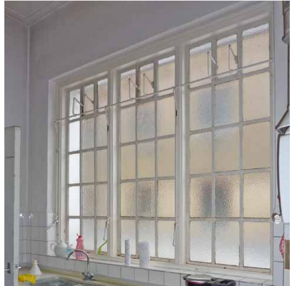
Afbeelding 35. Zicht op de binnenzijde van het venster in de westgevel. Vóór de plaatsing van dit venster werd deze ruimte enkel verlicht door de ruiten in de achterdeur in de zuidwand, die toegang gaf tot de ommuurde binnenplaats. Bij elk van de 15-ruits stalen ramen kan het bovenste ruitje in het midden worden uitgezet.
