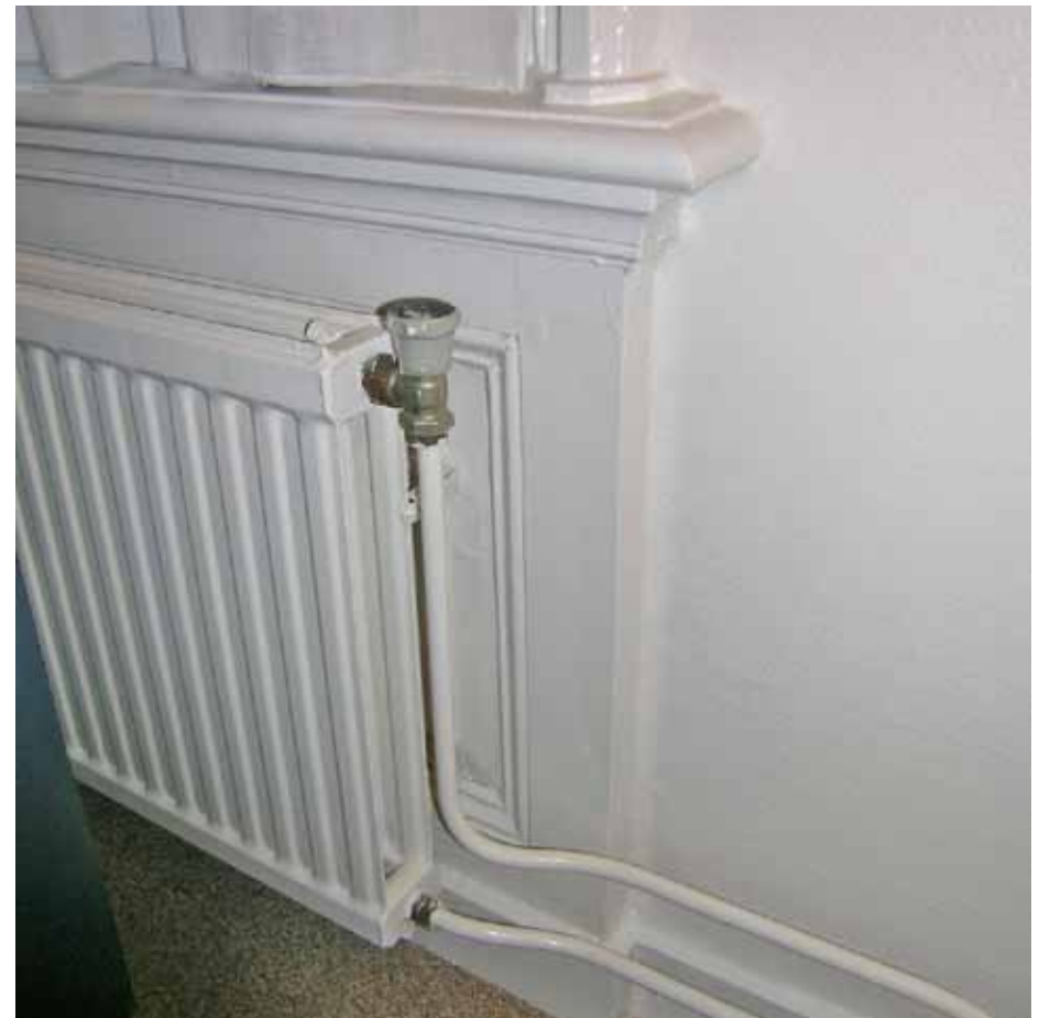
Afbeelding 61. Zicht op de onderzijde van één van de vensters in bouwdeel G. De vensters zijn voorzien van geprofileerde architraaflijsten die door middel van houten neuten aansluiten op de vensterbanken. Ter hoogte van de borstwering zijn lambriseringen met bossingpanelen aangebracht. Op verschillende plaatsen zijn de bossingpanelen door vlakke platen aan het zicht onttrokken of is de lambrisering geheel verwijderd.
