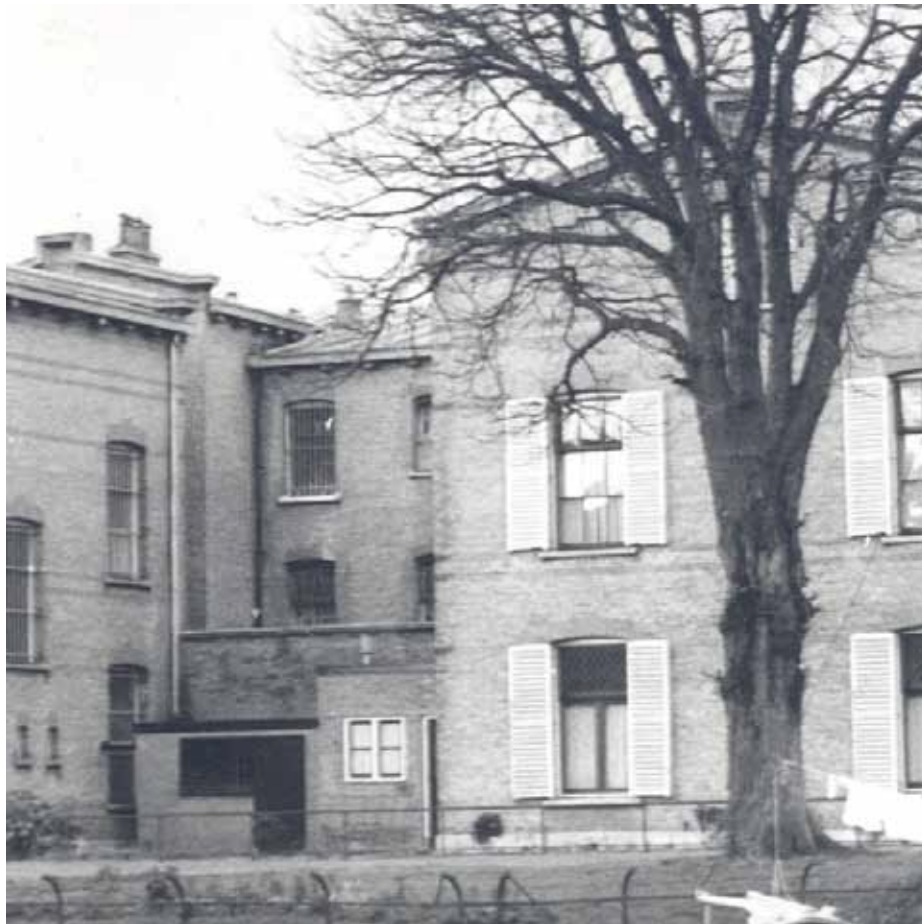
Afbeelding 13. Zicht op de bijkeuken en het schuurtje ten zuiden van de directiewoning in december 1954. Het ommuurde binnenplaatsje werd vermoedelijk rond 1948 verhoogd en overkapt. Vervolgens werd in het begin van de jaren 1950 een schuurtje ten zuiden van de bijkeuken gerealiseerd, dat in 1965 werd verbouwd tot garage. Foto: Collectie Beeldbank Leeuwarden, documentnr.: FDKEIZGRA006
