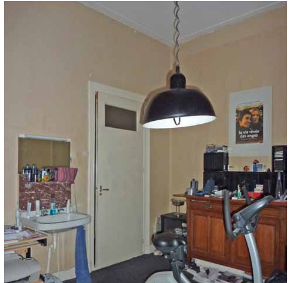
Afbeelding 45. Overzicht van de grote slaapkamer aan de achter(zuid-)zijde gezien richting het noordwesten (gang). De wastafel is bevestigd tegen een marmereen achterplaat en bezit een loden afvoerpijp.
