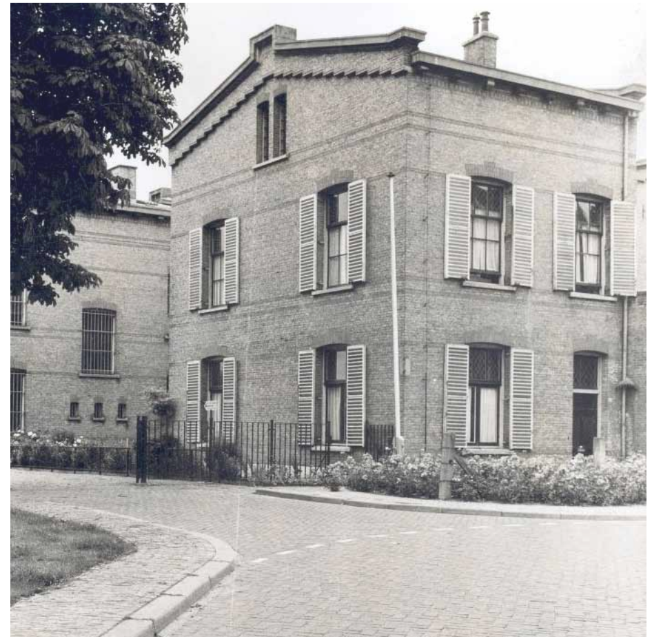
Afbeelding 14. Overzicht van de noord- en oostgevel van bouwdeel H in juli 1961. De onderramen van de schuifvensters werden in het begin van de jaren '50 van de voorgaande eeuw vervangen door stolpramen. De louvreliuken werden vermoedelijk reeds tijdens de bouw aangebracht. Foto: Collectie Beeldbank Leeuwarden, documentnr.: FDKEIZGRA022
