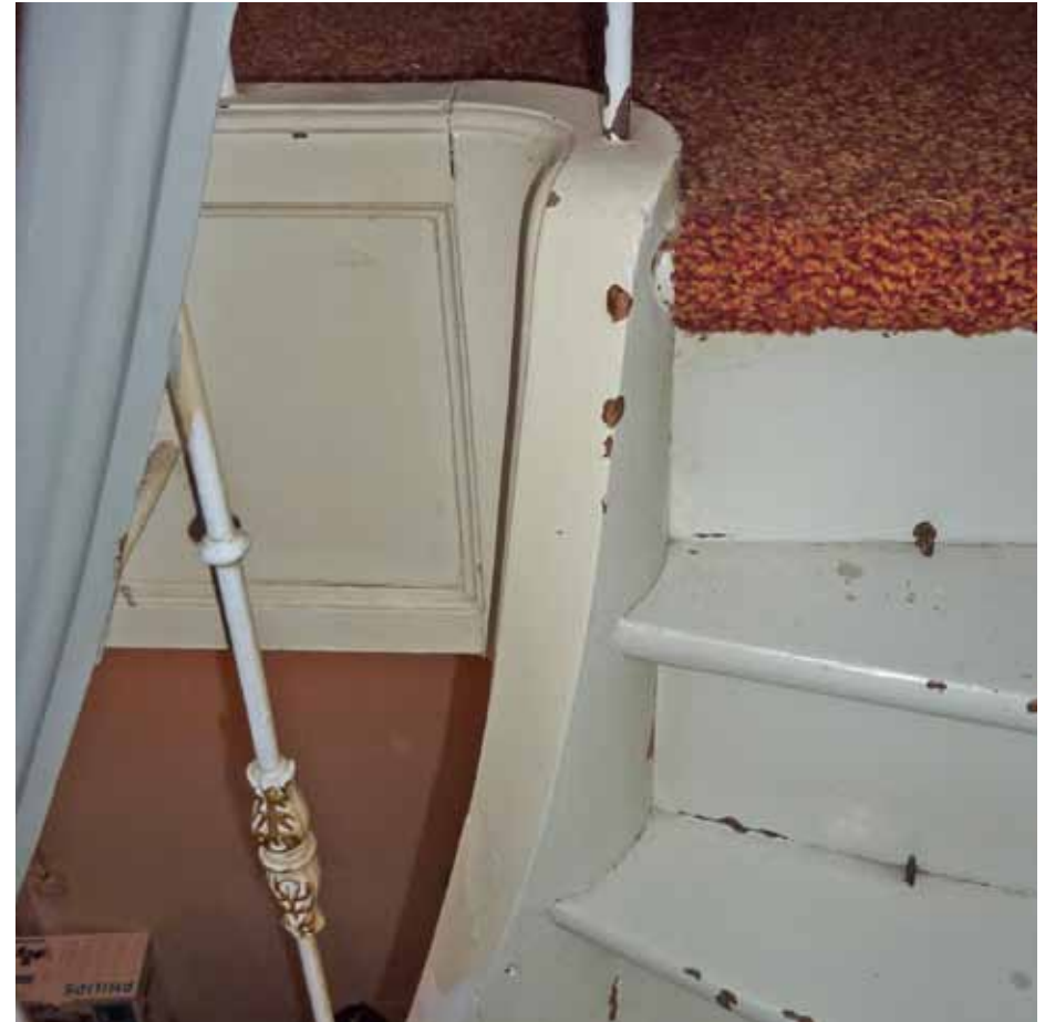
Afbeelding 41. Zicht op de bovenzijde van de trap en de aftimmering van de dikte van de vloer van de tweede verdieping. De raveelplank bestaat uit vlakke panelen in geprofileerde lijsten.
