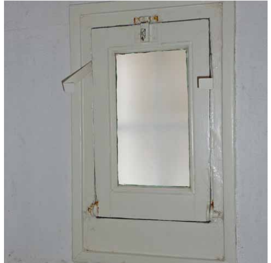
Afbeelding 23. Het venster in de westwand bezit een naar binnen vallend raam met uitzetijzers. De oorspronkelijke lijsten werden bij de renovatie van het toilet (XXc) vervangen door meer eenvoudige aftimmerlatten.
