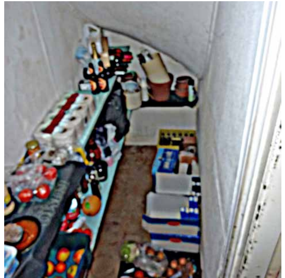
Afbeelding 24. Overzicht van de kelder.
