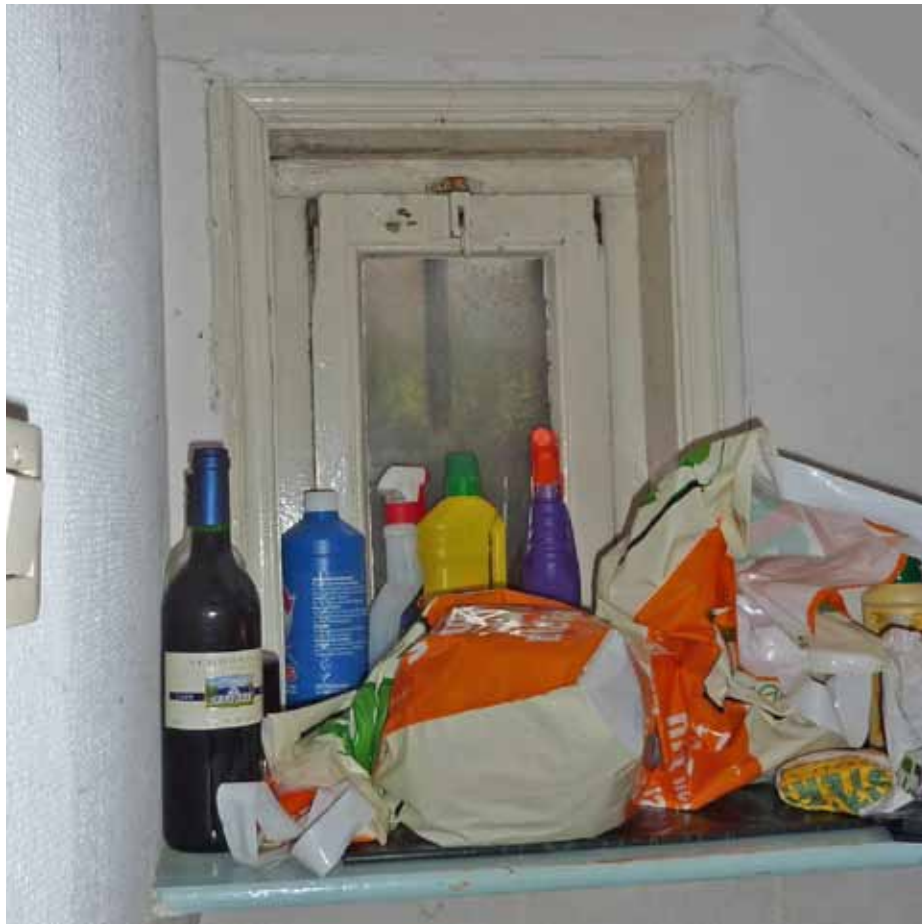
Afbeelding 25. Het venster in de westwand bezit een naar binnen vallend raam. Dit venster is nog wel voorzien van de uit de bouwtijd afkomstige geprofileerde aftimmerlijsten.
