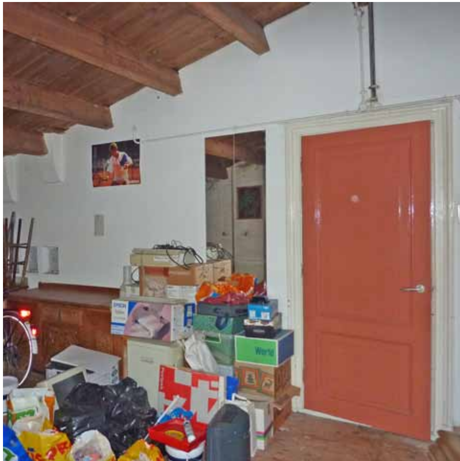
Afbeelding 52. Overzicht van de zolder gezien richting het westen. De doorgang naar de overloop is voorzien van een paneeldeur uit de bouwtijd. Op de begane grond en eerste verdieping werden de binnendeuren in de jaren '50 vervangen, maar op deze verdieping werden ze aan de buiten(gang-)zijde voorzien van triplex beplating. Geheel links zijn de gietijzeren schoorsteenluikjes (1891) zichtbaar.
