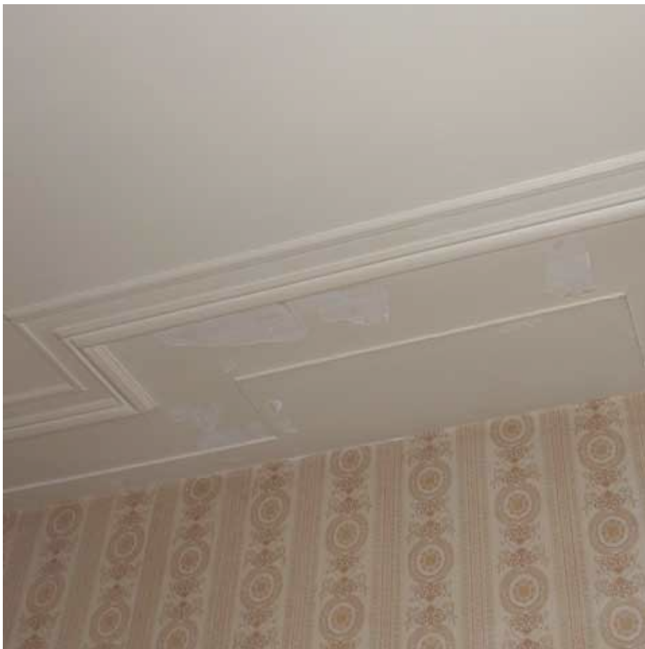
Afbeelding 62. Zicht op het plafond van de voorkamer ter plaatse van het voormalige rookkanaal, dat voor 1976 werd verwijderd.
