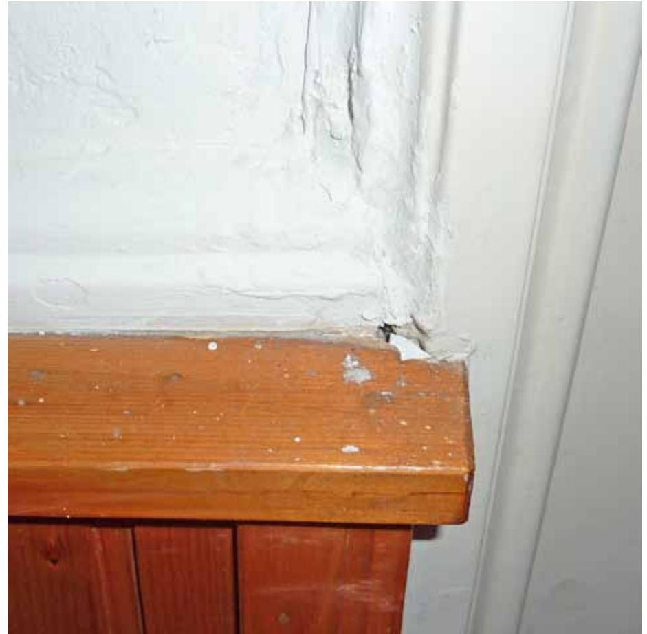
Afbeelding 58. Detail van de bovenzijde van de lambrisering in de vestibule. Achter de houten afdeklijst uit de jaren '50 bevindt zich nog een oudere lijst. Mogelijk is dit een lambriseringslijst, zoals deze ook op de wanden in de gang van bouwdeel G (het administratiegebouw) werd toegepast.
