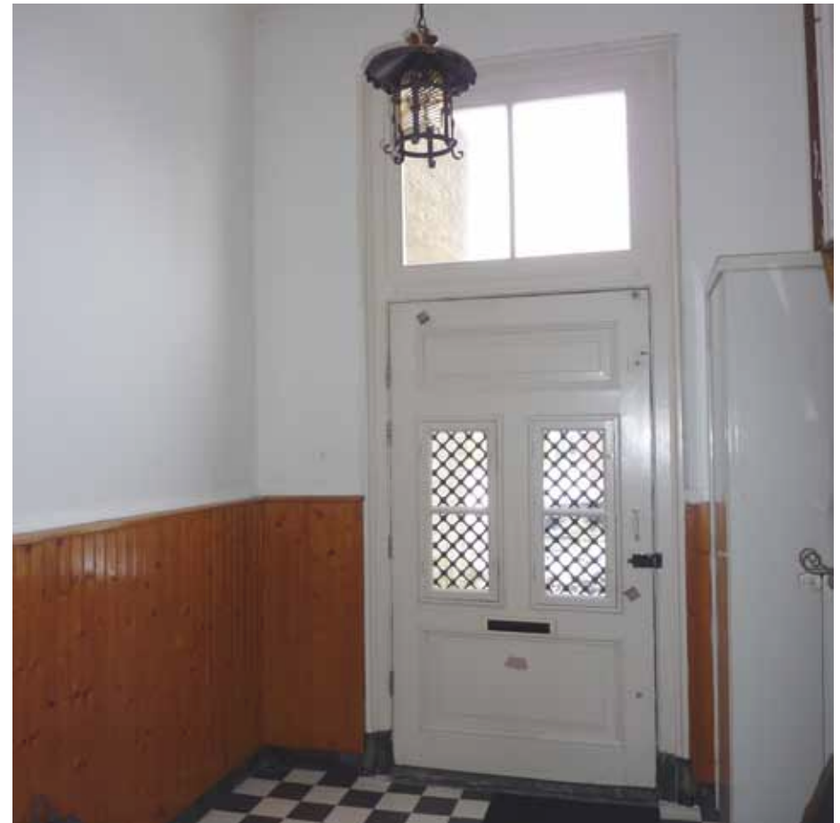
Afbeelding 15. Overzicht van de vestibule richting het noorden. De voordeur met bovenlicht stamt nog geheel uit de bouwtijd. De twee 2-ruits raampjes in het midden zijn aan de buitenzijde voorzien van een gietijzeren paneel. Rechts bevindt zich de in de jaren '50 aangebrachte meterkast.
