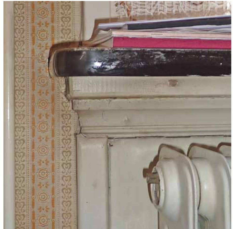
Afbeelding 32. Detail van de linker onderhoek van één van de vensters in de voorkamer. Bij het vervangen van de onderramen door stolpramen werden de vensterbanken voorzien van formica bovenzijden en werd de lambrisering afgetimmerd met een vlakke plaat, afgewerkt met latjes. De profilering van de onderzijde van de oorspronkelijke vensterbank is echter nog wel zichtbaar.
