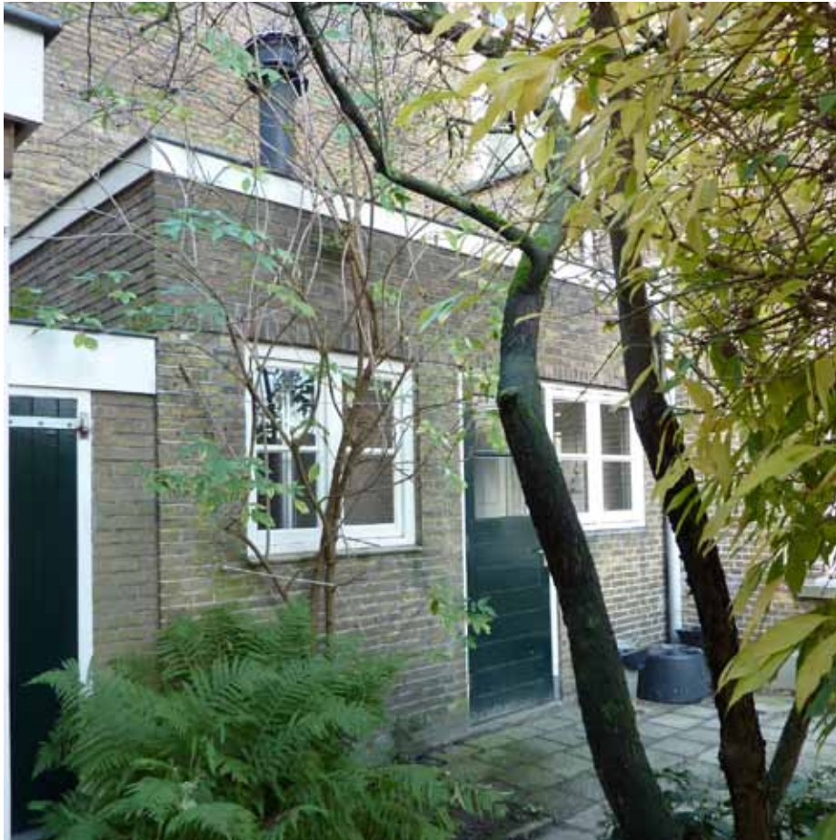
Afbeelding 7. Zicht op het noordelijke deel van de aanbouw aan de zuidzijde. De onderbouw stamt uit de bouwtijd en vormde een gesloten binnenplaatsje, bereikbaar via de keuken. In het tweede kwart van de 20 ste eeuw werd het plaatsje opgehoogd in halfsteens metselwerk en voorzien van een plat dak. Het melkmeisje werd recent (XXIa) van een nieuwe invulling voorzien, het venster links bezit nog de ramen uit de fase van het realiseren van de bijkeuken (XXb).
