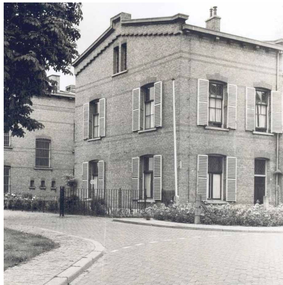
Afbeelding 57. Overzicht van de noord- en oostgevel van bouwdeel H. De onderramen van de schuifvensters werden in het begin van de jaren '50 van de voorgaande eeuw vervangen door stolpramen. De louvreliken zijn niet meer aanwezig. Foto: Collectie Beeldbank Leeuwarden, documentnr.: FDKEIZ-GRA022
