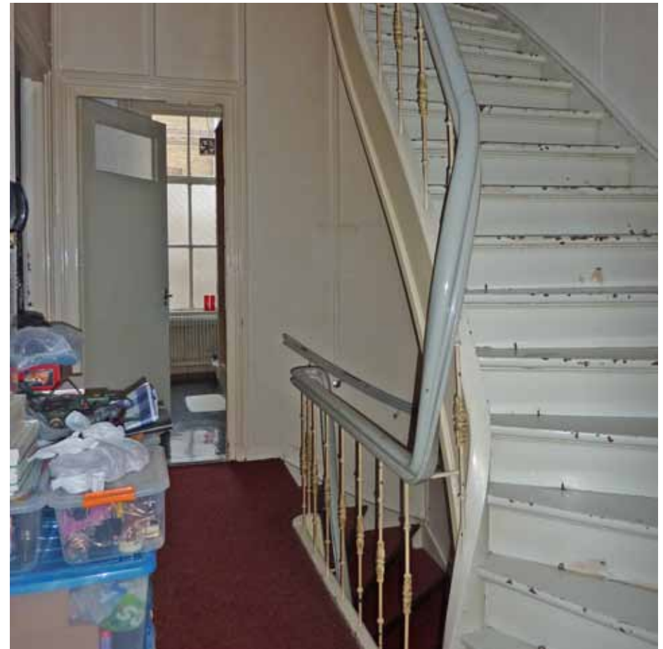
Afbeelding 39. Overzicht van de overloop richting het zuiden (badkamer). De geprofileerde handlijst wordt ondersteund door gietijzeren balusters.
