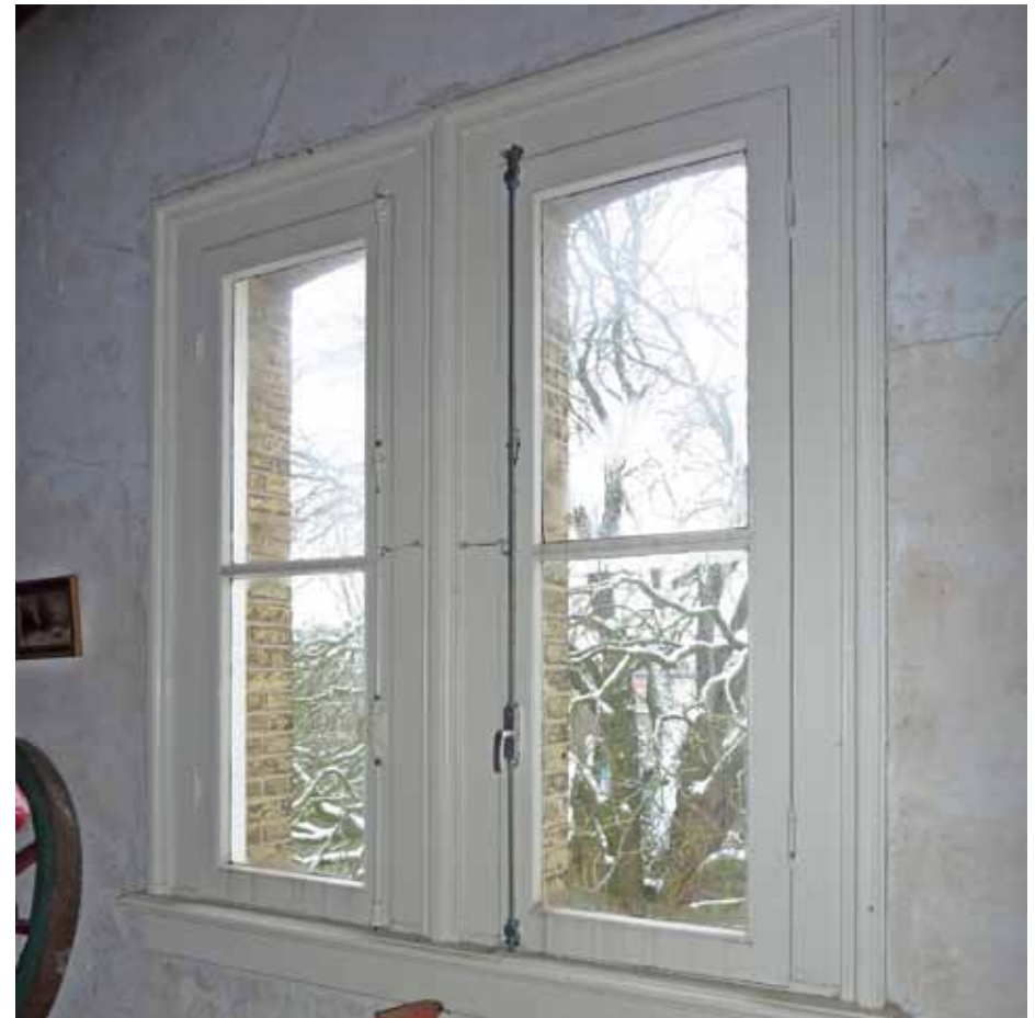
Afbeelding 53. Zicht op het venster in de oostgevel. Het tweelicht is voorzien van 2-ruits ramen en geprofileerde lijsten die hier zonder neuten aansluiten op de eenvoudig geprofileerde vensterbank (alle 1891). Het linker raam bezit nog het verzorgd gedetailleerde spanjolet uit de bouwtijd en scharnieren met oudhollandsche knop.
