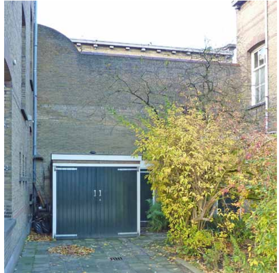
Afbeelding 8. Zicht op de garage ten zuiden van het bouwdeel. In het begin van de jaren '50 werd ten zuiden van de bijkeuken een schuurtje gerealiseerd. In 1965 werd het schuurtje verbouwd tot garage, waarbij het linker gedeelte richting het oosten werd uitgebreid.
