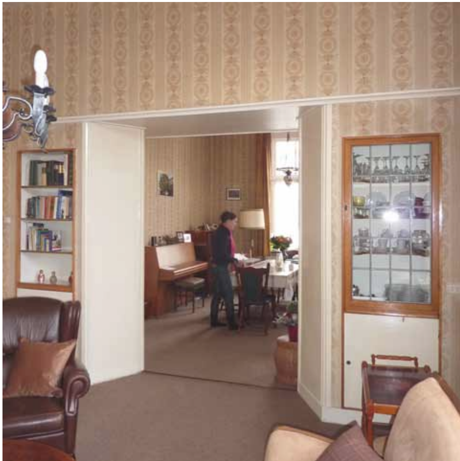
Afbeelding 31. Zicht op de suitedeuren richting de voorkamer. In het midden van de 20 ste eeuw werd de suiteseparatie aangepast. De kasten aan weerszijden werden voorzien van nieuwe deuren en de suitedeuren zelf werden verwijderd. Mogelijk is dat de deuren in de spouw tussen de kasten werden geschoven en vervolgens met een lat werden afgedekt. De doorlopende lijst aan de bovenzijde werd eveneens in deze fase aangebracht.
