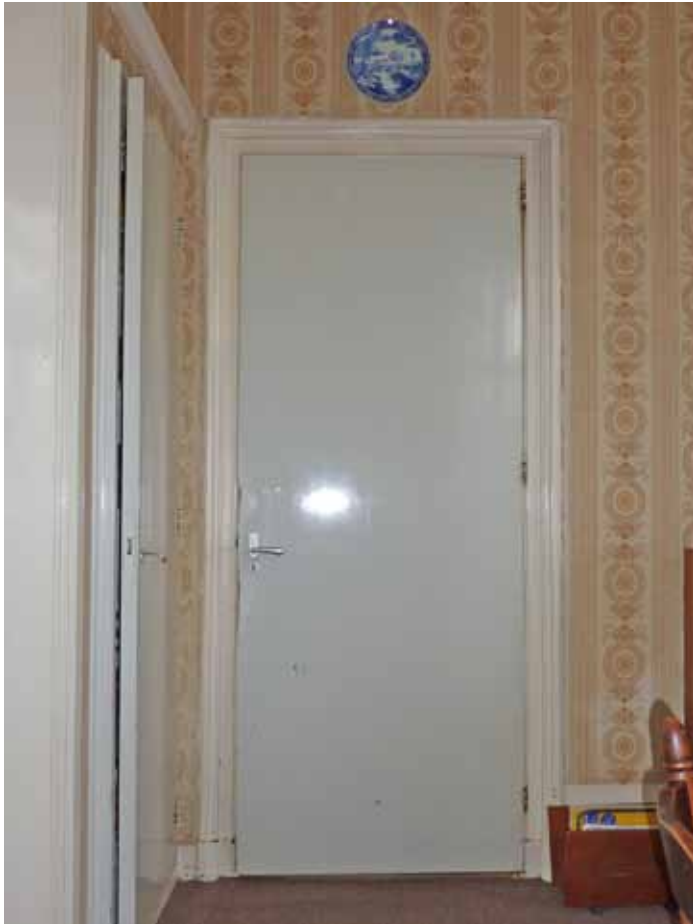
Afbeelding 28. Zicht op de deur naar de gang. De deur werd in het midden van de 20 ste eeuw geplaatst in een oudere (1891) doorgang. De lijsten werden hierbij gehandhaafd, de hardstenen dorpel werd vervangen door een houten dorpel.
