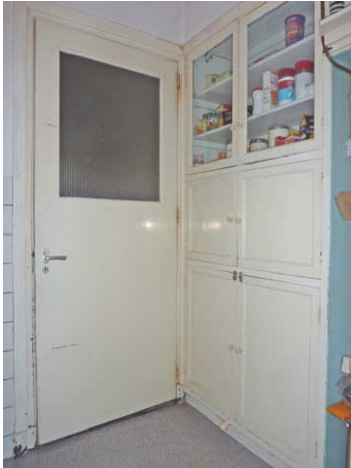
Afbeelding 34. Zicht op de noordoostelijke hoek van de keuken met links de doorgang naar de gang en rechts de vaste kast. De deur werd in de jaren '50 geplaatst in de oorspronkelijke doorgang, waarbij tevens de geprofileerde af-timmerlijsten werden vervangen door eenvoudigere latten. De ombouw van de kast stamt mogelijk nog uit de bouwtijd. De deurtjes werden tijdens de renovatie van de keuken in het midden van de 20 ste eeuw aangebracht.
