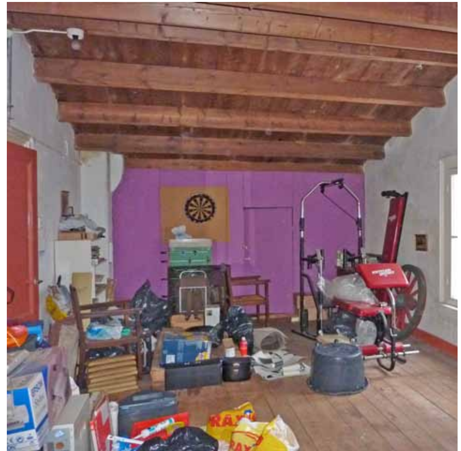
Afbeelding 51. Overzicht van de zolder gezien richting het noorden. De paars gesausde scheidingswand werd rond 1975 geplaatst.
