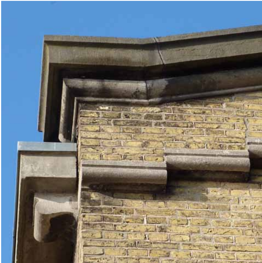
Afbeelding 11. Zicht op de linker bovenhoek van de oostelijke kopgevel. Van de uitgemetselde kroonlijst op hardstenen geprofileerde consoles is het fries getrapt vormgegeven. De hardstenen bakgoot is eveneens geplaatst op hardstenen consoles en is later voorzien van een zinken bekleding.
