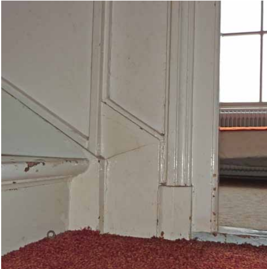
Afbeelding 40. Zicht op de onderste trede van de trap naar de tweede verdieping. De treden van de trap zijn aan de onderzijde voorzien van een profilering en de bovenzijde van de trapboom was afgewerkt met een plint, nu grotendeels aan het zicht onttrokken door secundaire voorzetwanden (XXc).
