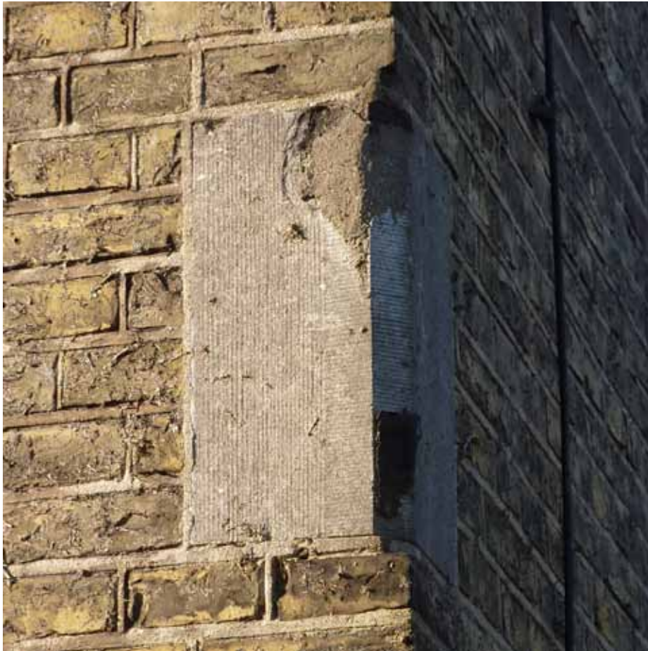
Afbeelding 9. Detail van het hardstenen blok op de noordoostelijke hoek ter hoogte van de voormalige wisseldorpels van de vensters van de begane grond. Vermoedelijk was aan dit blok een lantaarn bevestigd.
