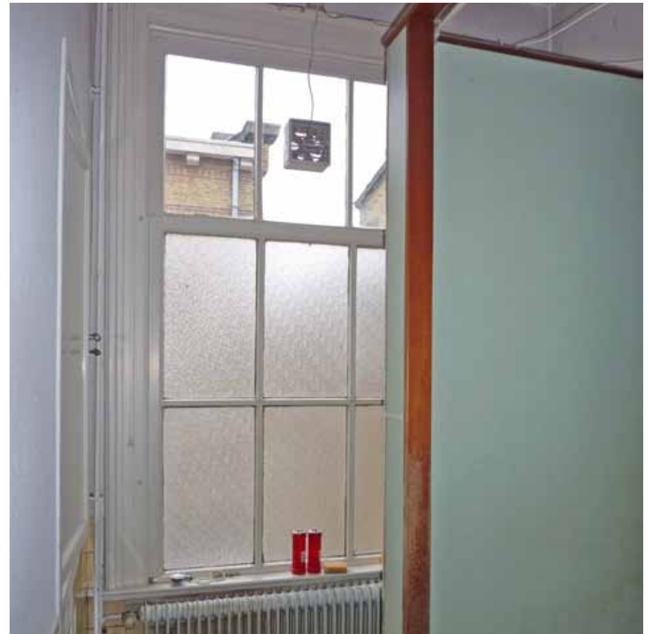
Afbeelding 47. Zicht in de badkamer gezien richting het zuiden. Het onderraam werd bij het bestemmen van deze ruimte tot badkamer (XXc) voorzien van matglazen ruiten. De douchewanden bestaan uit een soort trespa, afgewerkt met houten latten (XXc).
