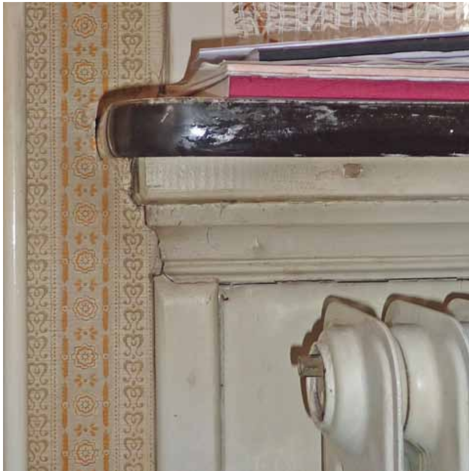
Afbeelding 60. Detail van de linker onderhoek van één van de vensters in de voorkamer. Bij het vervangen van de onderramen door stolpramen werden de vensterbanken voorzien van formica bovenzijden en werd de lambrisering afgetimmerd met een vlakke plaat, afgewerkt met plintjes.
