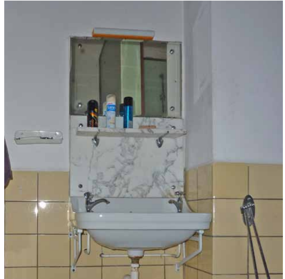
Afbeelding 49. Zicht op de wastafel (XXb) links van het rookkanaal op de oostwand. De wastafel (XXb) is bevestigd tegen een marmeren achterplaat en bezit een loden afvoerpijp. Waarschijnlijk werd deze wastafel herplaatst na het wijzigen van de slaapkamer tot badkamer in de jaren 1950.
