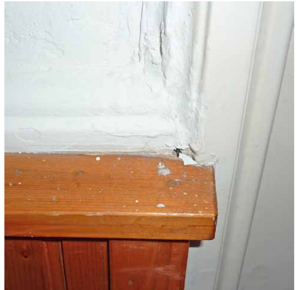
Afbeelding 17. Detail van de bovenzijde van de lambrisering in de vestibule. Achter de houten afdeklijst uit de jaren '50 bevindt zich nog een oudere lijst. Mogelijk is dit een lambriseringslijst uit de bouwtijd, zoals deze ook op de wanden in de gang van bouwdeel G (het administratiegebouw) werd toegepast.
