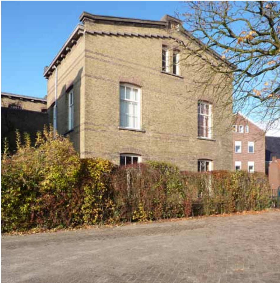
Afbeelding 5. Overzicht van de oostgevel. De twee naast elkaar geplaatste vensters ter hoogte van de tweede verdieping zijn geplaatst op één hardstenen onderdorpel.
