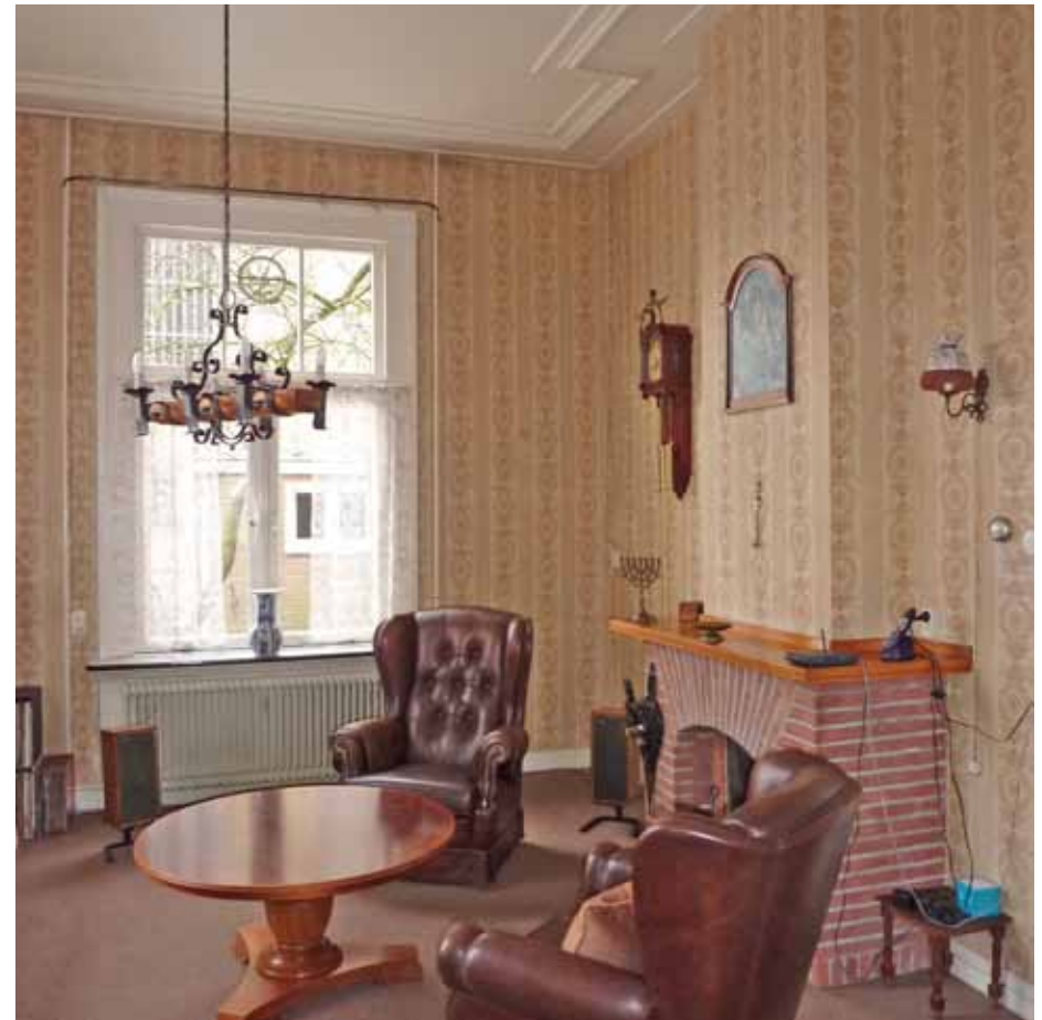
Afbeelding 30. Overzicht van de achterkamer gezien richting het zuiden. De interieurafwerkingen dateren uit het midden van de 20 ste eeuw. In deze periode werden de schuivende onderramen vervangen door stolpramen, werd de schouw gewijzigd, werden de radiatoren aangebracht en de wanden voorzien van een nieuwe afwerking. De schouw (XXc) kent dezelfde detaillering als de schouwen op de verdieping van bouwdeel E. Het metselwerk bezit terugliggende lintvoegen, zeer smalle stootvoegen en wordt afgedekt door een houten blad.
