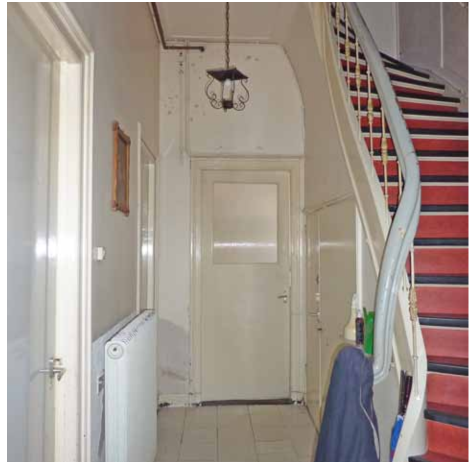
Afbeelding 18. Overzicht van de gang richting het zuiden (de keuken). De deuren werden in de jaren '50 van de voorgaande eeuw in oudere doorgangen (1891) geplaatst. De lagere deuren onder de trap geven toegang tot het toilet en de kelder.
