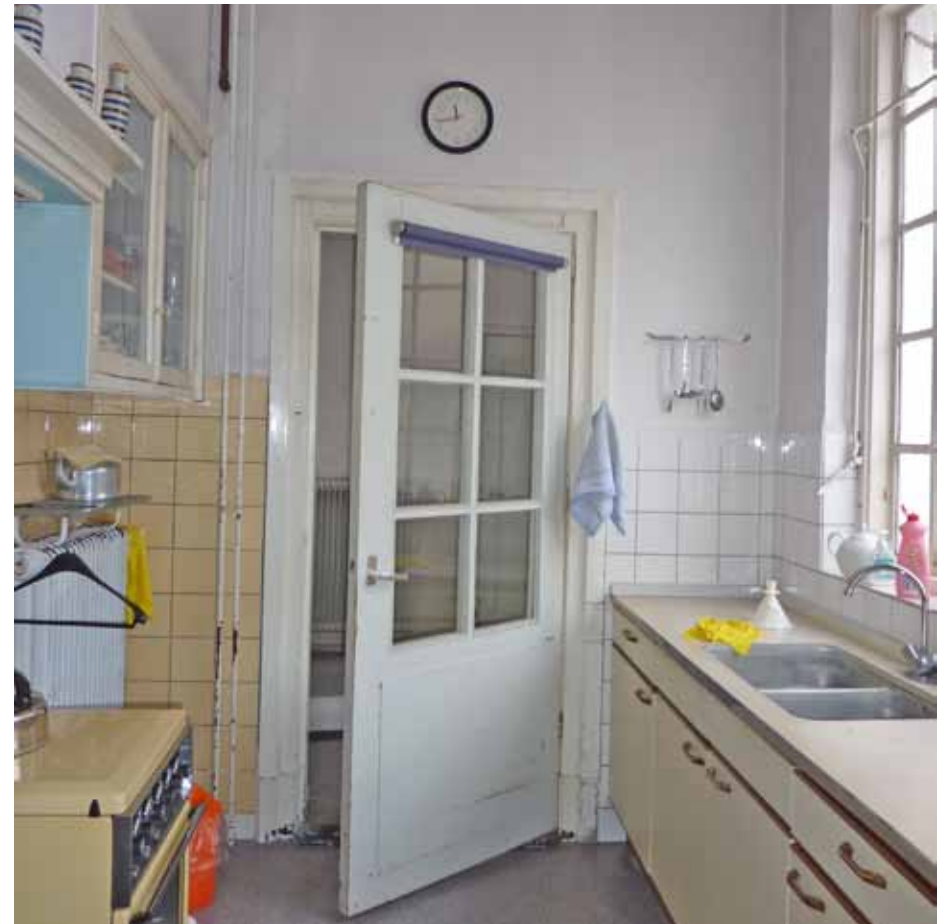
Afbeelding 33. Overzicht van de keuken richting het zuiden. De deur naar de bijkeuken dateert nog uit de bouwtijd en gaf toegang tot een kleine ommuurde binnenplaats. Het onderpaneel is voorzien van een triplex plaat (XXc). De wanden zijn aan de onderzijde afgewerkt met tegellambriseringen uit twee verschillende tegels. De gele tegels links werden in het midden van de 20 ste eeuw aangebracht, de tegels rechts vermoedelijk in de jaren '80 bij het plaatsen van het nieuwe aanrecht.
