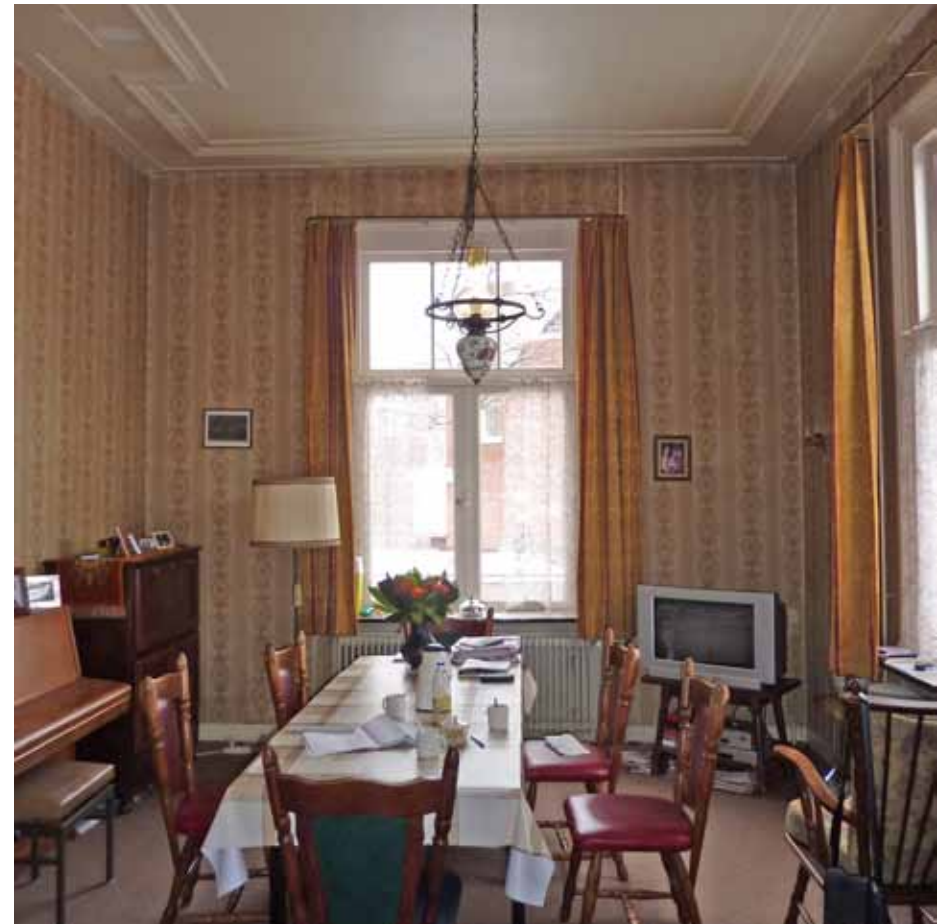
Afbeelding 27. Overzicht van de voorkamer richting het noorden (voorgevel). De 6-ruits schuivende onderramen werden in het tweede kwart van de 20 ste eeuw vervangen door stolpramen. De schouw en het rookkanaal werden mogelijk of kort daarna verwijderd.
