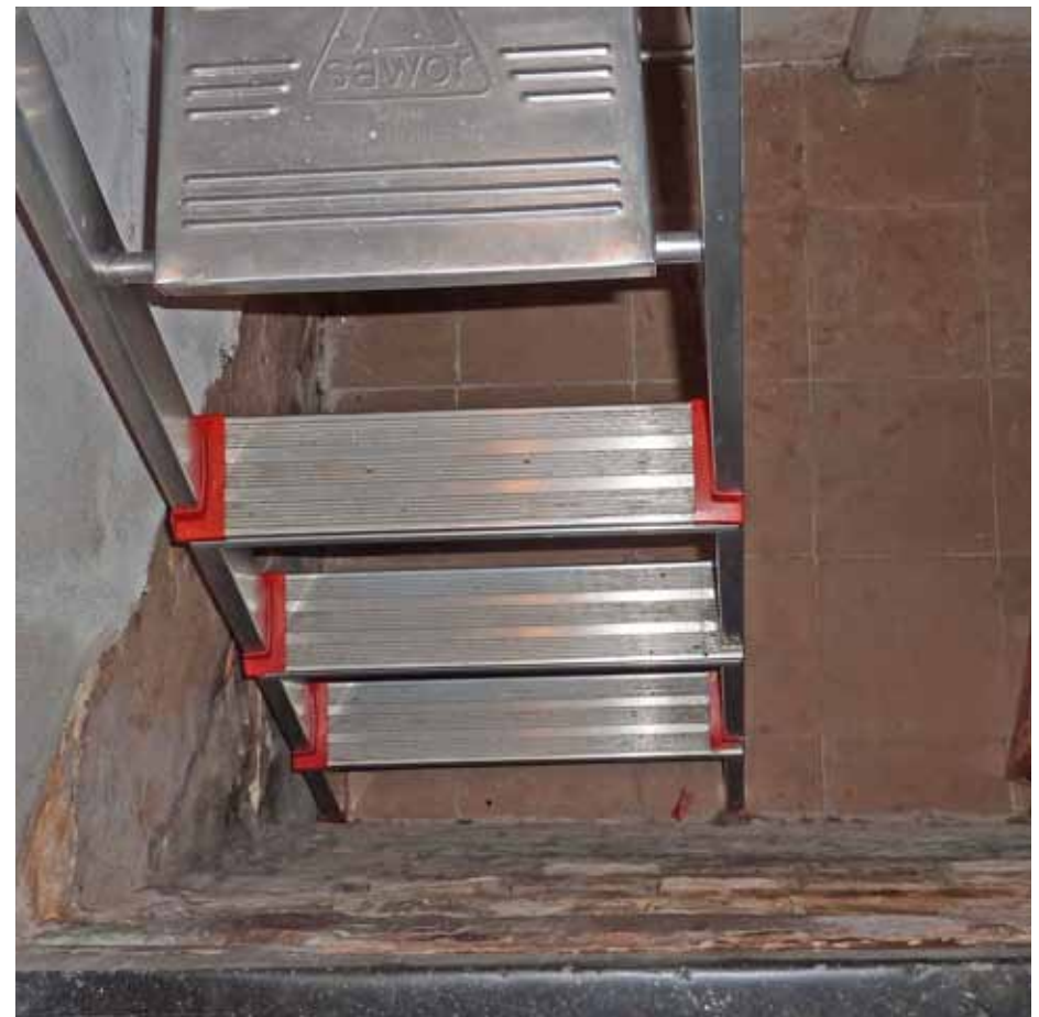
Afbeelding 26. De keldervloer bestaat uit vierkante cementtegels (mogelijk 1891). Het houten keldertrapje was aangetast door houtrot als gevolg van op-trekkend en doorslaand vocht en is recent verwijderd. De plaats van het trapje tekent zich nog af in donkerder pleisterwerk.
