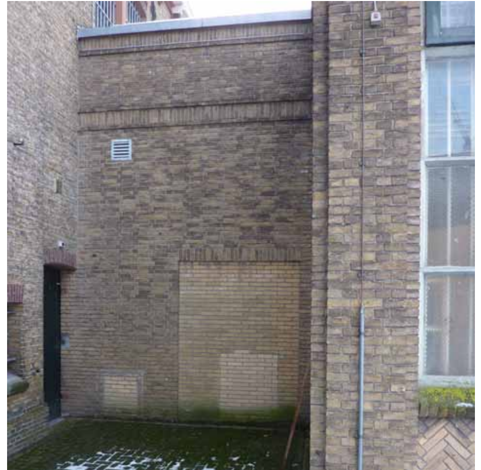
Afbeelding 5. De terugliggende gevel van de aanbouw aan de linker zijde van de voorgevel, grenzend aan bouwdeel D, is blind. In de gevel tekenen zich sporen af van een oudere brede doorgang, die tijdens een latere verbouwing in halfsteens metselwerk dichtgezet werd. In deze dichtzetting, alsmede in de muurdam nabij bouwdeel D, tekenen zich vervolgens nog twee kleinere gevelopeningen af, die eveneens in een later stadium weer middels lichtere gele stenen gedicht werden.
