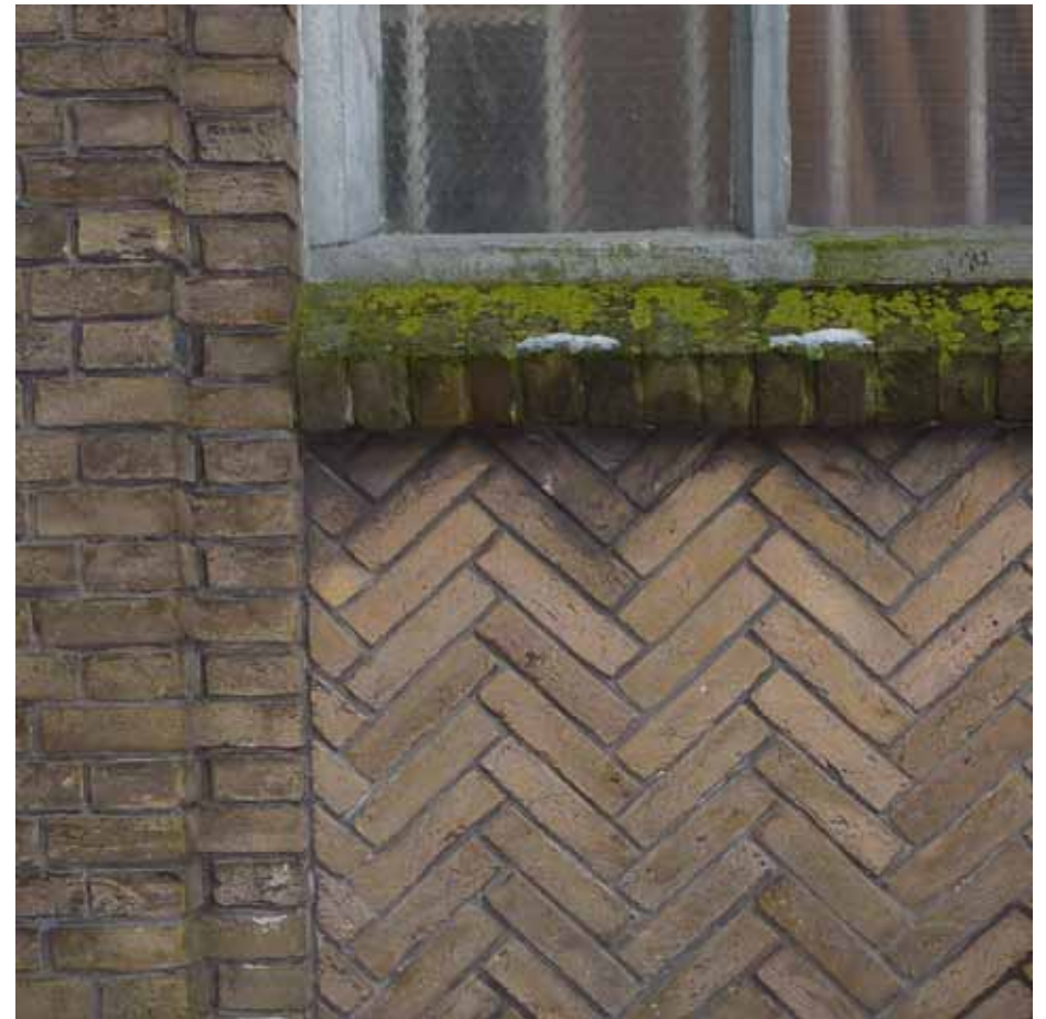
Afbeelding 7. Detail van de voorgevel. Onder de vensters zijn de borstweringen voorzien van decoratief metselwerk in de vorm van een visgraatmotief.
