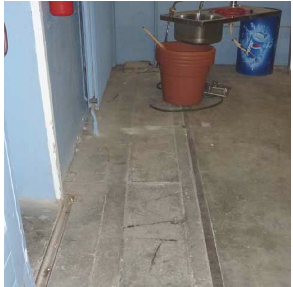
Afbeelding 28. Detail van de vloer van de smederij, nabij de doorgang naar ruimte K0.05. In de vloer zijn ijzeren strippen opgenomen, mogelijk behorende bij oudere machines of werktuigen, zoals een loopkat.
