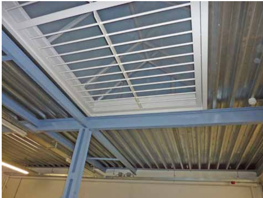
Afbeelding 19. Detail van het huidige dak met de nieuwe, kleinere lichtstraat.
