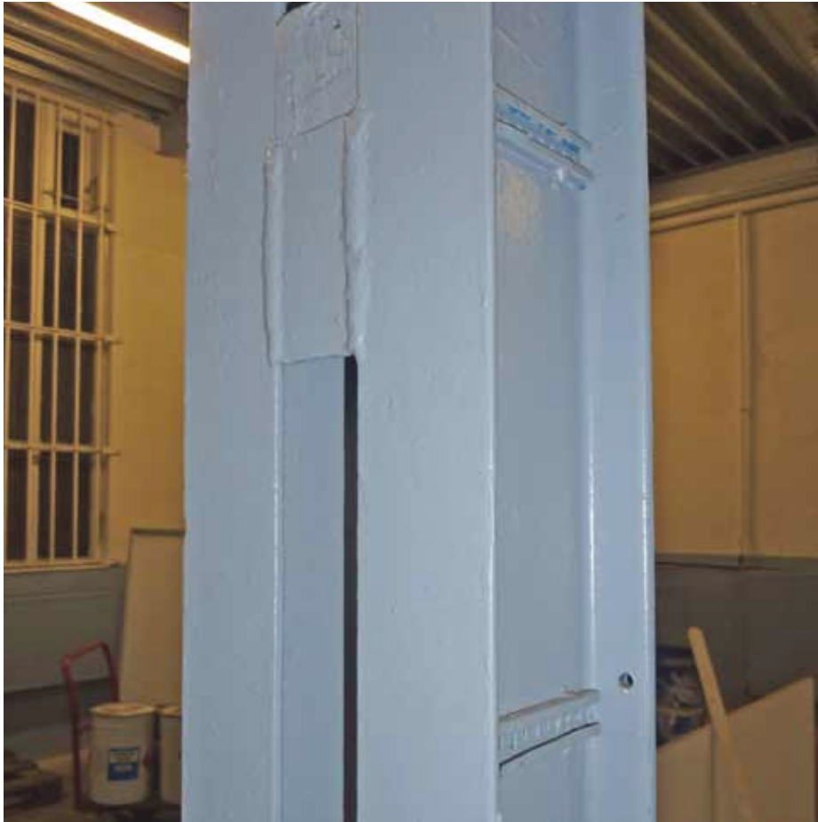
Afbeelding 21. Detail van een stalen kolom. De kolommen zijn samengesteld uit telkens twee INP 140 profielen, die middels tussenschotjes aan elkaar gelast zijn.
