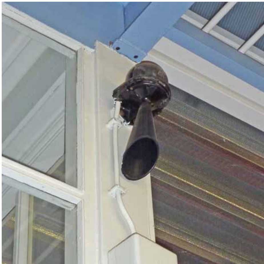
Afbeelding 29. Detail de luchthoorn in de smederij, zoals bevestigd tegen de bewakingsruimte. De hoorn dateert vermoedelijk uit de bouwtijd (1948).
