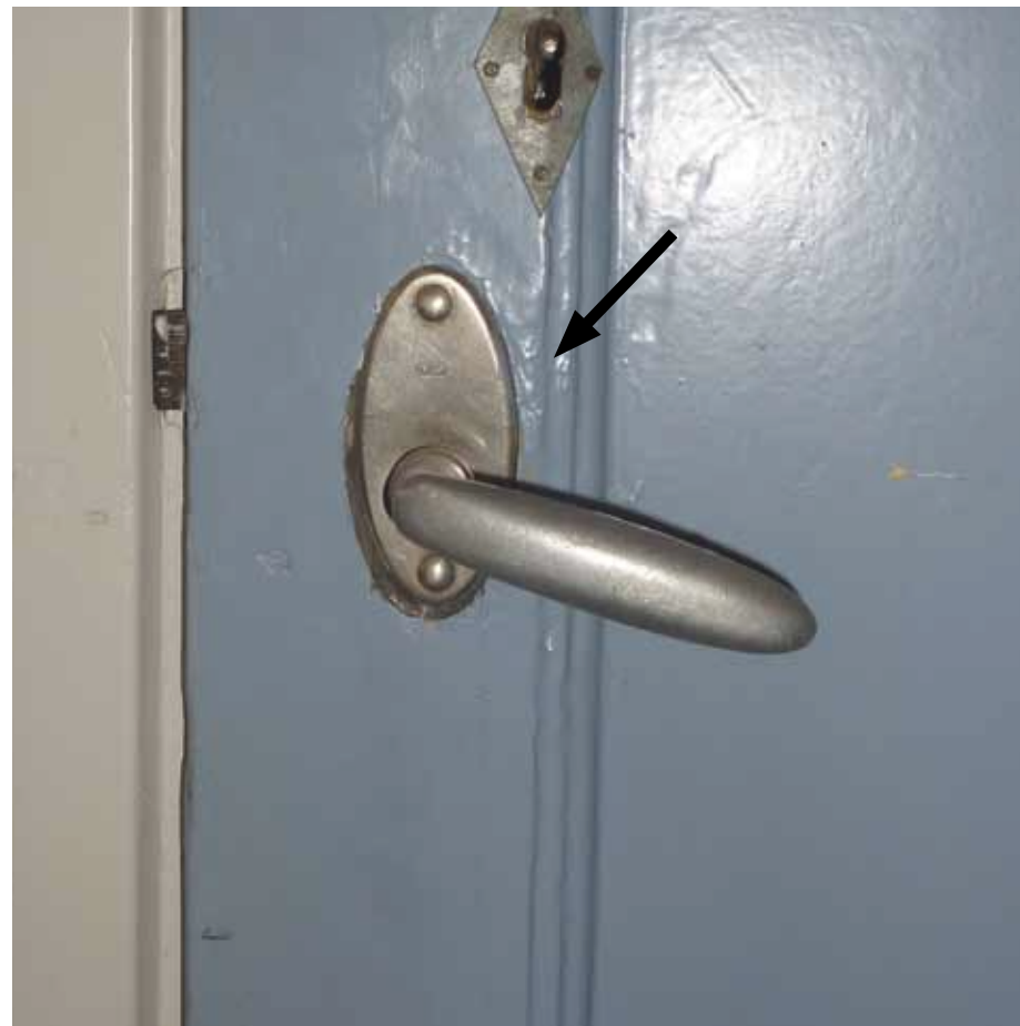
Afbeelding 37. Detail van de vorige afbeelding met de ijzeren deurklink en lensvormige rozet, daterend uit de bouwtijd (1948).
