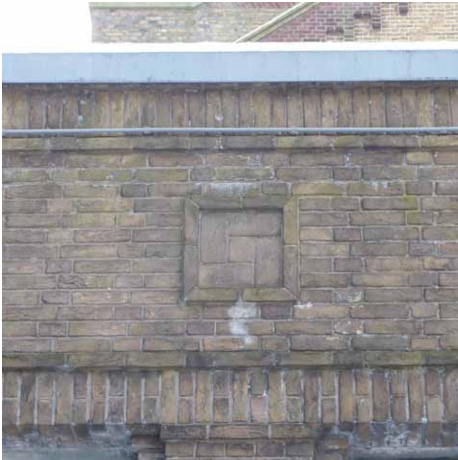
Afbeelding 6. Detail van de kroonlijst boven de voorgevel. In het fries zijn boven de pilasters decoratieve uitspringende vierkanten opgenomen, elk bestaande uit een viertal platte stenen rondom een vierkante steen.
