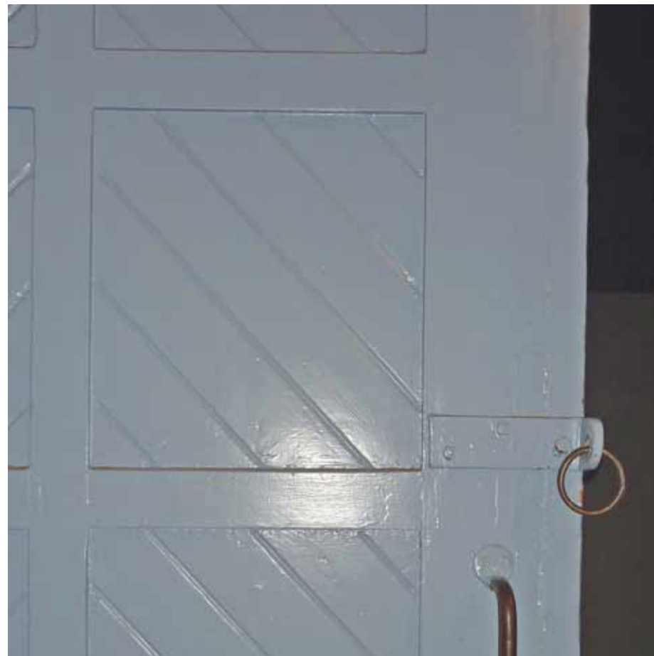
Afbeelding 26. Detail van de vorige ruimte met de schuifdeur in de vorm van een paneeldeur met een diagonale vulling van rabatdelen. Deze detaillering, alsmede het hang- en sluitwerk, is karakteristiek voor de bouwtijd van de smederij (1948).
