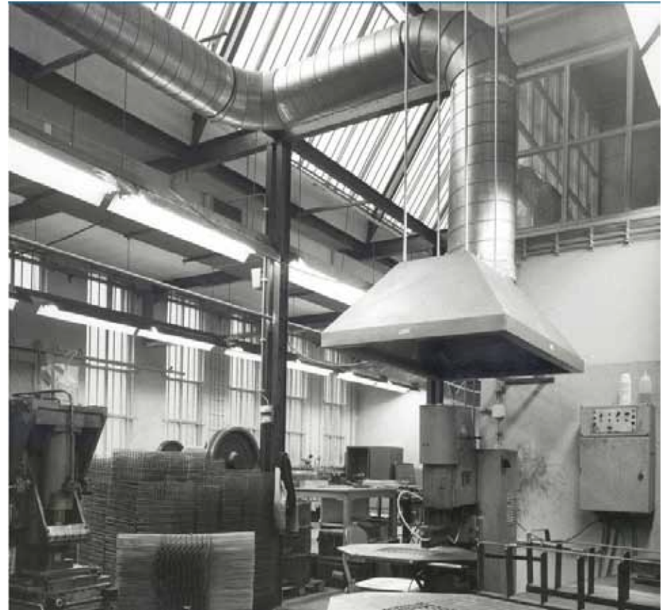
Afbeelding 18. Overzicht van het interieur van de smederij gezien richting het noordoosten in februari 1983. Hier is de oude dakconstructie met de lichtstraat nog aanwezig. Foto: Collectie Beeldbank Leeuwarden, documentnr.: FDBLH-SPLB049.
