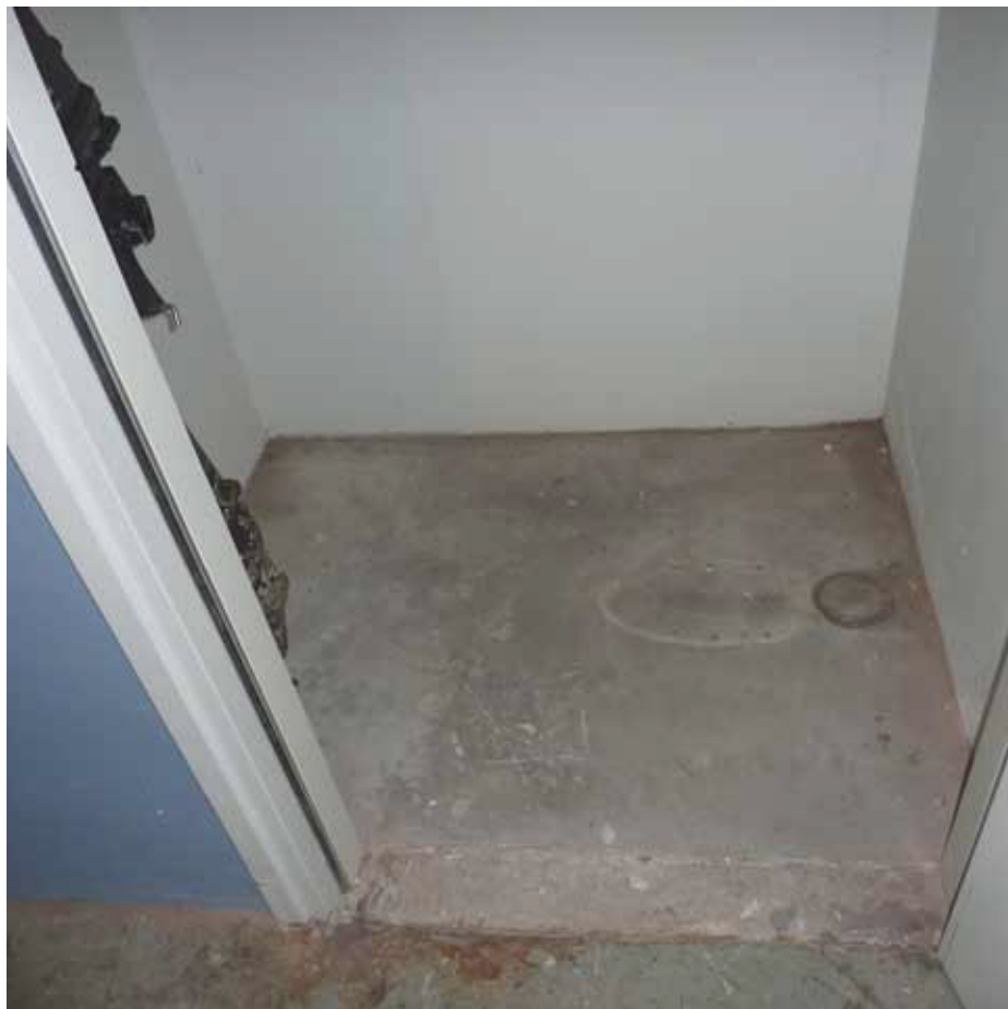
Afbeelding 36. Zicht in de voormalige toiletruimte K0.02.
