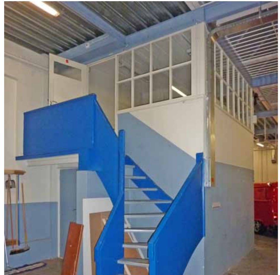
Afbeelding 31. Overzicht van de bewakersruimte K0.04 gezien richting het zuidwesten. De trap met gesloten balustrades en open treden is markant vormgegeven. Links sloot oorspronkelijk een tweede insteekverdieping op het hoogste bordes aan. Zie ook Afbeelding 17.
