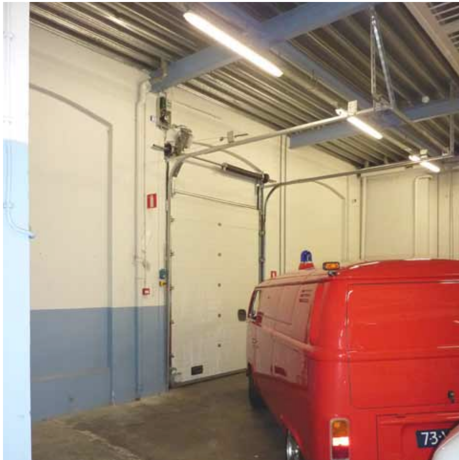
Afbeelding 27. Overzicht van ruimte K0.01 gezien richting het zuidwesten. De wand met spaarbogen en blindnissen hoort bij gang K0.06 van het alcovengebouw en dateert uit 1870. De overheaddeur in de wand is recent (1997).
