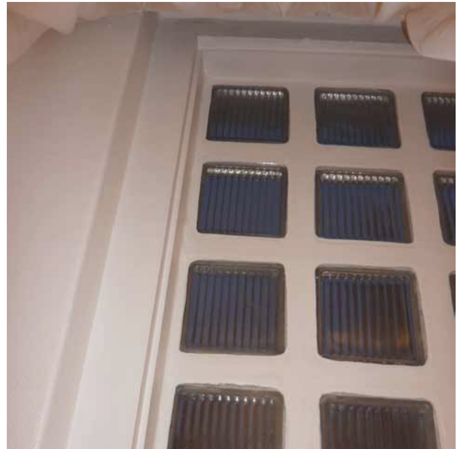
Afbeelding 145. Detail van één van de vensters in de buitengevel van de verbrede gang. De vensters (1957) zijn opgebouwd uit geribde glazen bouwstenen.
