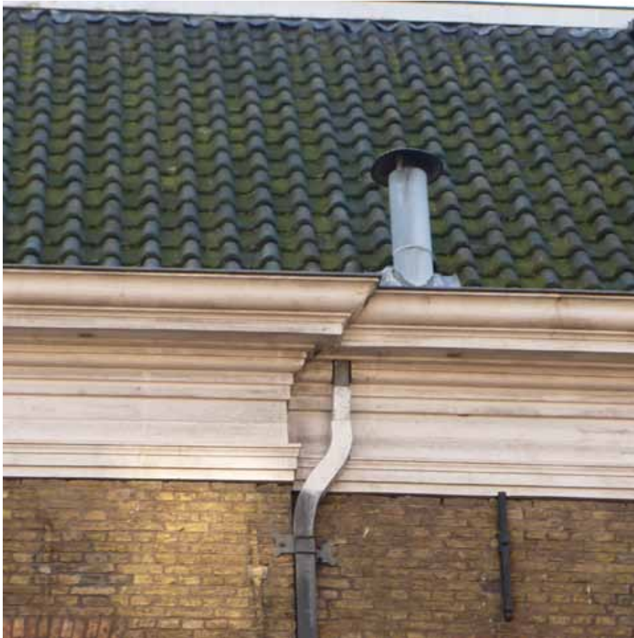
Afbeelding 109. Linker deel van de voorgevel van bouwdeel A ter hoogte van de kroonlijst. Bij het vervangen van de kap in 1959, zijn tevens romaanse pannen aangebracht.
