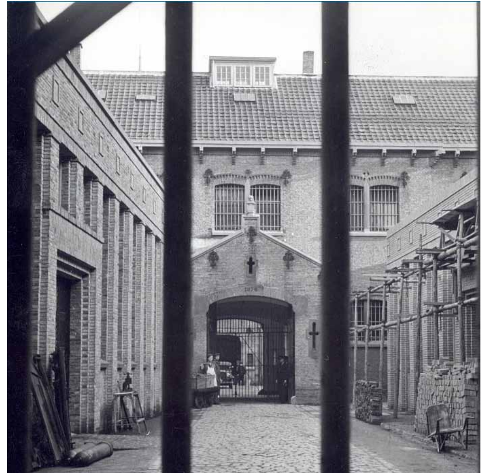
Afbeelding 165. Zicht op de timmerwerkplaats links en de smederij rechts, vanuit de poort in bouwdeel B, tijdens de bouw in december 1948. De smederij is hier nog van houten steigers voorzien Foto: Collectie Beeldbank Leeuwarden, documentnr.: FDBLHSPLA033.
