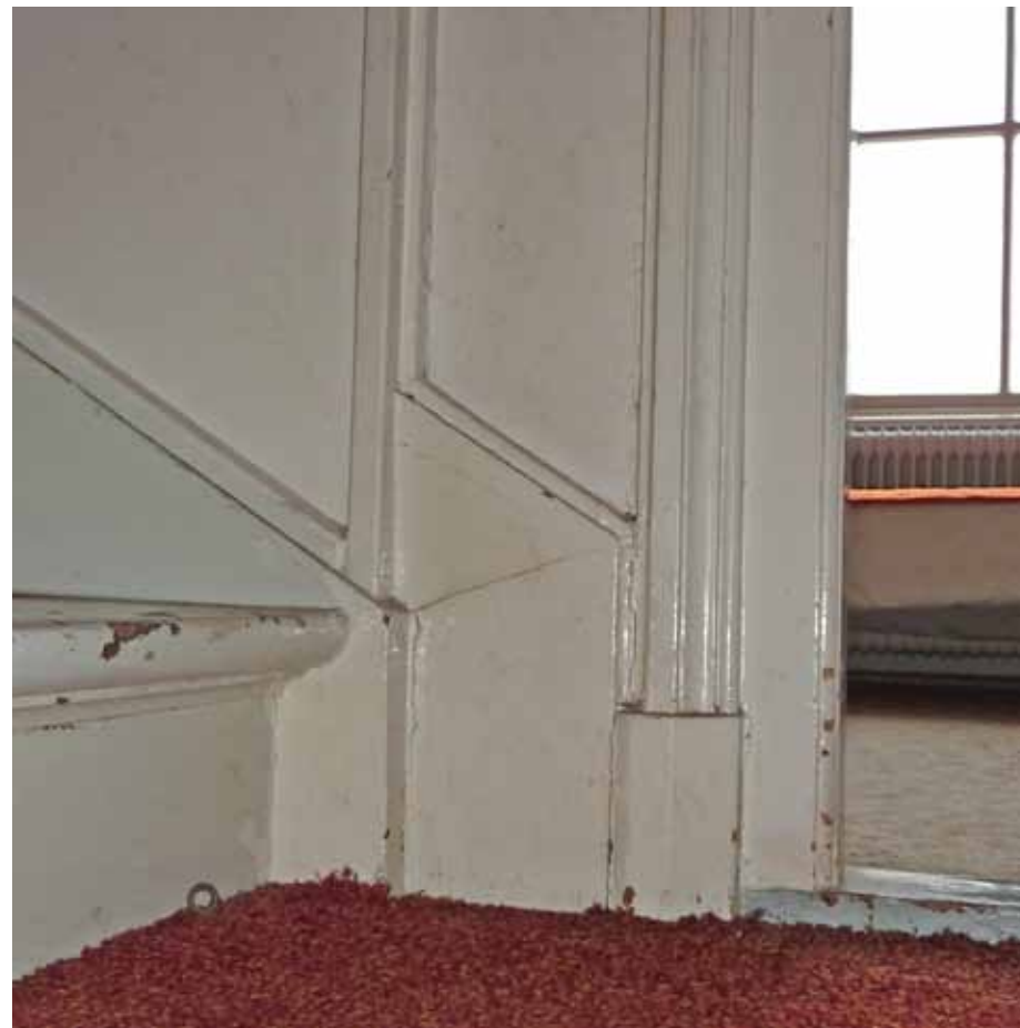
Afbeelding 159. Zicht op de onderste trede van de trap naar de tweede verdieping. De treden van de trap zijn aan de onderzijde voorzien van een profilering en de bovenzijde van de trapboom was afgewerkt met een plint, nu grotendeels aan het zicht onttrokken door secundaire voorzetwanden (XXc).
