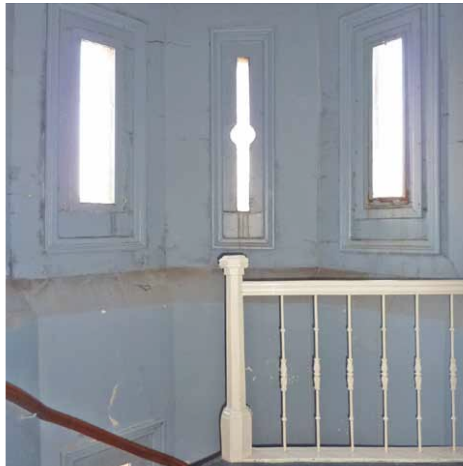
Afbeelding 151. Zicht op de balustrade van de trap in één van de traptorens van bouwdeel B.
