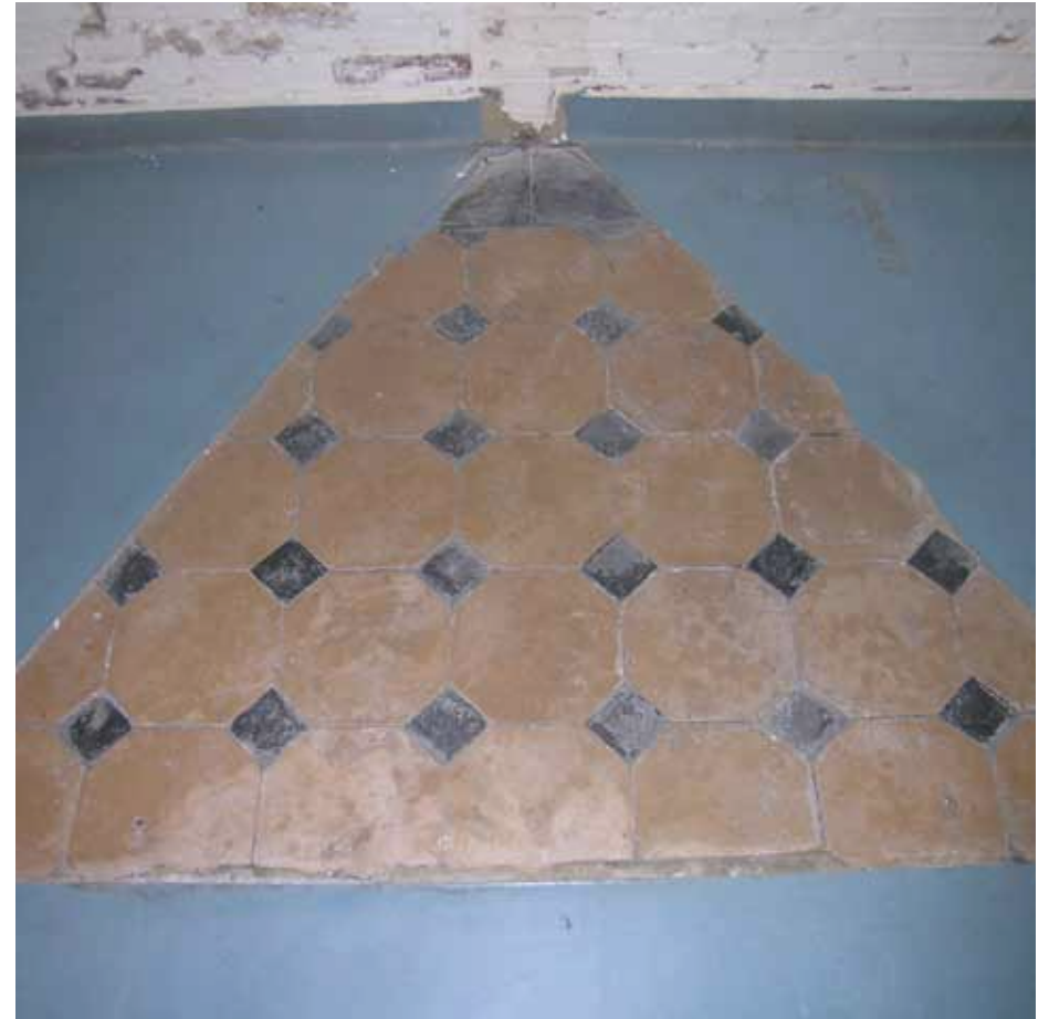
Afbeelding 44. Detail van de oorspronkelijke tegelvloer onder de huidige gietvloeren in de cellenhallen van de bouwdelen F en I (1997). De vloer dateert uit de bouwtijd en is opgebouwd uit hardgebakken achthoekige okergele tegels met zwarte vierkante tegeltjes en een zwarte border langs de wanden.
