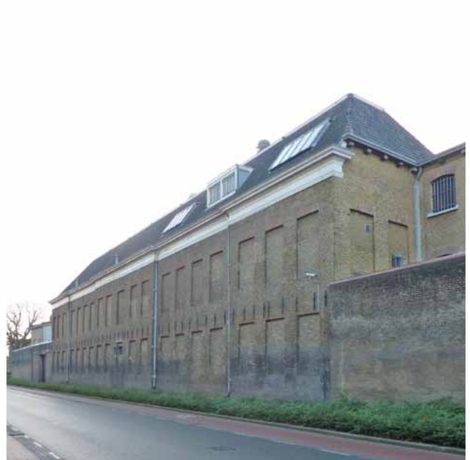
Afbeelding 181. In verband met het dempen van de gracht in 1957 werden tevens de muren aan de noordzijde verhoogd.
