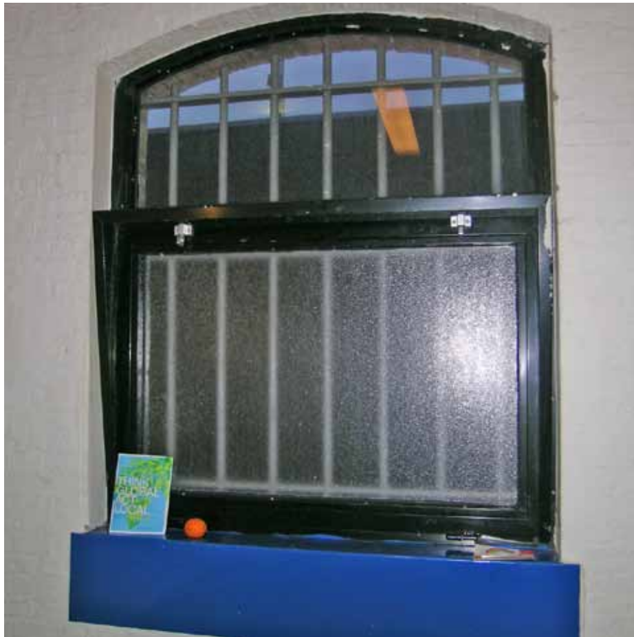
Afbeelding 148. De stalen kozijnen in de cellen van de bouwdelen F en I zijn recent (1997) en bestaan uit vaste boven- en kiepende onderramen. De vensters zijn aan de buitenzijde voorzien van tralies. De oorspronkelijke ventilatieopeningen in de onderdorpels zijn afgedekt door middel van blauwe stalen platen.
