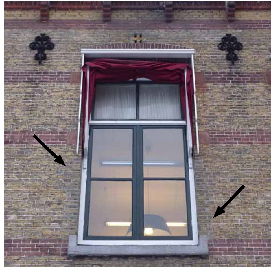
Afbeelding 132. Overzicht van één van de vensters van bouwdeel E ter hoogte van de eerste verdieping. Een aantal vensters werd verlengd (1949) bij het wijzigen van de functie van de achterliggende vertrekken.
