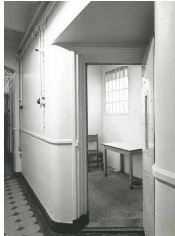
Afbeelding 57. Zicht op de ingang van de zuidelijke isoleercel in februari 1983. De isoleercellen werden in 1957 ingebracht, waartoe de verbindingsgang tussen de bouwdelen F en G zowel naar het noorden als zuiden werd uitgebouwd. De lambrislijsten op de wanden werden eveneens bij deze verbouwing aangebracht. Op de achtergrond is een stalen venster zichtbaar dat de voor deze fase typerende detaillering heeft met ongeprofileerde platte roeden. Foto: Collectie Beeldbank Leeuwarden, documentnr.: FDBLHSPLB012.
