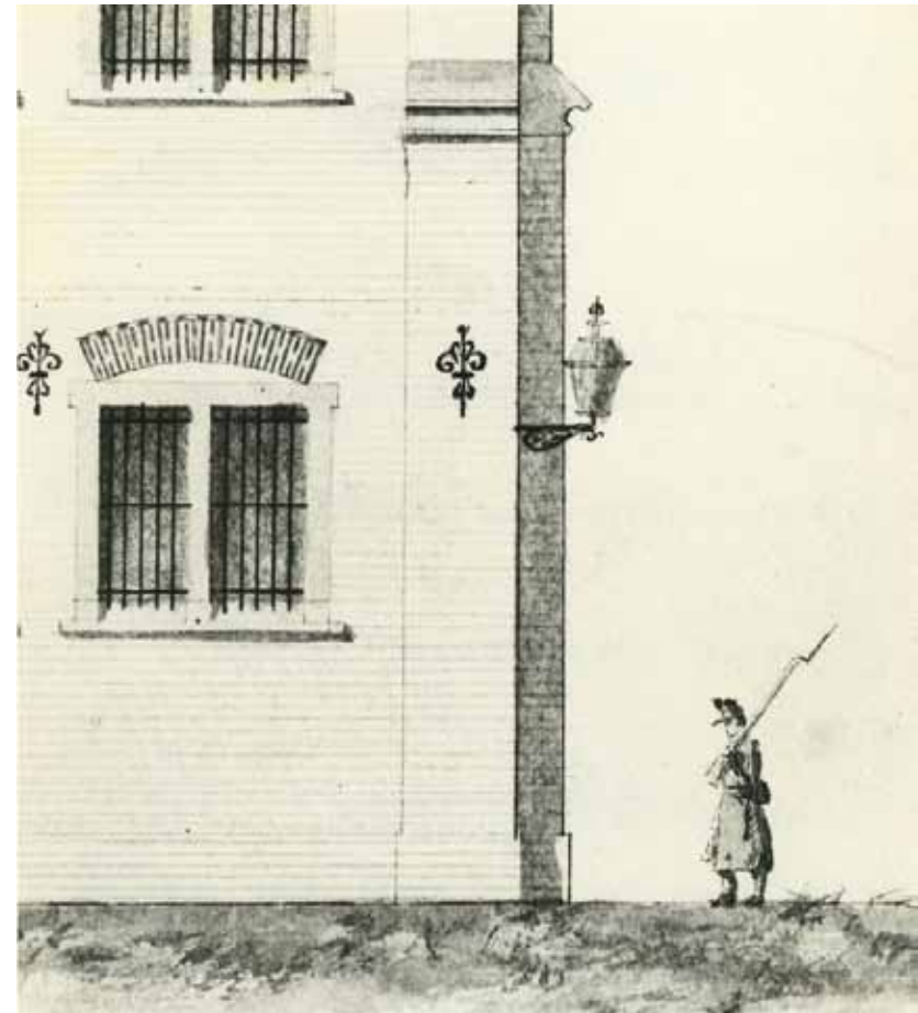
Afbeelding 30. 1875. Schildwacht bij het Huis van Opsluiting en Tuchtiging te Leeuwarden. Als buitenverlichting werden roodkoperen beglaasde lantaarns aangebracht, rustende op in de muren gemetselde gegoten ijzeren consoles, voorzien van geslagen ijzeren kattenkoppen, koperen pilaartjes met dito kranen en vlemuisbranders.
