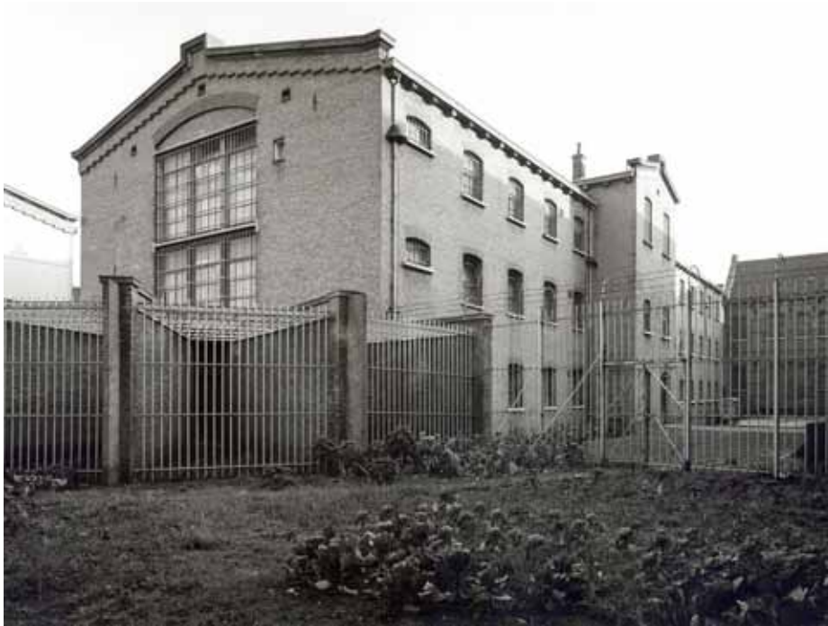
Afbeelding 172. Overzicht van de noordelijke kopgevel en westelijke zijgevel van bouwdeel F in februari 1983. Alle acht wandelplaatsen waren nog aanwezig en de in 1988 gerealiseerde achterwand van de verbindingsgang tussen de bouwdelen E en F was nog niet aanwezig. Foto: Collectie Beeldbank Leeuwarden, documentnr.: FDBLHSPLB032
