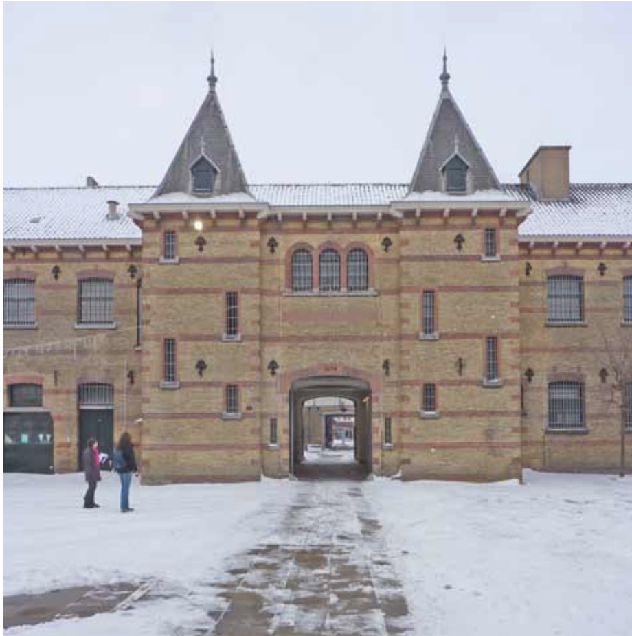
Afbeelding 32. Zicht op de poort in de oostgevel van de binnenplaatsvleugel van bouwdeel D. De architectuur van de bouwdelen D en E rond de tweede binnenplaats wordt gekenmerkt door speklagen in rode baksteen en hoekblokken en stijlen in - eveneens rode - Udelfanger zandsteen. Ook de vierkante torens rond de binnenplaats zijn kenmerkend voor dit deel van het Blokhuispoortcomplex.
