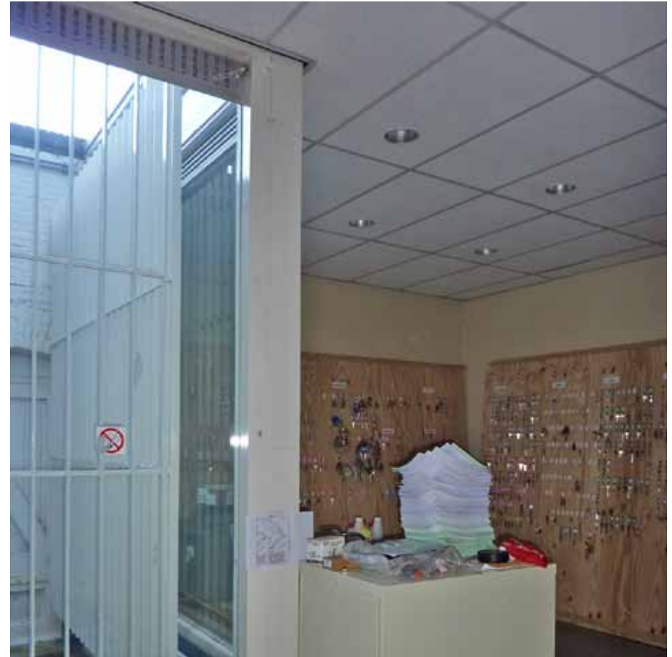
Afbeelding 147. Zicht in de wachtruimte in bouwdeel K, gezien naar het noordwesten. Geheel links is het restant van de oude ommuurde buitenruimte van de kommandantswoning zichtbaar met de opgeklampte deur in de buitengevel (1870). De glaspuien dateren van de verbouwing uit 1988.
