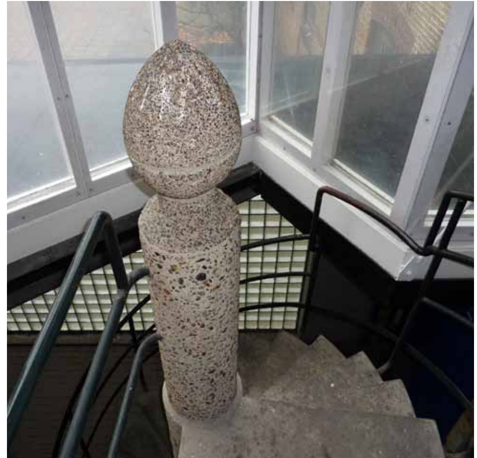
Afbeelding 161. Detail van de trap aan de achtergevel ter hoogte van de eerste verdieping. De betonnen trap (1959) stond tot 1991 buiten waardoor de knop een verwerking aan de bovenzijde kent.
