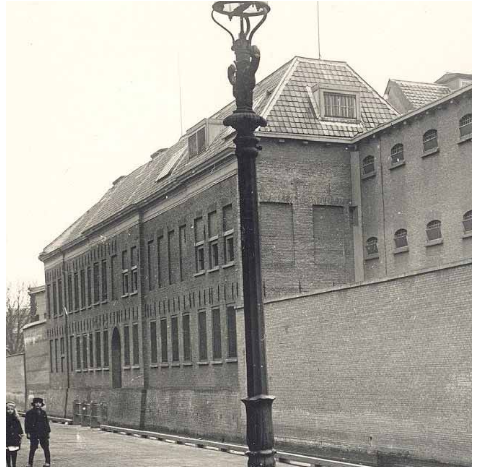
Afbeelding 108. De voorgevel van bouwdeel A in 1929. De Keizersgracht werd in 1959 gedempt, waarbij tevens de poort werd dichtgezet en de ommuring verhoogd. In 1929 werd het schilddak nog gedekt door vlakke Friese blauw geglaazuurde pannen, deze werden later vervangen door Romaanse pannen (1959). Foto: Collectie Beeldbank Leeuwarden, documentnr.: FDKEIZGRA016.
