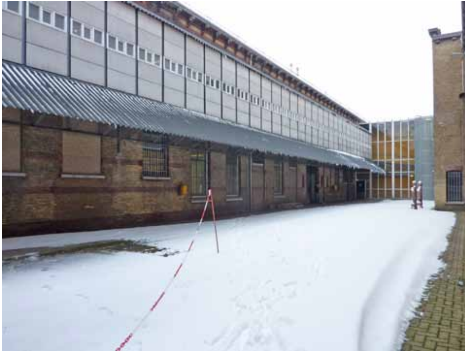
Afbeelding 174. Overzicht van de derde binnenplaats in 2009 gezien richting het noorden. Na de bouw van de verbindingsgang tussen de bouwdelen E en F werd de derde binnenplaats aan vier zijden omsloten. De bestrating werd in de jaren '80 voorzien van betonstenen.
