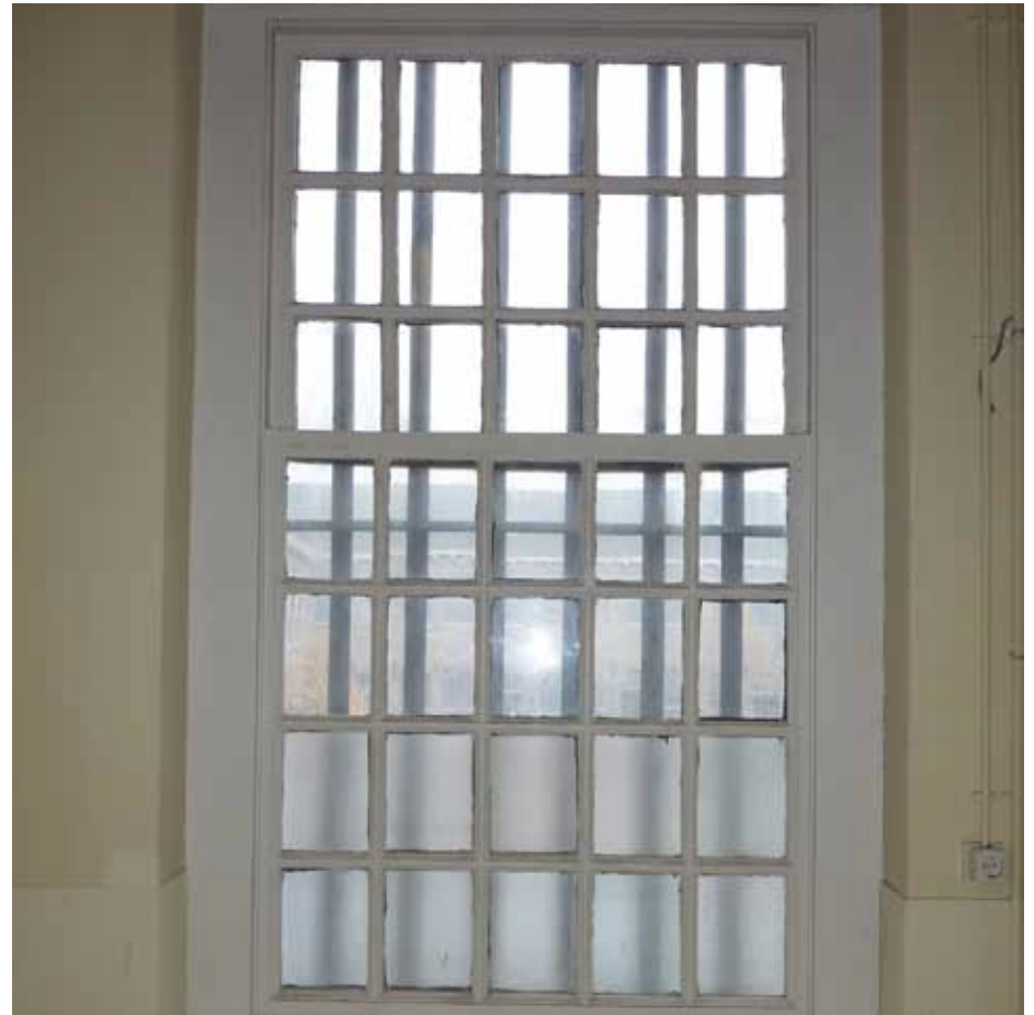
Afbeelding 126. Detail van één van de schuiframen op de eerste verdieping van bouwdeel A. De schuiframen zouden mogelijk kunnen dateren uit de bouwtijd van de vleugel (1822), of zijn ouder en van elders hergebruikt.
