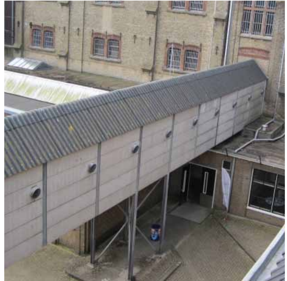
Afbeelding 118. Zicht op loopbrug tussen de bouwdelen I en C. De verschillende vanaf 1988 gerealiseerde loopbruggen zijn voorzien van een golfplaten afdekking. Foto: Dhr. Bastiaans, Monumentenwacht Overijssel en Flevoland / Drenthe 2009.
