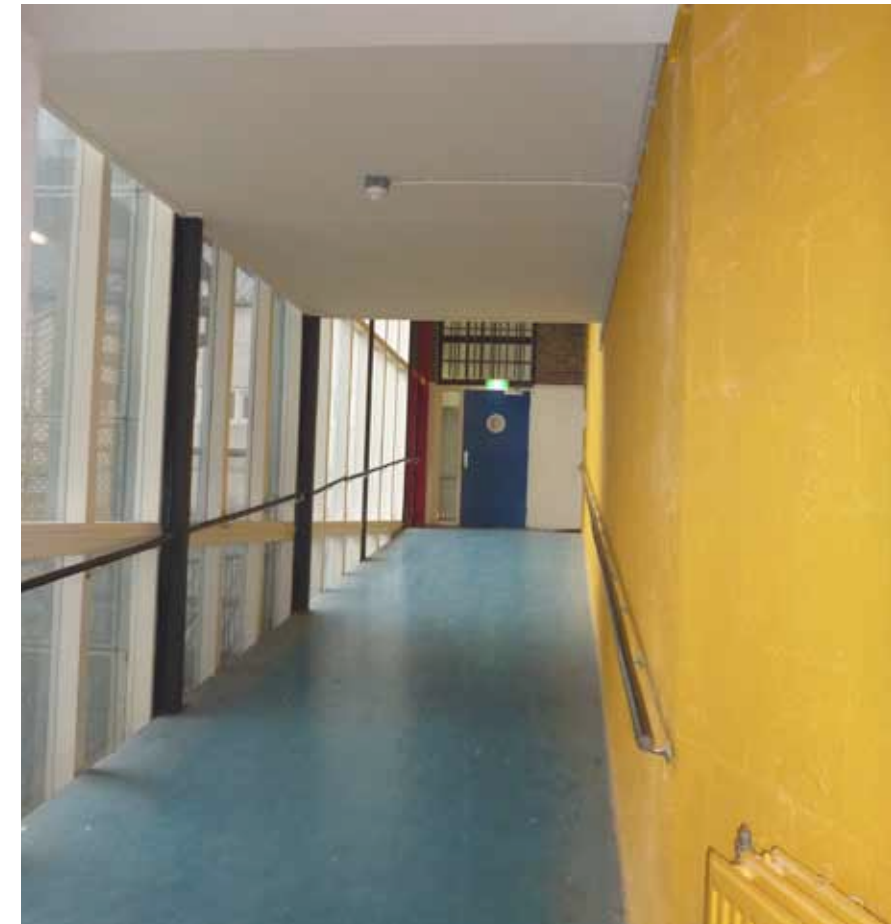
Afbeelding 68. Interieur van de rond 1988 gerealiseerde verbindingsgang tussen de bouwdelen E en F.
