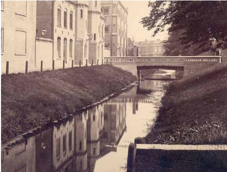
Afbeelding 176. Zicht op de brug naar het poortgebouw in 1884. De brug werd ontworpen door J.F. Metzelaar en uitgevoerd gelijktijdig met de bouw van de bouwdelen B en C. Afbeelding uit Beeldbank Leeuwarden, inventarisnr.: FDBLHSPLB007
