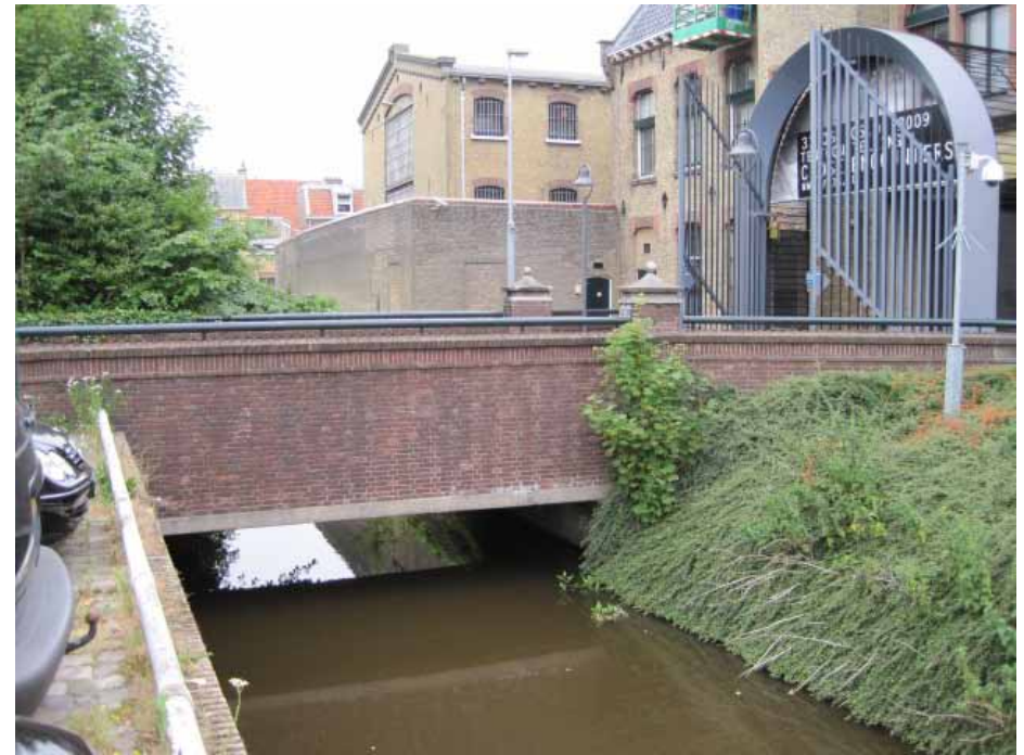
Afbeelding 179. Zicht op de toegangsbrug in 2009. Het stalen hekwerk werd in 1997 aangebracht naar ontwerp van ir. Vegter. Foto: Dhr. Bastiaans, Monumentenwacht Overijssel en Flevoland / Drenthe 2009.
