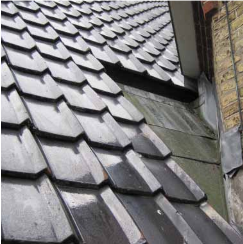
Afbeelding 111. Detail van de vlakke geglazuurde blauwe Friese pannen op het westelijk dakvlak van bouwdeel B. Foto: Dhr. Bastiaans, Monumentenwacht Overijssel en Flevoland / Drenthe 2009.
