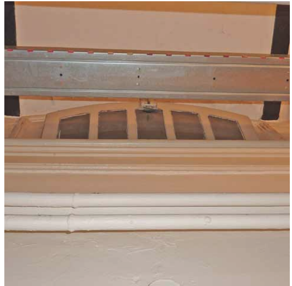
Afbeelding 143. Detail van de linker onderhoek van één van de hoog geplaatste vensters in de zuidwand. De vensters bezaten oorspronkelijk dezelfde hoogte als de vensters in de gang op de eerste verdieping (ruimte N1.01), maar werden bij het verhogen van de achterliggende ruimten (1957) ingekort. De vensterbank werd hierbij herplaatst en het venster voorzien van een nieuw 5-ruits raam met platte stalen roeden (1957).
