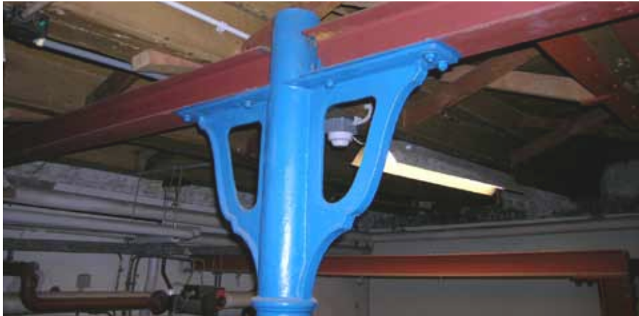
Afbeelding 77. Bovenzijde van één van de kolommen op de begane grond van bouwdeel A. De hergebruikte gietijzen kolommen zijn samen met de ongeschaafd vurenhouten scheggen en andreaskruizen in 1988 ingebracht ter verstijving van de balklaag.
