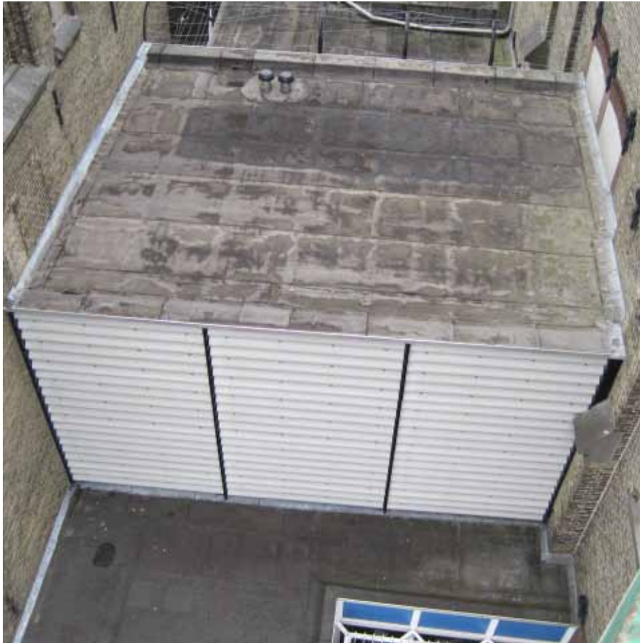
Afbeelding 117. Zicht op de opbouw op bouwdeel K uit 1988. Het dak is voorzien van een bitumen dakbedekking. Foto: Dhr. Bastiaans, Monumentenwacht Overijssel en Flevoland / Drenthe 2009.
