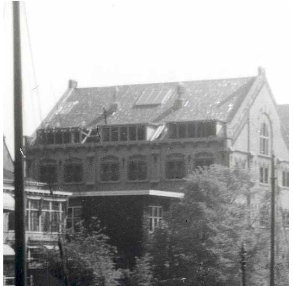
Afbeelding 112. Zicht op het westelijke dakvlak van bouwdeel C in 1948. De dakkapellen zijn op deze afbeelding nog in aanbouw. In het dakvlak zijn kleurverschillen waarneembaar, hetgeen duidt op dichtzettingen van voormalige doorvoeren en reparaties. Foto: Collectie Beeldbank Leeuwarden, inventarisnr.: FDZGRWALA060
