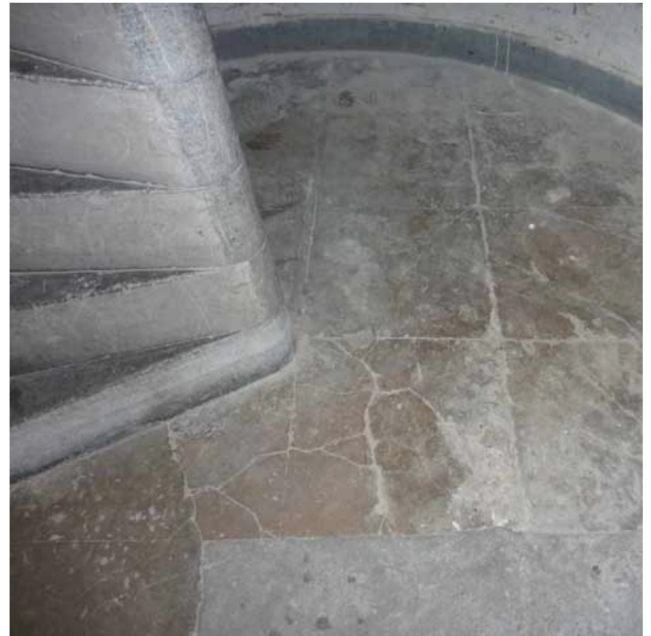
Afbeelding 33. De cementvloer van de begane grond van één van de torens van bouwdeel E is voorzien van ingekraste voegen op een raster van 50 x 50 cm. Soortgelijke vloeren bevinden zich nog op de vloeren van de zolders en gedeelten van de begane grond van de bouwdelen D en E.
