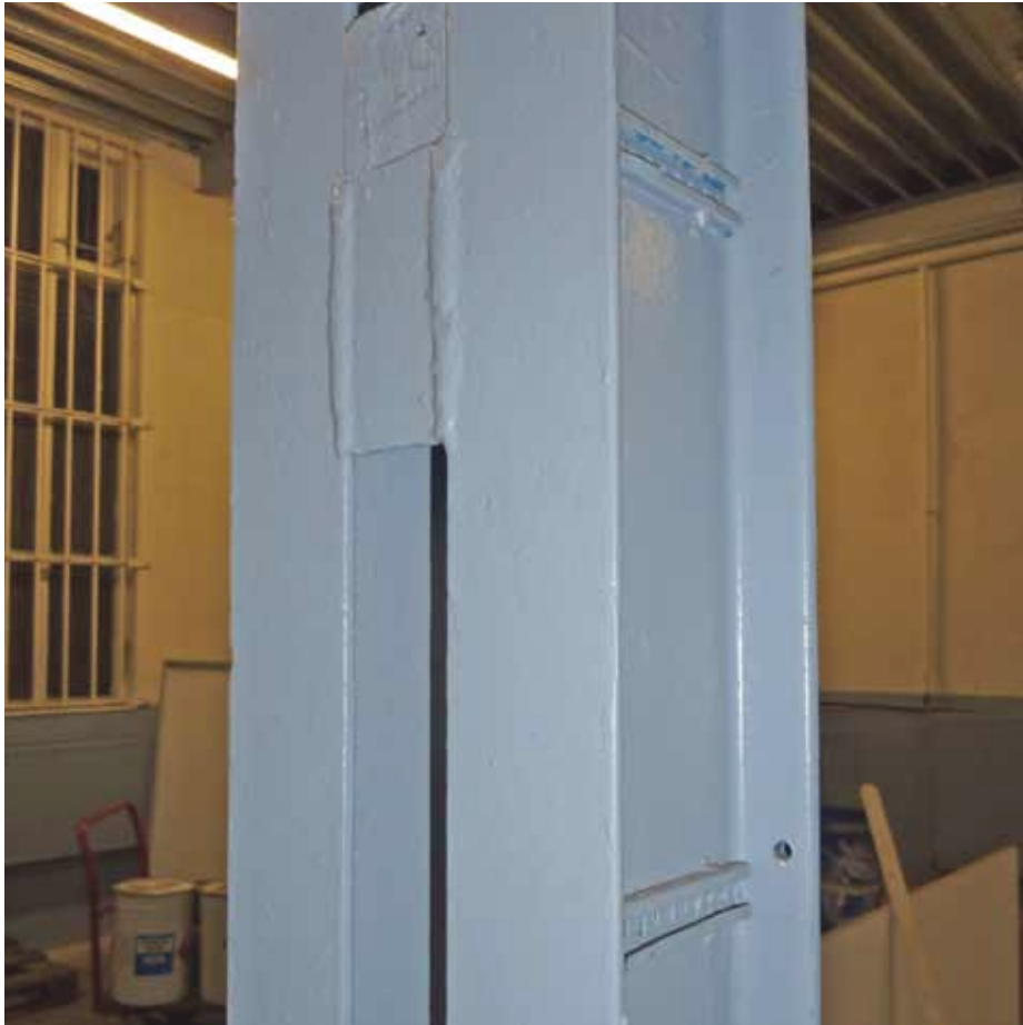
Afbeelding 91. Detail van een stalen kolom in bouwdeel J. De kolommen zijn samengesteld uit telkens twee INP 140 profielen, die middels tussenschotjes aan elkaar gelast zijn.
