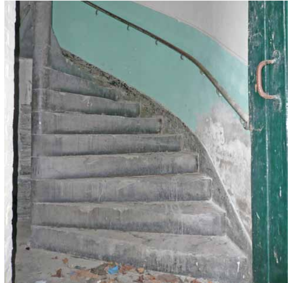
Afbeelding 155. Zicht op de onderzijde van de trap zoals deze werd aangebracht in de traptorens in de noordoostelijke en zuidwestelijke hoek van de tweede binnenplaats. De cementvloer van de begane grond is voorzien van ingekraste voegen op een raster van 50 x 50 cm. De donker gezoete massieve harstenen treden van de eerste vlucht zijn uitgesleten.
