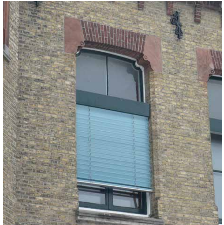
Afbeelding 128. Detail van één van de vensters van bouwdeel B met de zonwering uit 1988. De vensters zijn voorzien van zeer slanke uit de bouwtijd daterende kozijnen (1870) en waren oorspronkelijk voorzien van schuiframen. De huidige stolpramen dateren vermoedelijk uit 1948.
