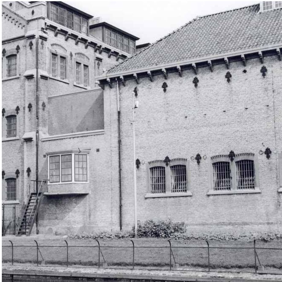
Afbeelding 186. Foto van de zuidgevel van de grachtvleugel van bouwdeel D en aan de linkerkant de zuidgevel van de uitbouw met de voormalige strafcellen in de periode 1970-75. De erker in de zuidgevel van de uitbouw is mogelijk een wachterspost en kan tijdens de grote verbouwing in 1948 tot stand zijn gekomen.
