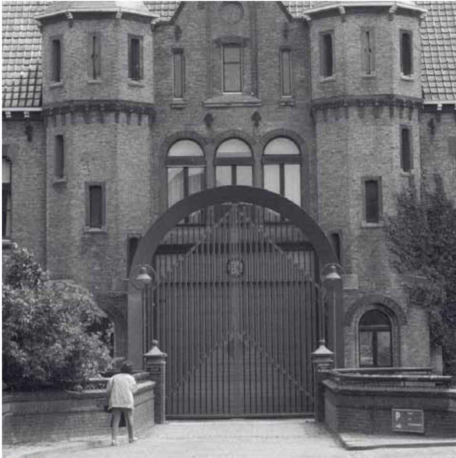
Afbeelding 72. Toegangspoort in het poortgebouw in 1998. De oorspronkelijke doorgang werd volgens plannen van de heer Vegter verder uitgebroken ten behoeve van de toegankelijkheid. Aan de voorzijde werd een stalen hekwerk geplaatst.
