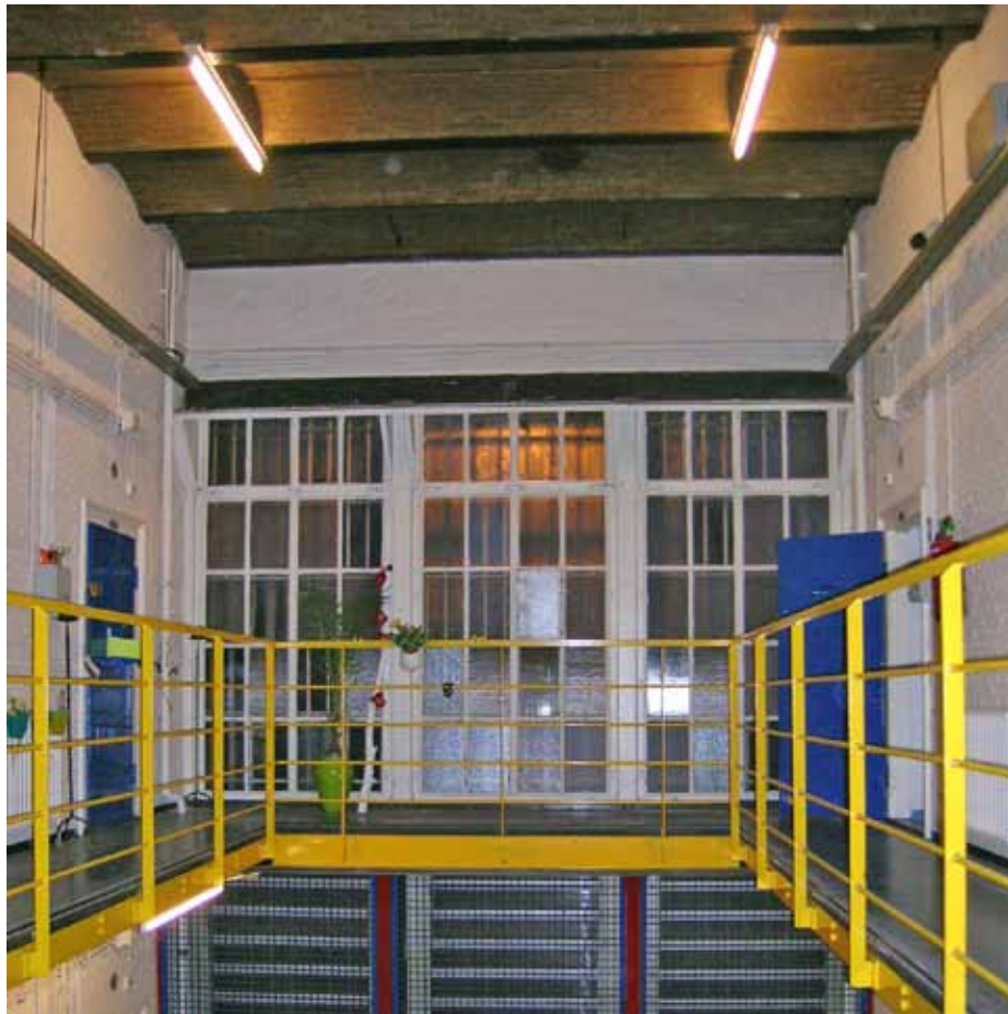
Afbeelding 87. De plafonds van de cellenhal en de individuele cellen in de bouwdelen F en I bestaan uit ongesausde halfsteens troggewelfjes in schoon metselwerk op INP-liggers.
