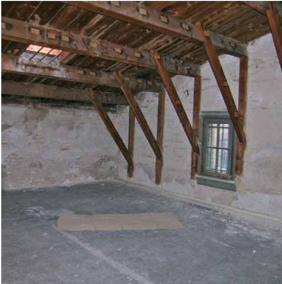
Afbeelding 103. Overzicht van één van de zolderruimten van bouwdeel G.
