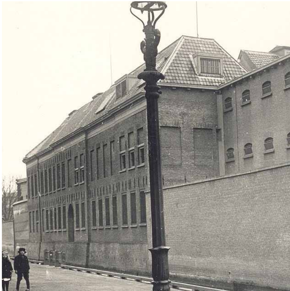
Afbeelding 54. De voorgevel van BdA in 1929. De Keizersgracht werd in 1959 gedempt, waarbij tevens de poort werd dichtgezet. In 1929 werd het schilddak nog gedekt door vlakke Friese blauw geglazuurde pannen, deze werden later vervangen door Romaanse pannen (1959).
