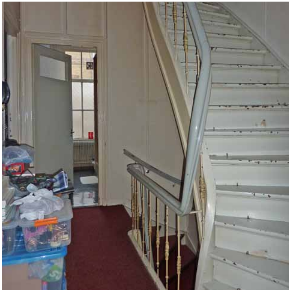
Afbeelding 158. Overzicht van de overloop van bouwdeel H richting het zuiden (badkamer). De geprofileerde handlijst van de trap wordt ondersteund door gietijzeren balusters.
