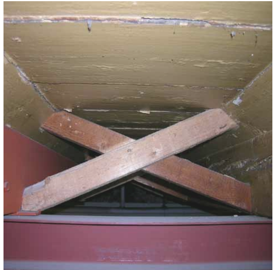
Afbeelding 79. Zicht tussen de balken van bouwdeel A. Vanwege de hart op hart afstand van één meter zijn tegen het doorbuigen van de vloerdelen onder 45 graden afgeschuinde regels aangebracht. Bij het verstevigen van de balklaag zijn ongeschaafd vurenhouten andreaskruizen aangebracht tussen de balken. Deze zijn opmerkelijk zorgvuldig ingelaten in de kantplanken. Geheel onder is de stalen onderslagbalk (1988) zichtbaar.
