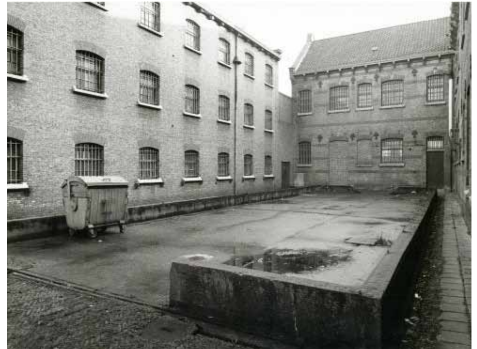
Afbeelding 173. De derde binnenplaats rond 1983, binnenplaats van het Huis van Bewaring, bij de derde poort, vroeger plaats voor opslag van brandstof. De binnenplaats bezat aanvankelijk een klinkerbestrating, doch werd later gewijzigd en voorzien van een band van trottoirtegels langs bouwdeel E. Afbeelding uit Beeldbank Leeuwarden, inventarisnr.:FDBLHSPLB031
