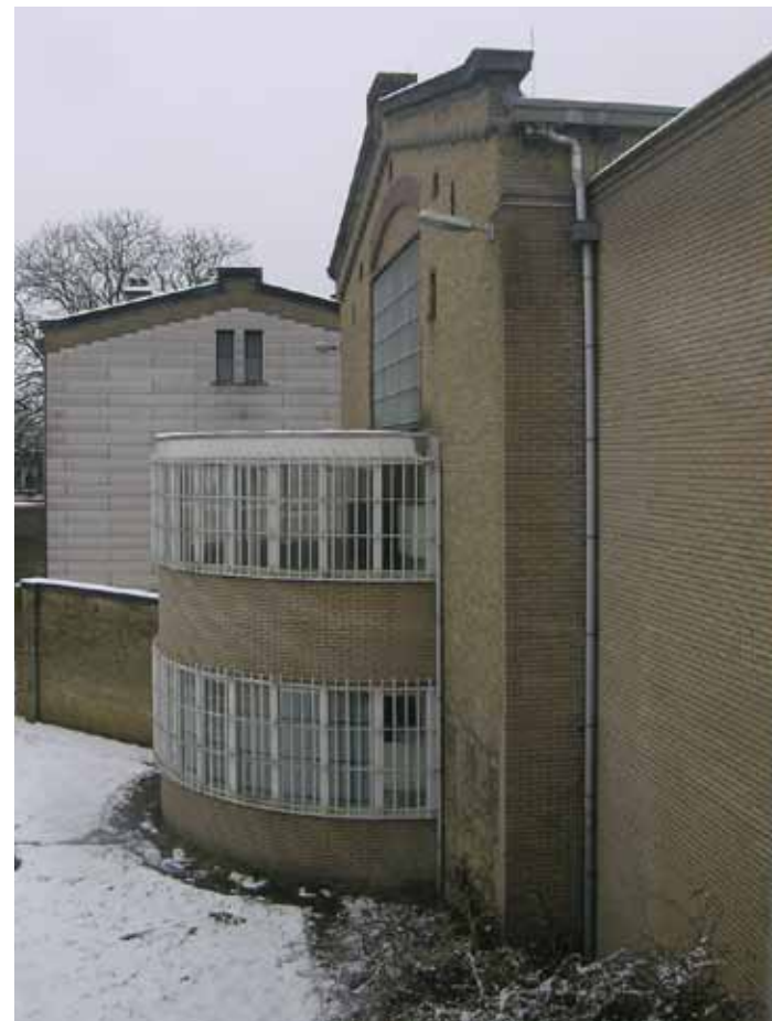
Afbeelding 70. Overzicht van de kopgevel (noordgevel) van Bouwdeel F. De halve cirkelvormige tweelaags aanbouw werd gerealiseerd na het slopen van de wandelplaatsen in 1983. Het onderste deel van het drielicht ter hoogte van de eerste en tweede verdieping is aan de binnenzijde van de aanbouw nog zichtbaar.
