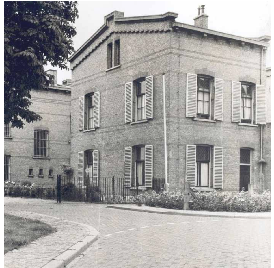
Afbeelding 137. Overzicht van de noord- en oostgevel van bouwdeel H in juli 1961. De onderramen van de schuifvensters werden in het begin van de jaren '50 van de voorgaande eeuw vervangen door stolpramen. De louverluiken werden vermoedelijk reeds tijdens de bouw aangebracht. Foto: Collectie Beeldbank Leeuwarden, documentnr.: FDKEIZGRA022
