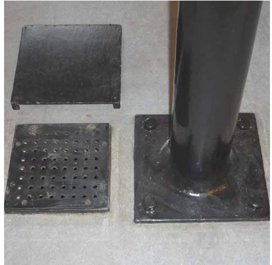
Afbeelding 122. Detail van de voet van één van de kolommen op de verdieping van bouwdeel D. De gietijzeren kolommen zijn door middel van vierkante voetplaten bevestigd op hardstenen basementen. In de vloer zijn gietijzeren roosters aangebracht, ten behoeve van de ventilatie van de onderliggende vloerconstructie.
