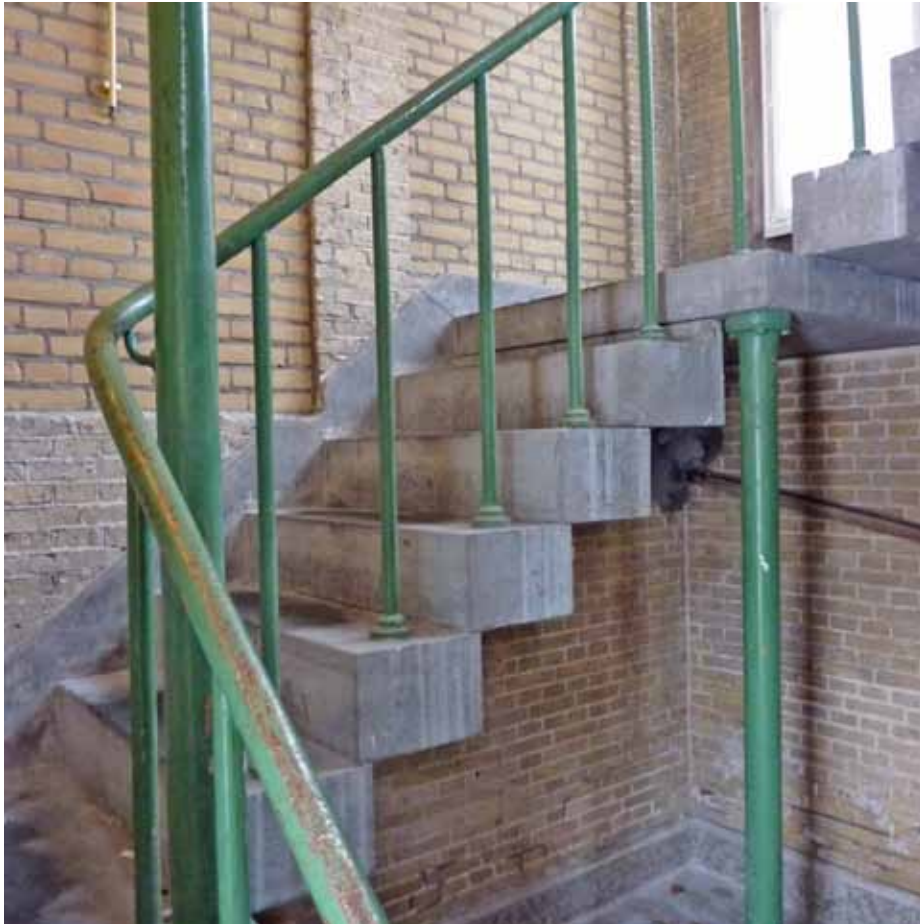
Afbeelding 154. Overzicht van het interieur van de noordelijke traptoren in bouwdeel D. De trappen zijn opgebouwd uit hardstenen blokken van 27 x 19 cm en voorzien van ijzeren balusters. De hardstenen bordessen worden ondersteund door ijzeren kolommen. De invullingen aan de achterzijde zijn secundair (XXc).
