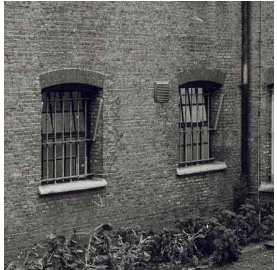
Afbeelding 135. Fragment van Afbeelding 11 van de westgevel in februari 1983). De in 1997 vervangen ijzeren vensters bestonden uit 10-ruits vaste onder- en 10-ruits naar binnen vallende bovenramen. Foto: Collectie Beeldbank Leeuwarden, documentnr.: FDBLHSPLB051
