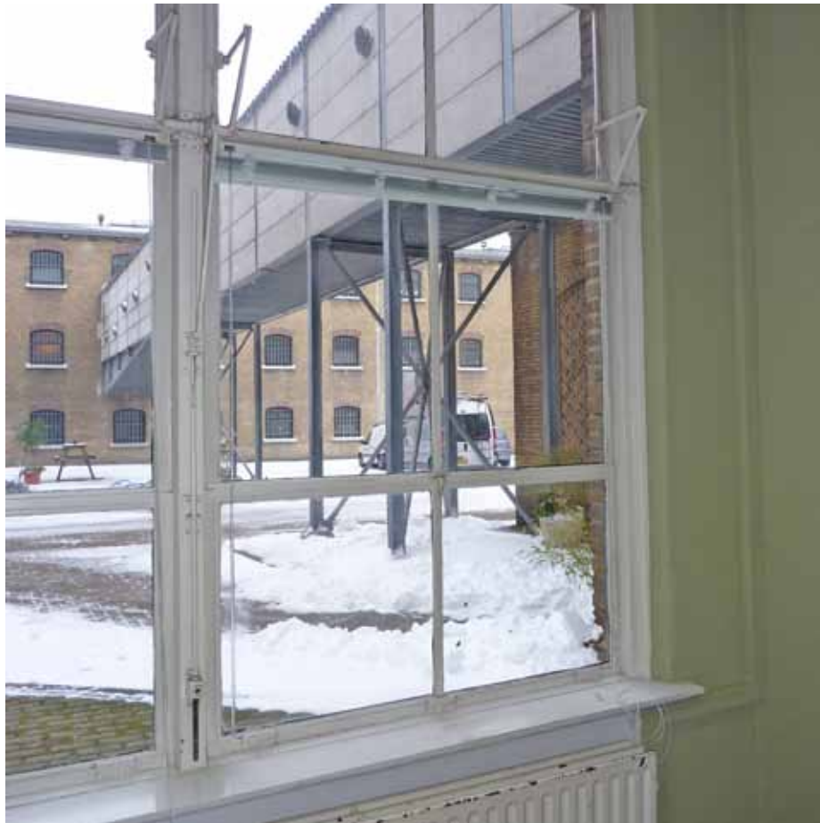
Afbeelding 142. Detail van de ramen in de noordgevel. De stalen ramen bezitten nog de karakteristieke uit de bouwtijd daterende uitzetramen en het bijbehorende bedieningsmechanisme (1957). De ramen zijn aan de onderzijde afgewerkt met een strakke, doch verzorgd gedetailleerde vensterbank.
