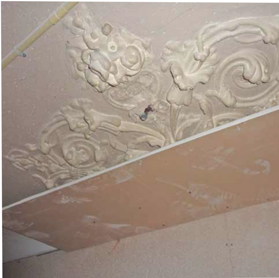
Afbeelding 67. Boven het huidige - in 1988 aangebrachte - verlaagde plafond is de oorspronkelijke indeling van bouwdeel B nog afleesbaar. Alle binnenwanden werden in 1988 verwijderd ten behoeve van een nieuwe indeling met lichte scheidingswanden.
