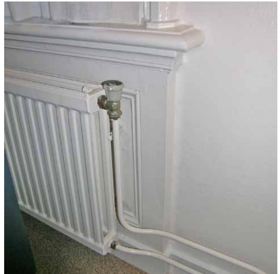
Afbeelding 41. Zicht op de onderzijde van één van de vensters in bouwdeel G. De vensters zijn voorzien van geprofileerde architraaflijsten die door middel van houten neuten aansluiten op de vensterbanken. Ter hoogte van de borstwering zijn lambriseringen met bossingpanelen aangebracht.
