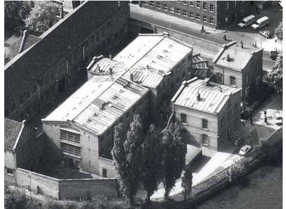
Afbeelding 116. Op deze luchtfoto uit mei 1978 is duidelijk te zien dat zowel de bouwdelen F als G nog een zinken roevendak bezaten. Het dak van bouwdeel H was reeds vervangen door bitumen. Foto: Collectie Beeldbank Leeuwarden, documentnr.: FDLUCHTFB007.
