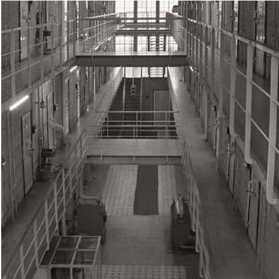
Afbeelding 43. Overzicht van de cellenhal in 1959. Deze afbeelding geeft een beeld van de oorspronkelijke uitstraling van de cellenhal. De tegelvloer en hardstenen platen op de begane grond, de balustrades rond de galerijen en de fonteintjes behoren tot het ontwerp van W.C. Metzelaar. De wanden van de cellenhal waren uitgevoerd in schoon metselwerk met accenten in rode baksteen. Foto: Collectie Beeldbank Leeuwarden, documentnr.: BDO0421
