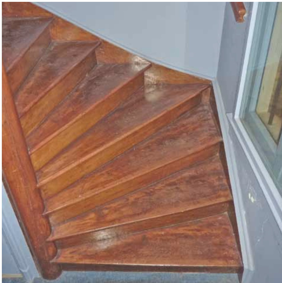
Afbeelding 150. Zicht op de onderzijde van de uit de bouwtijd daterende wenteltrap (1870) in bouwdeel B.
