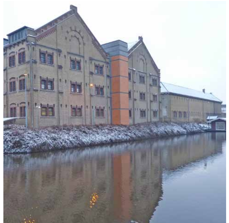
Afbeelding 187. Overzicht van de zuidzijde van het complex in 2009. De lift werd in 1997 toegevoegd.
