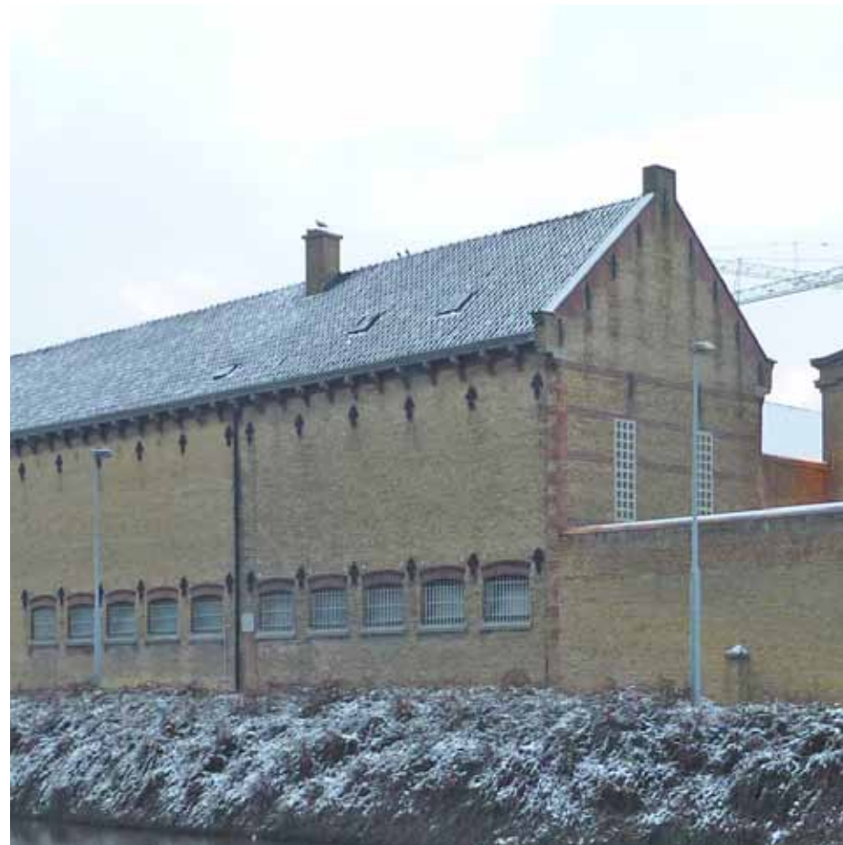
Afbeelding 62. Overzicht van de oost- en zuidgevel van de bouwdelen D en E in januari 2010. De gemetselde schoorsteen op het dakvlak ter plaatse van de scheidingswand tussen de bouwdelen D en E werd in 1974 gerealiseerd.
