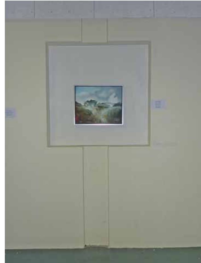
Afbeelding 120. Zicht op één van de sparingen in de scheidingswanden van bouwdeel C. In deze sparingen werden de diverse installatievoorzieningen doorgevoerd.
