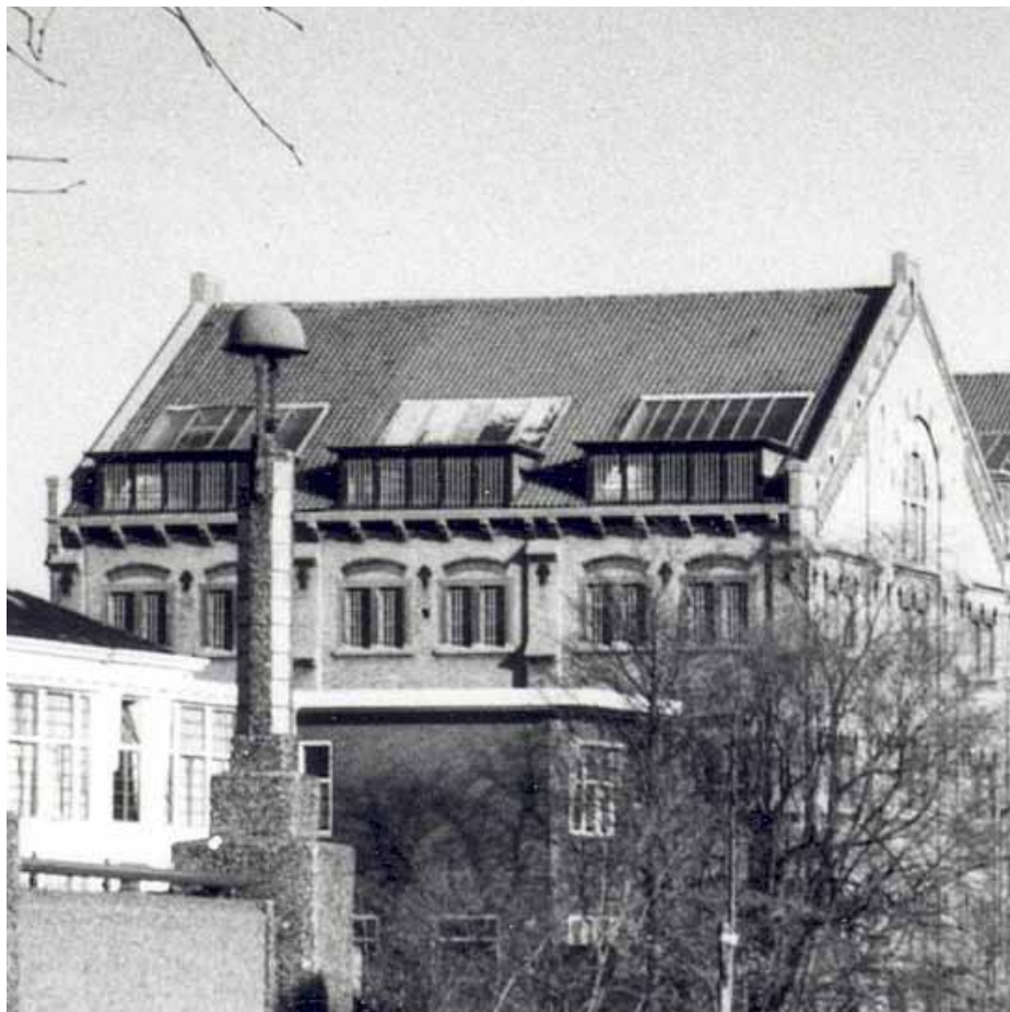
Afbeelding 113. Zicht op het westelijke dakvlak van bouwdeel C in 1960. Boven de dakkapellen werden halverwege de jaren 1950 dakvensters aangebracht, waarbij waarschijnlijk eveneens de vlakke Friese pannen werden vervangen door Romaanse pannen. Foto: Collectie Beeldbank Leeuwarden, inventarisnr.: FDPOTMBGA009
