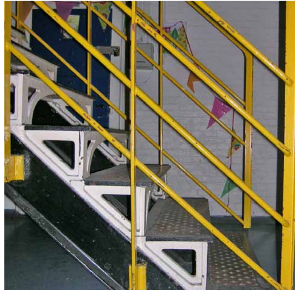
Afbeelding 157. Zijaanzicht van één van de trappen in de cellenhal van bouwdeel I.
