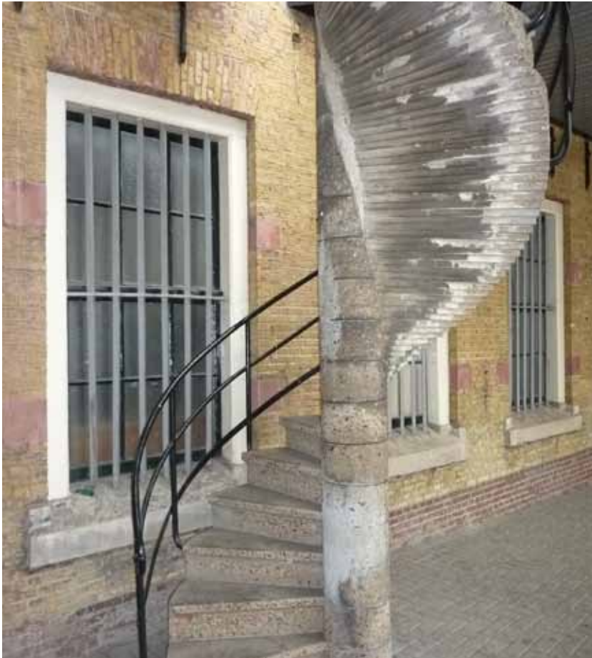
Afbeelding 160. Linkerzijde van de achtergevel van bouwdeel A ter hoogte van de begane grond met de betonnen trap naar de toegang van de kerk op de eerste verdieping (1959). De trap was oorspronkelijk een buitentrap en werd 1991 overkapt.
