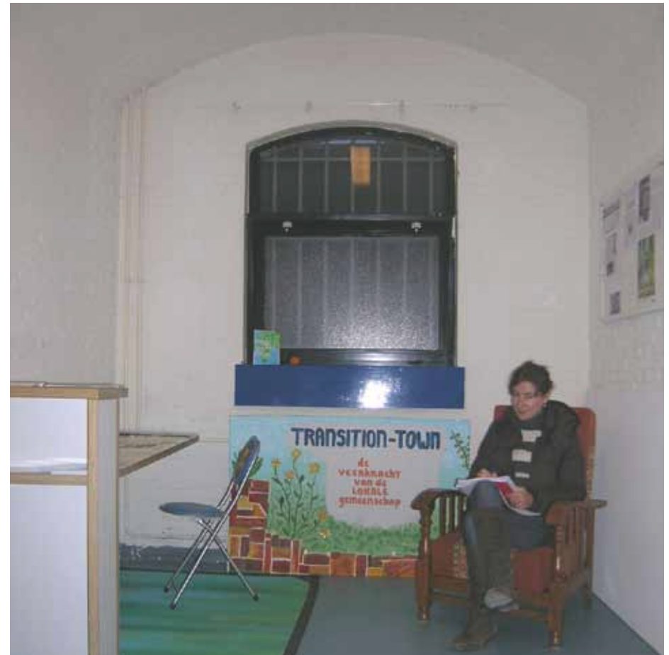
Afbeelding 88. Overzicht van één van de individuele cellen gezien richting de buitengevel. Het plafond wordt gevormd door een halfsteens segmentbooggewelf.
