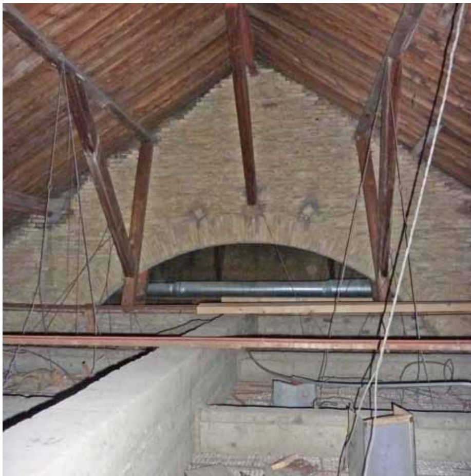
Afbeelding 97. Overzicht van de westelijke kap gezien richting het zuiden. In plaats van spanten zijn de bouwmuren tot in de zolderruimten doorgetrokken, waarop de gordingen met muurstijlen en korbeels zijn opgelegd. Blijkens een reeks dichtgezette balkgaten, waren de twee afgeschoorde gordingen oorspronkelijk onder 45 graden op de gevel afgeschoord.
