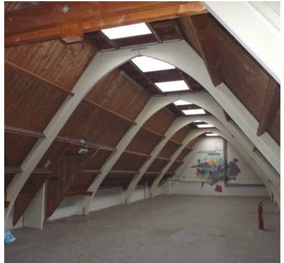
Afbeelding 94. Zicht in de zolderruimte van bouwdeel A met de afgeronde spanten van de sportzaal (1959).
