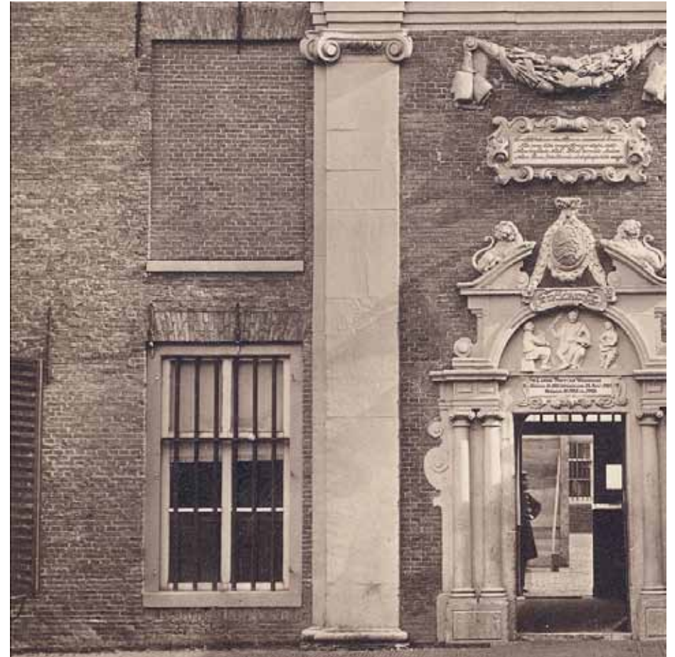
Afbeelding 22. Detail van de voorgaande afbeelding. De architectuur van de in 1874 gesloopte vleugels van het tuchthuis vertoont gelijkenissen met de noordgevel van bouwdeel A. Mogelijk werden gelijktijdig met de bouw van bouwdeel A - kort voor 1822 - de vensters van deze vleugel vervangen danwel gewijzigd tot blindnissen (vergelijk met Afbeelding 18).
