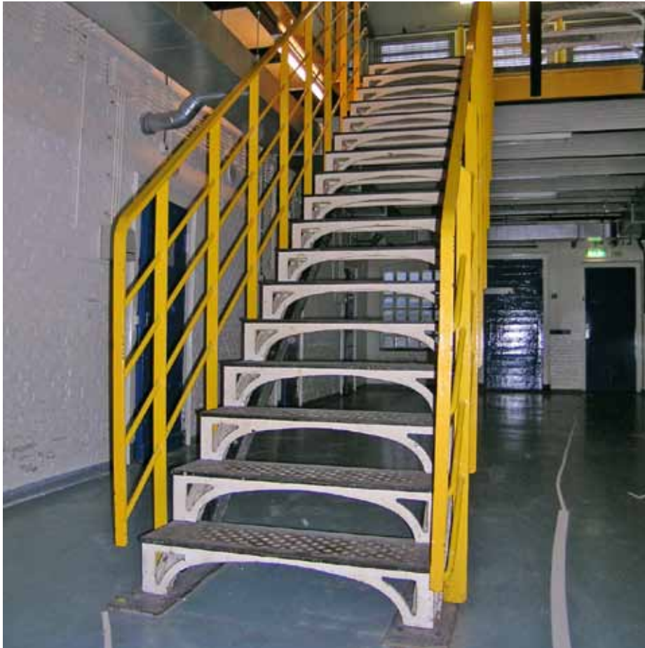
Afbeelding 156. Onderzijde van één van de trappen in de cellenhal van bouwdeel F. De trappen (1891) bestaan uit op stalen I-profielen bevestigde gegoten ijzeren driehoekige opengewerkte segmenten. De secundaire (1988) leuningen bestaan uit verticale stalen strips met onder de T-vormige handlijst een viertal horizontale ronde staven (rond 2 cm). Oorspronkelijk waren hier leuningen met slechts 2 horizontale tussenstaven aanwezig.
