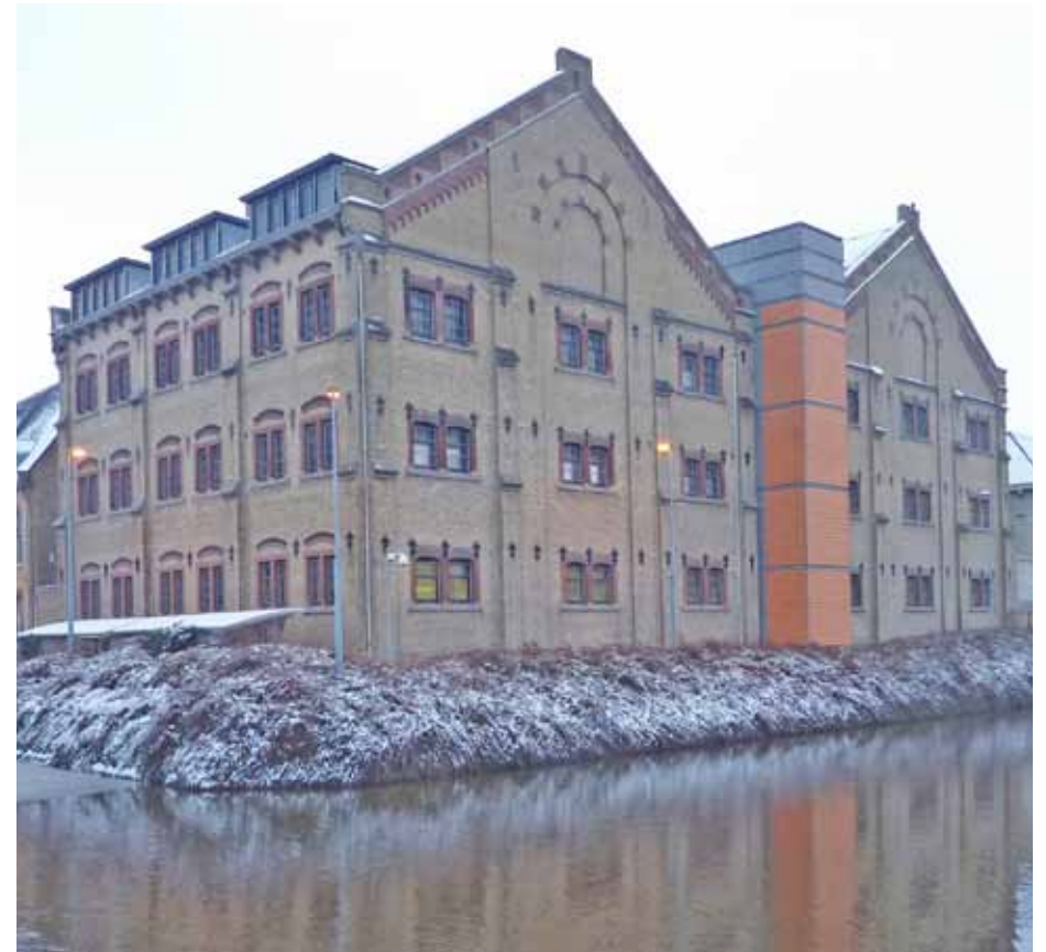
Afbeelding 73. Overzicht van de zuid- en westgevel van bouwdeel C. Rechts is de contrasterende liftschacht uit 1997 naar ontwerp van Ir. Vegter zichtbaar.
