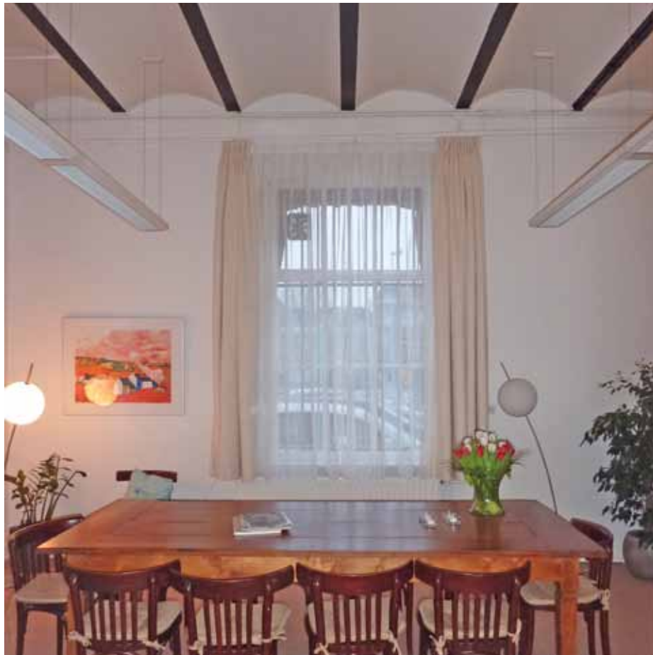
Afbeelding 89. Overzicht van één van de ruimten op de begane grond van bouwdeel G. De vloeren van dit bouwdeel bestaan uit troggewelven op INP-liggers.
