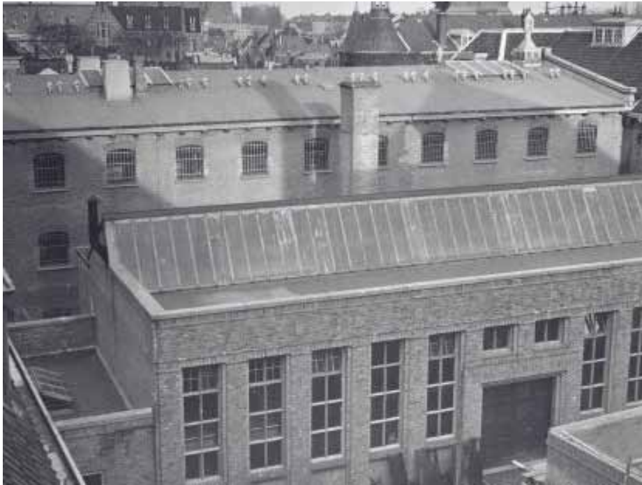
Afbeelding 115. Overzicht van de timmerwerkplaats ter plaatse van de voormalige luchtplaatsen aan de zuidzijde van bouwdeel I in 1948, direct na het gereedkomen van de bouw. Het roevendak van bouwdeel I heeft hier reeds plaatsgemaakt voor bitumen, waarbij de zinken ventilatiekappen van de cellen behouden bleven. De timmerwerkplaats bezat - net als bouwdeel J - een bitumen dakbedekking. Foto: Collectie Beeldbank Leeuwarden, documentnr.: FDBLHSPLA032
