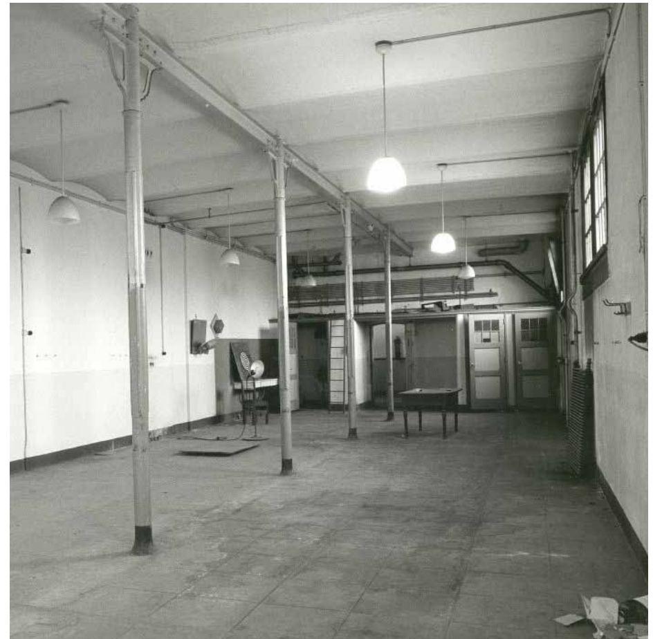
Afbeelding 81. Overzicht van één van de ruimten in bouwdeel C, gezien richting het westen in 1959.
