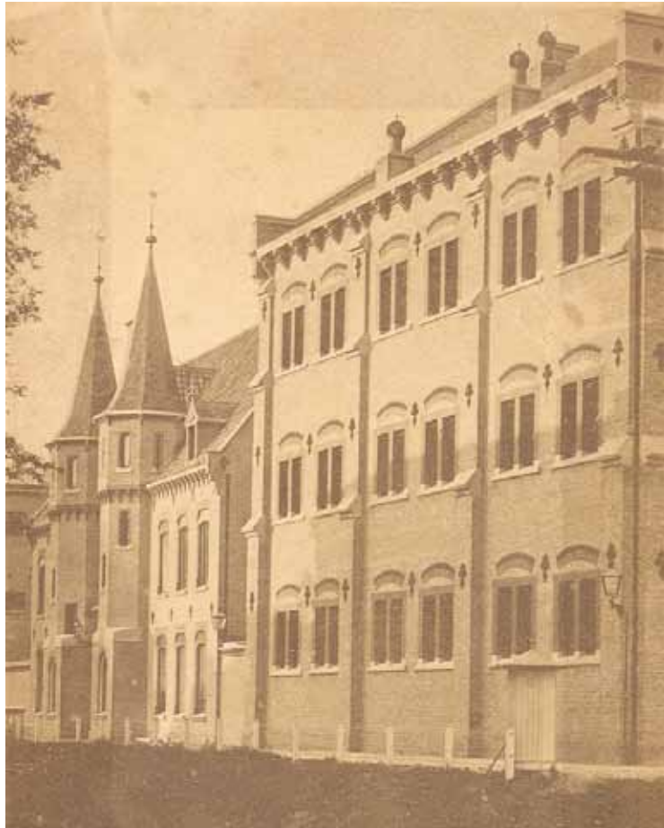
Afbeelding 29. Zicht op de westgevel van bouwdeel C net voor of na de oplegging - rechts boven zijn nog enkele steigerplanken zichtbaar.
