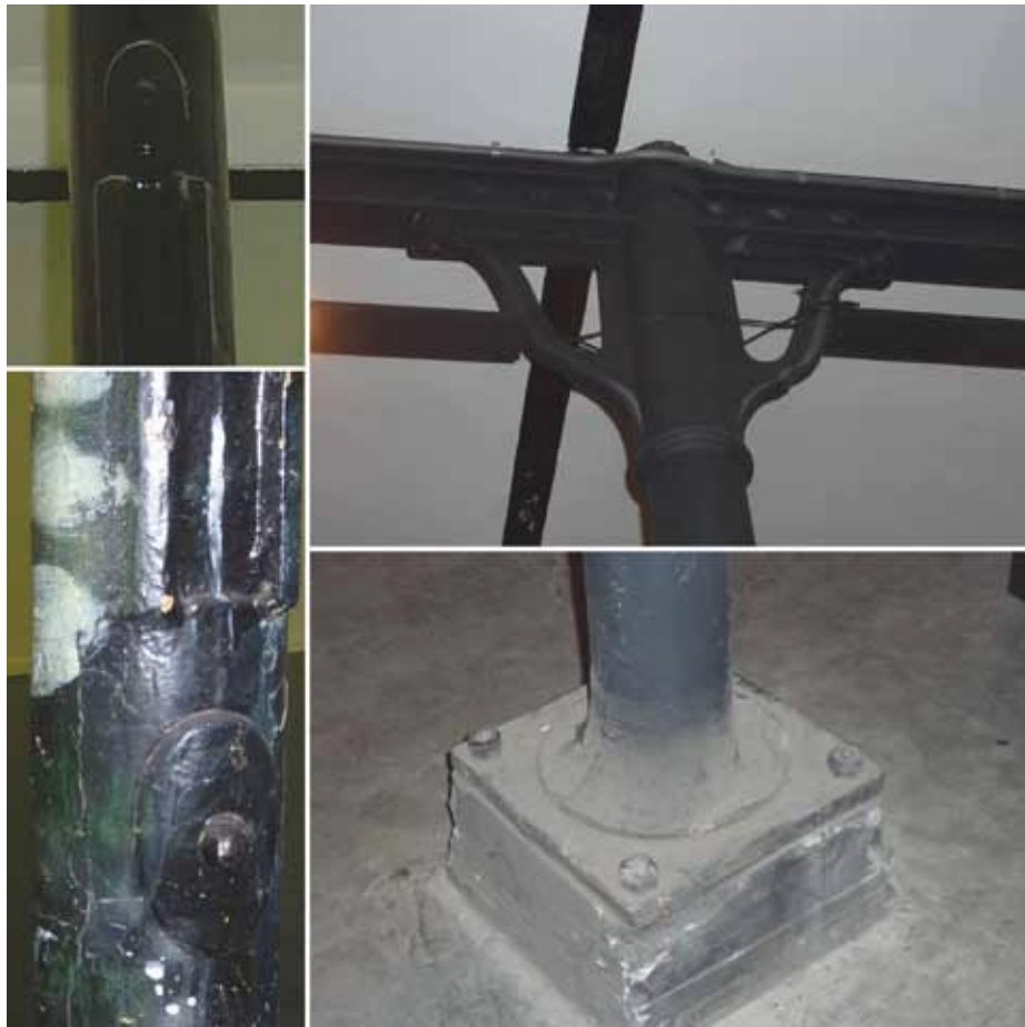
Afbeelding 80. Compilatie van afbeeldingen van één van de kolommen in bouwdeel C. (1870). De kolommen zijn voorzien van strips ten einde eventuele tussenwanden en schotten te kunnen plaatsen. Blijkens de bouwtekeningen waren oorspronkelijk hardstenen platen als afscheidingen in de alkoofruimten aangebracht (1870). Deze indeling was op de begane grond reeds vóór 1894 verdwenen.
