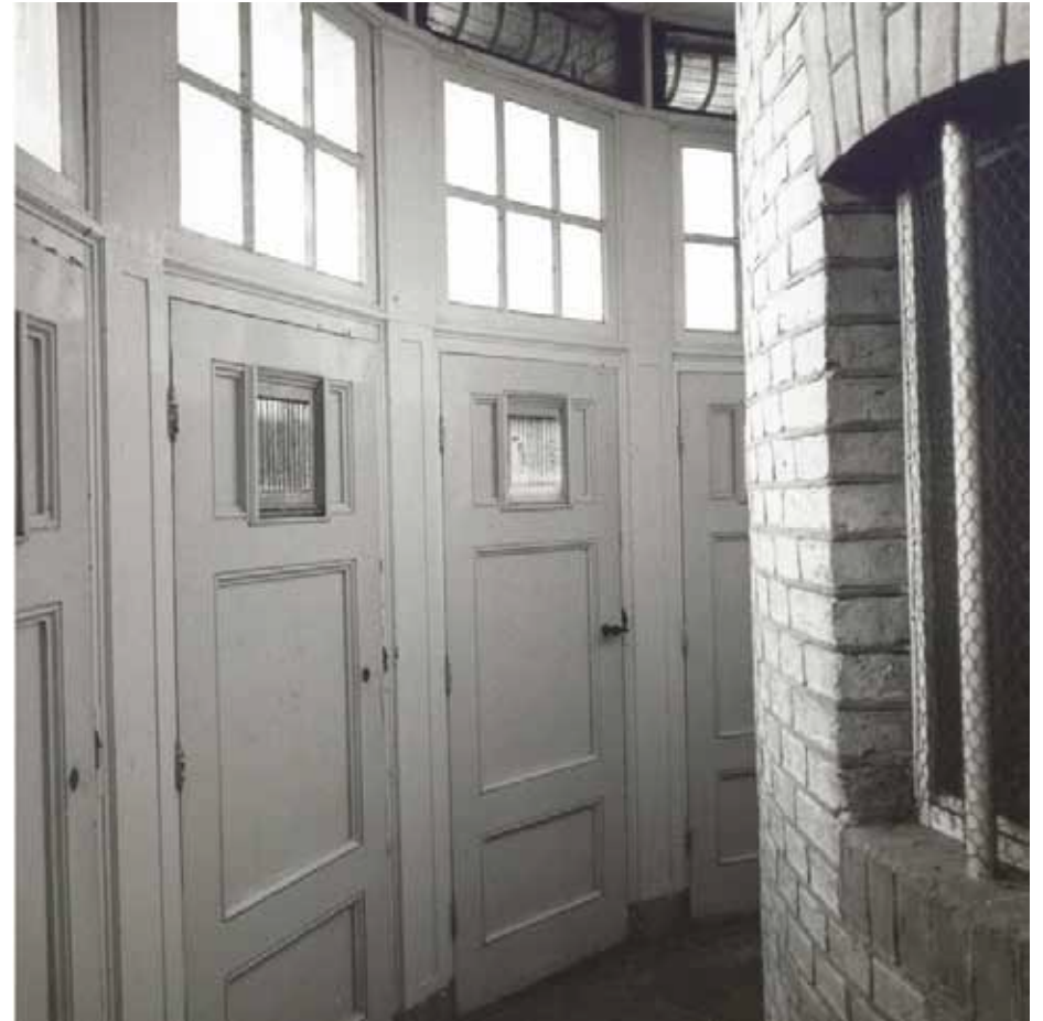
Afbeelding 39. Overzicht van de voorruimte van de wandelplaatsen aan de noordzijde van bouwdeel F gezien richting het oosten in februari 1983. Aan de linker zijde is de gesegmenteerde pui met daarin de paneeldeuren met 6-ruits bovenlichten zichtbaar. Foto: Collectie Beeldbank Leeuwarden, documentnr.: FDBLHSPLB022
