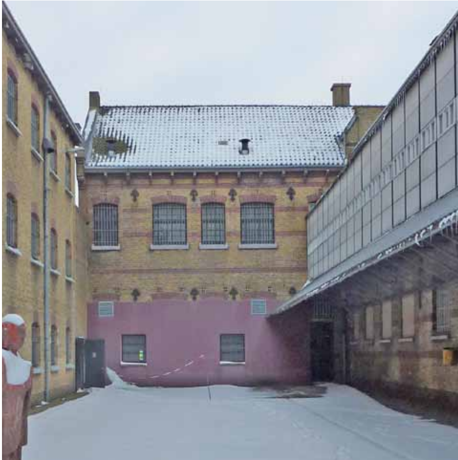
Afbeelding 65. Overzicht van de noordgevel van de oostelijke uitbouw van bouwdeel E. De loopbrug aan de rechter zijde was onderdeel van de plannen van bureau irs. Vegter om de routing van het complex te verbeteren. De in deze fase dichtgezette openingen werden in een aubergine kleur gesausd, nadat het muurwerk al dan niet werd gepleisterd.
