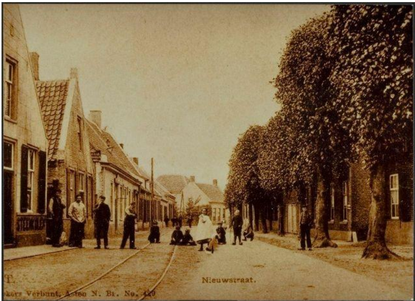
Derde pand links van 1849-1896 de marechausseekazerne aan de toenmalige Haageijk te Gemert
